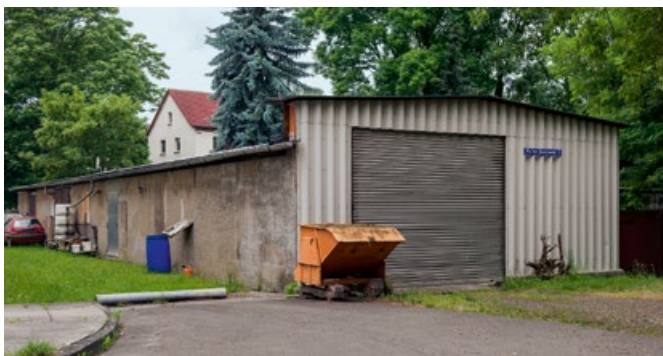
Steinbaracke des früheren Wohnlagers I nördlich des ehemaligen Vorwerks Aspe
