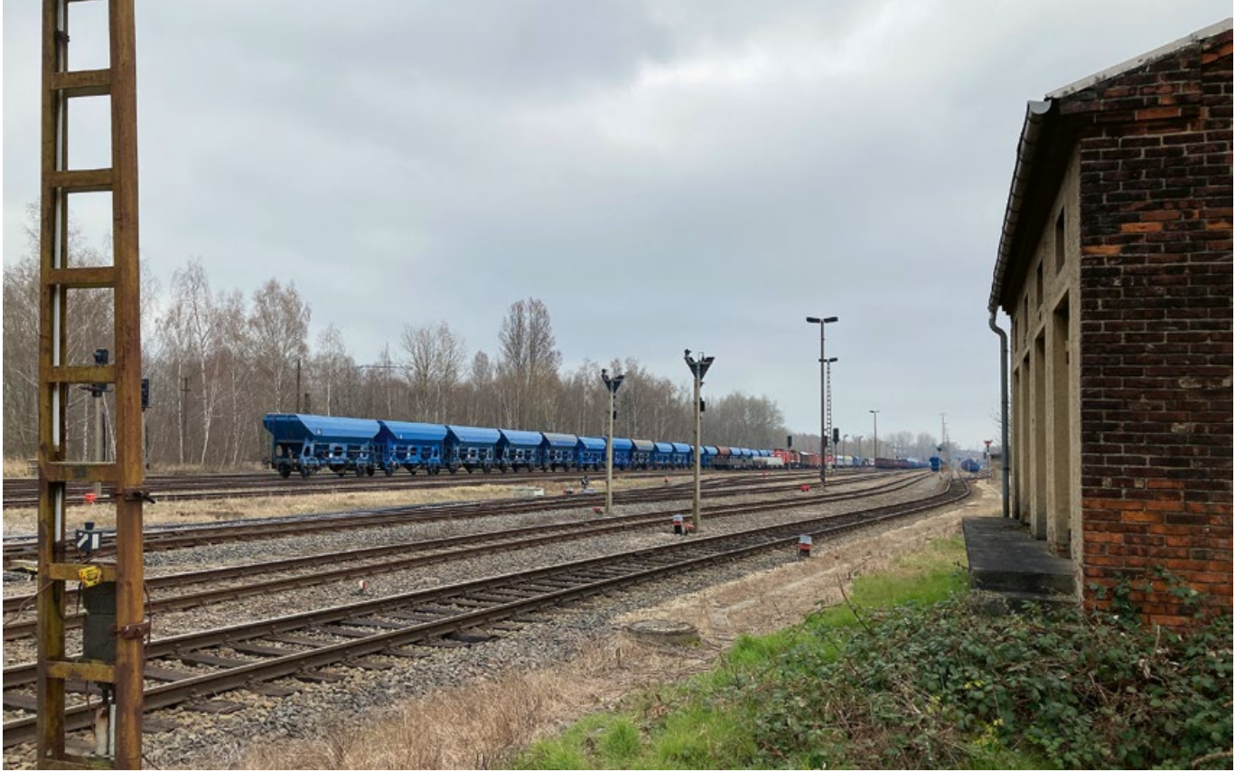
Technische Infrastruktur: Güterbahnhof Espenhain
