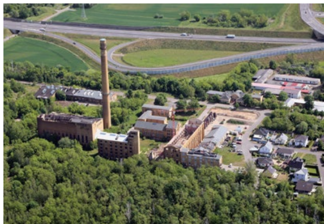
Die aktuelle Schrägluftaufnahme von Westen zeigt den erhaltenen Kern der Fabrikanlage. Ohne Dach und im Umbau befindet sich der Trocken-dienst. Eigenheime markieren den einstigen Bereich der Brikettverladung.
