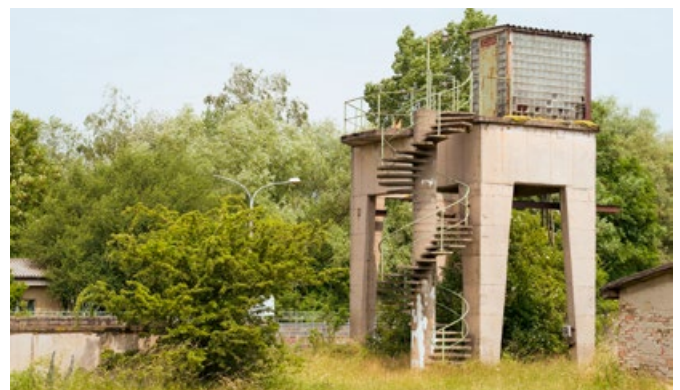
Blick in Richtung Westen auf den Beobachtungsturm der Stapelbecken
