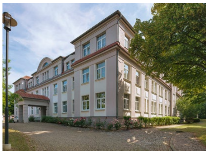
Das Verwaltungsgebäude von der südlichen Auffahrt blickend
