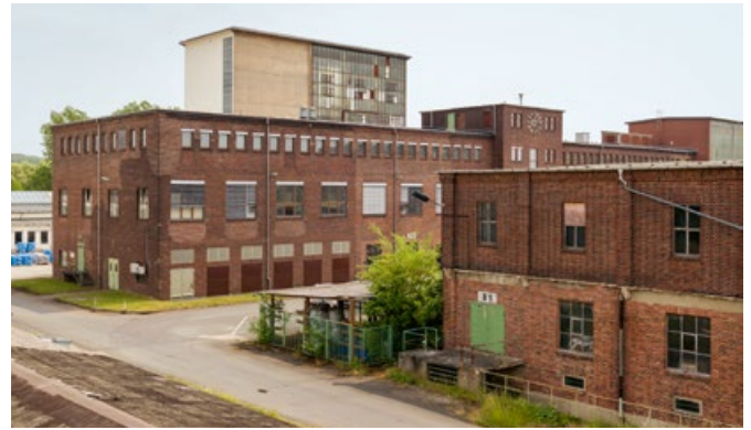
Blick von Südwesten über die Formmassenproduktion auf das Mühlengebäude mit Glasvorhang
