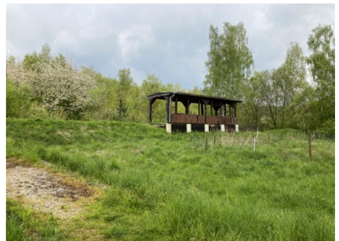
Blick von Südosten auf den Unterstand des Haltepunkts
