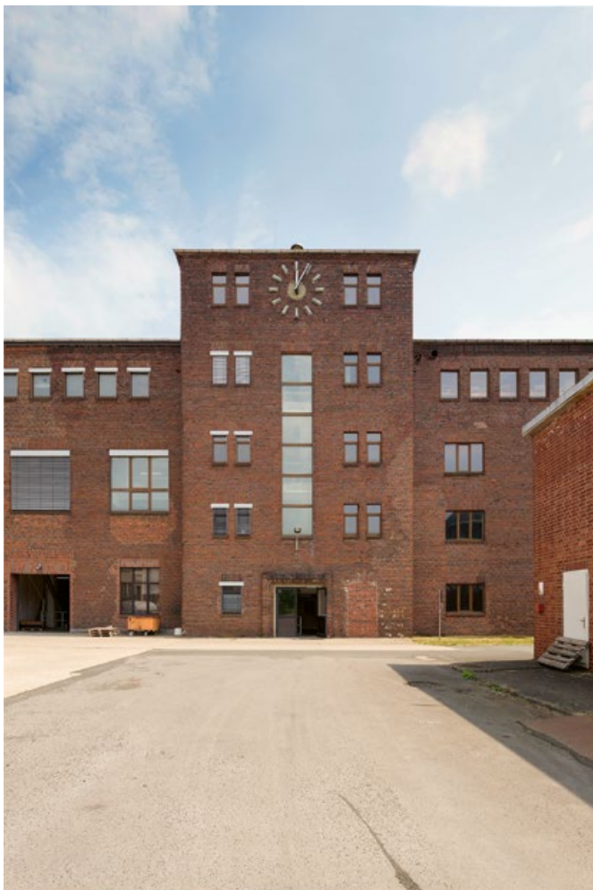
Blick von Süden auf das Treppenhaus der Formmassenproduktion mit markanter Turmuhr
