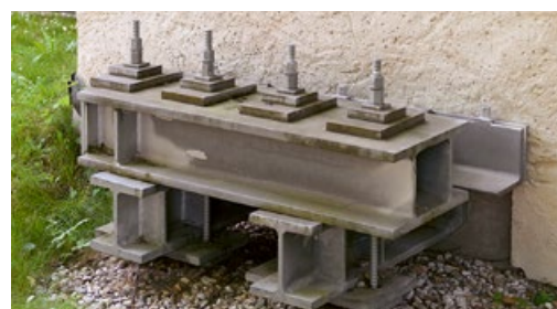
Ein Teil der Tragekonstruktion zeugt von der Translozierung aus Heuersdorf nach Borna.
