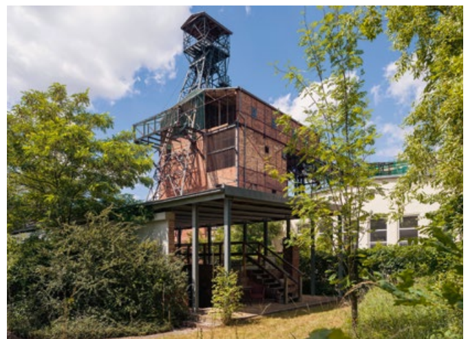
Blick von Südosten über das Kesselhaus auf das Schachtgebäude
