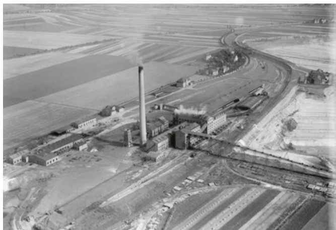
Das Luftbild von 1931 zeigt die Brikettfabrik von Nordwesten. Der Nassdienst wurde direkt aus dem Tagebau Witznitz I beliefert. Das alte Kesselhaus existiert nicht mehr.
