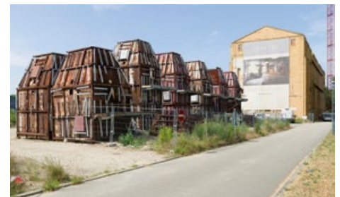
Wrasenschlote des Trockendienstgebäudes
