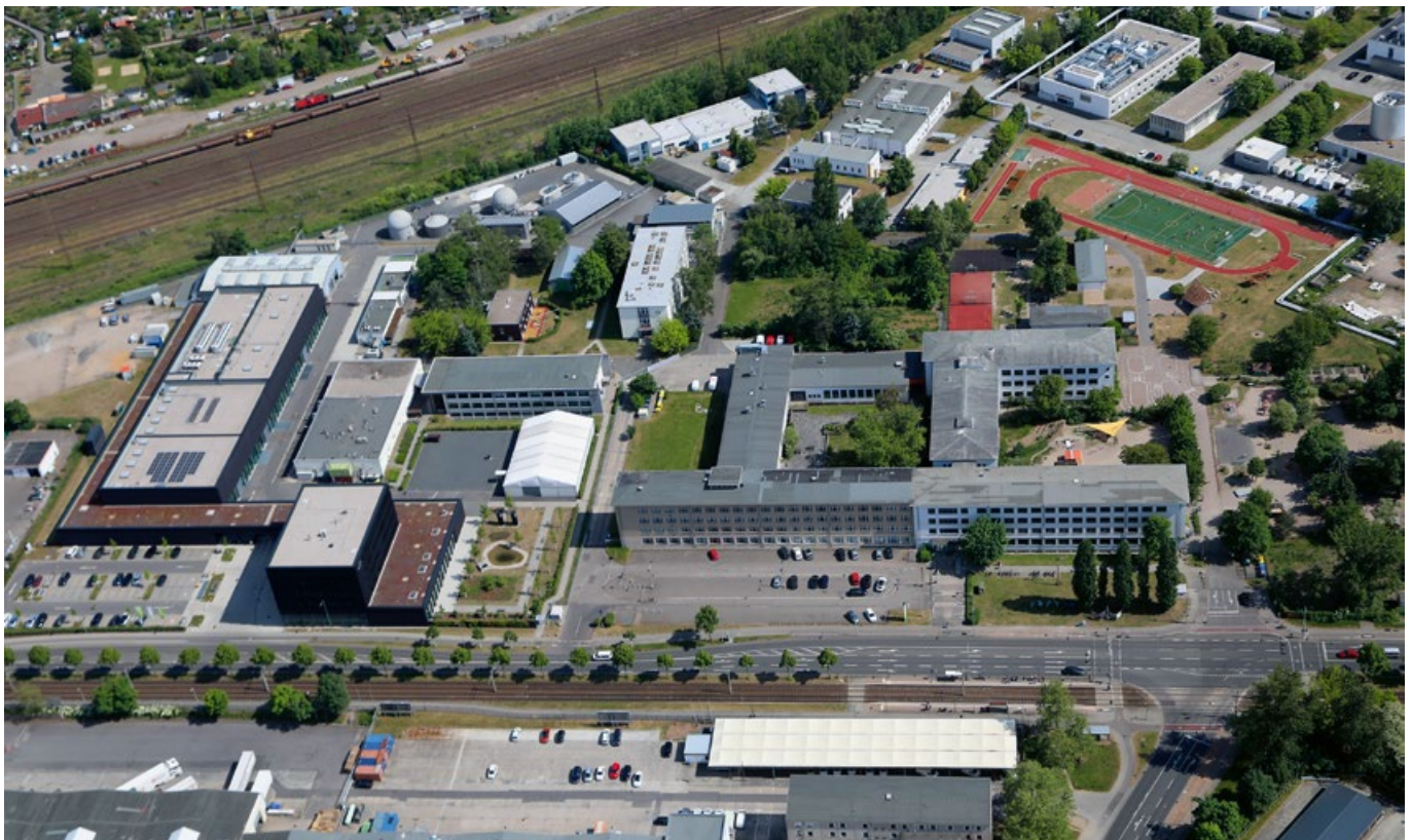
Luftbildaufnahme des Institutsgeländes zwischen Torgauer Straße und Bahnlinie aus nordwestlicher Richtung, zentraler Gebäudekomplex im rechten Bildvordergrund, spätere Erweiterungsbauten links (heute integriert in eine moderne Forschungseinrichtung)
