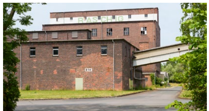
Blick von Osten über den Tarnbau des Phenoltanklagers auf die Destillation mit RASCHIG-Schriftzug
