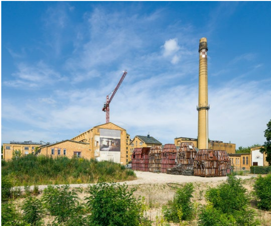
v.l.n.r.: Kühlhaus, Pressenhaus, Trockendienst, Nassdienst, Maschinenhaus, Kesselhaus, Schornstein, Schaltwarte und die davorliegenden und entmantelten Wrasenschlote des Trockendienstes
