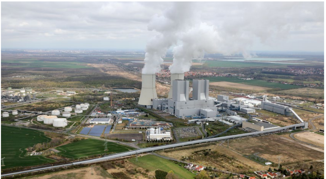
Schrägluftbild des Kraftwerks von Süden mit der 14 km langen Bandanlage zur Rohkohleversorgung aus dem Tagebau Vereinigtes Schleenhain
