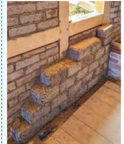
Sanierung einer Fachwerkwand mit Lehmziegeln
