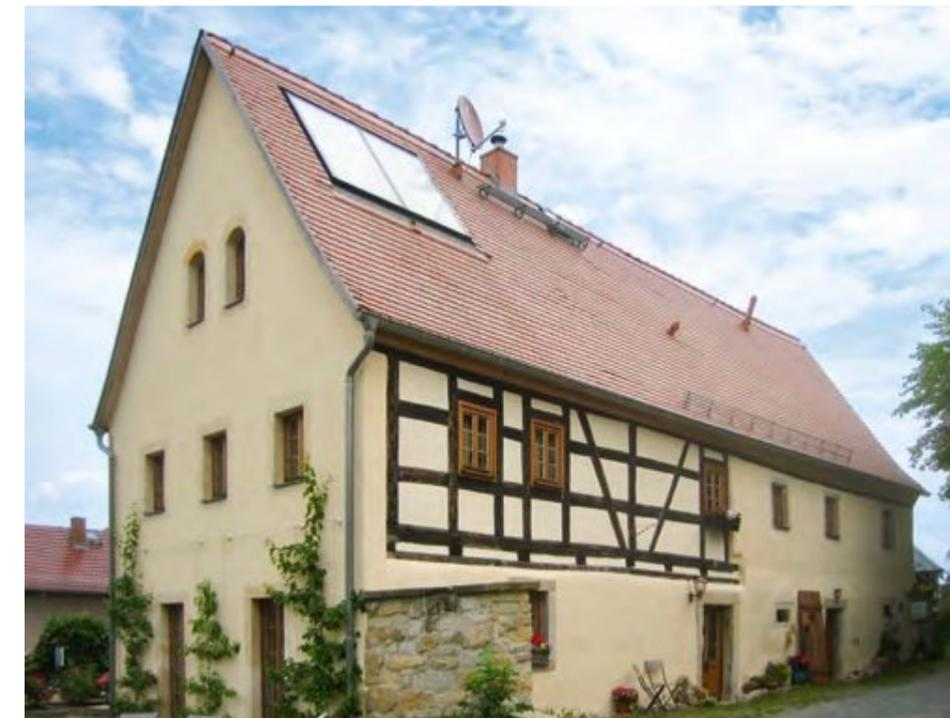
Das Wohnstallhaus befindet sich im Ensemble aus Pfarrkirche, Pfarrhof und Schlossanlage im Kern des Dorfes. Die kleinflächige Solarthermie wurde in die Dachfläche zum Pfarrhaus hin integriert und überprägt das Ziegeldach nicht.
