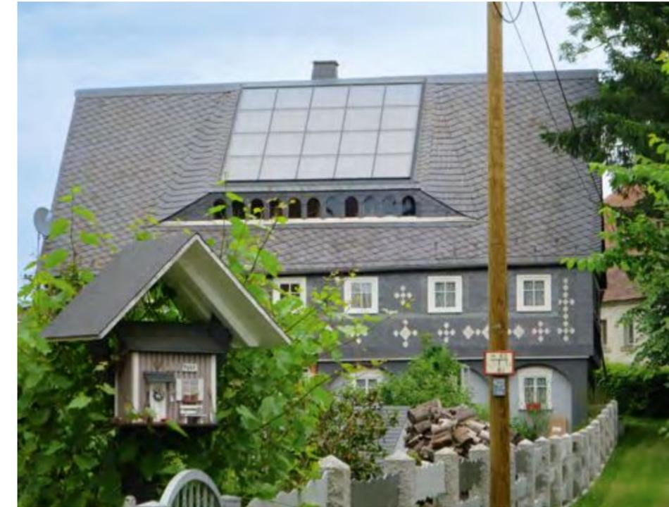
Das Umgebendehaus wurde Ende des 18. Jahrhunderts in Tallage am Ortsrand errichtet. Im Rahmen der Neueindeckung des Daches mit Schiefer wurde auf der zentralen Gaube der ortszugewandten Dachfläche eine integrierte Solaranlage ausgeführt.
