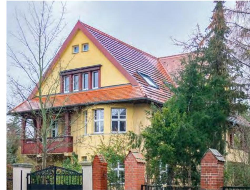
Diese Villa steht in einem städtischen Villengebiet. In die rote keramische Dachdeckung der Südseite wurde eine Photovoltaikanlage integriert. Die Höhe der einzelnen, länglichen Module entspricht der Ziegelhöhe auf dieser Dachfläche; die anderen Dachflächen haben weiterhin die noch kleinteiligere Biberschwanzeindeckung. Die Module sind farblich den roten Ziegeln angepasst. So bleibt der Eindruck eines kleinteilig gegliederten Daches erhalten.
