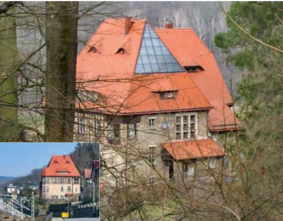
Das repräsentative Landhaus aus dem frühen 20. Jahrhundert steht in Hanglage über dem Flusstal. Die Schauseiten sind zur Straße ausgerichtet. Daher wurde die Photovoltaikanlage auf der Gebäuderückseite in klar umrissener Form in das Dach integriert. Trotz des Farbkontrastes stellt die Anlage aufgrund der geringen Einsehbarkeit aus dem öffentlichen Raum eine denkmalverträgliche Lösung dar.
