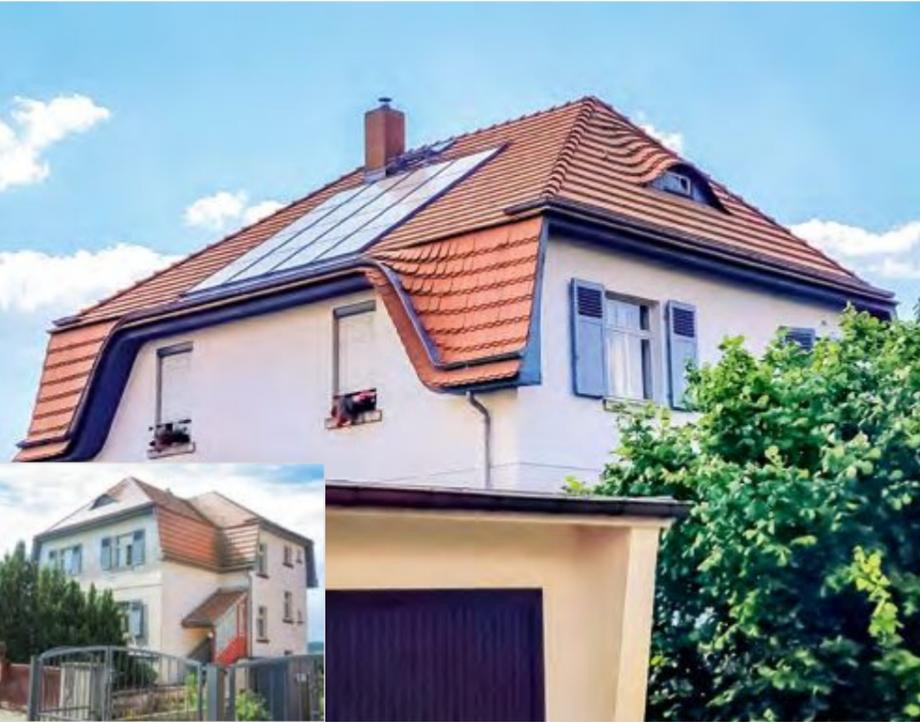
Das zweigeschossige, landhausartige Mietshaus steht in Hanglage und wurde um 1910 errichtet. Das mit Biberschwanzziegeln gedeckte Mansarddach mit Halbwalme ist zur Straßenseite mit einer Fledermausgaube belebt. Die Photovoltaikanlage wurde dachintegriert auf der am wenigsten gestalteten Gebäudeseite über der breiten Gaube ausgeführt.
