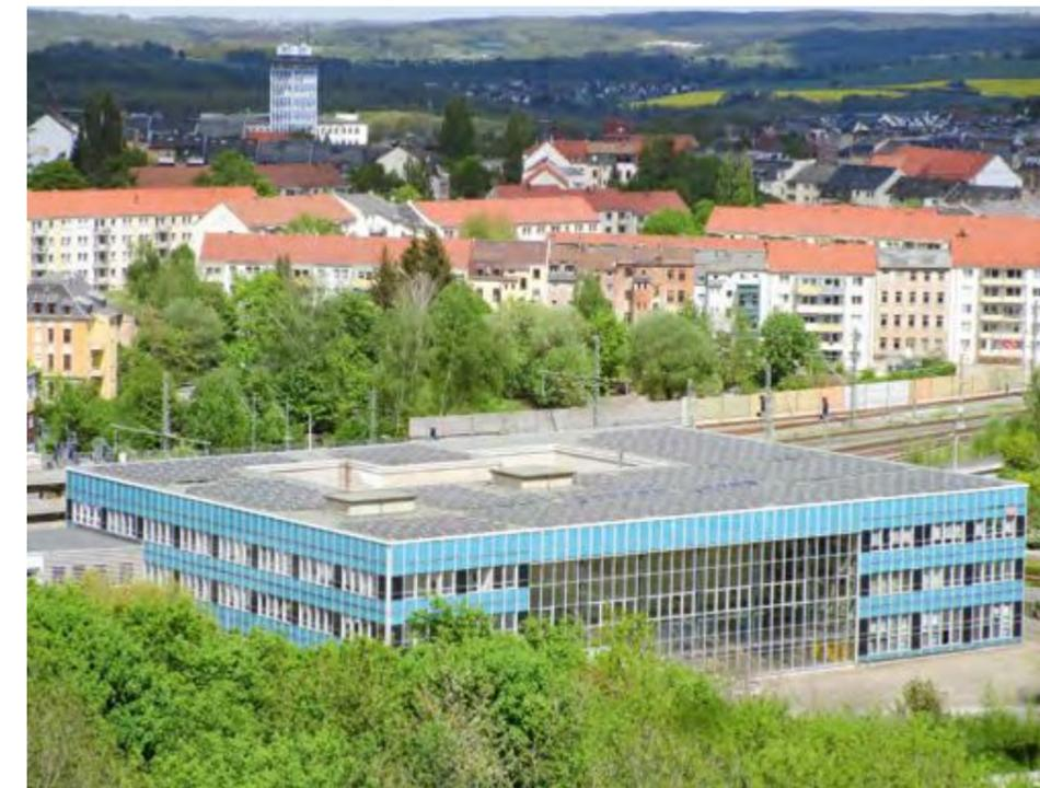
Auf dem nachkriegsmodernen Flachdachbau sind die leicht aufgeständerten Module hinter der Attika aus dem Straßenraum nicht sichtbar. Auch in der Aufsicht treten sie nicht in Konkurrenz zu der vorgehängten Rasterfassade des Gebäudes. Bei modernen Flachdachbauten ist die Integration von Photovoltaikanlagen gestalterisch zumeist einfach möglich, sofern die statischen Gegebenheiten dies zulassen.
