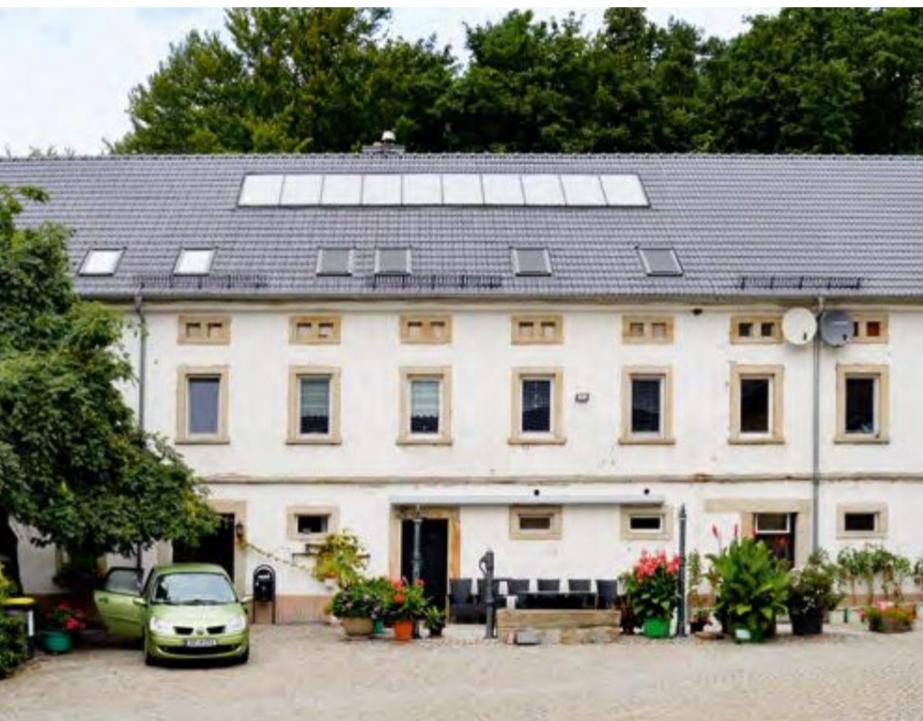
Das stattliche Wohnstallhaus eines Bauernhofes aus dem späten 19. Jahrhundert erhielt eine Solaranlage, die durch ihre im Vergleich zum Dach geringe Größe und klare Geometrie als Band an sich nicht störend in Erscheinung tritt. Allerdings zeigt das Beispiel, dass durch eine Häufung technischer Anlagen (Dachfenster, Schneefang, Photovoltaikanlage, Satellitenschüssel, Markise) schnell die Grenze des optisch noch Verträglichen erreicht wird.
