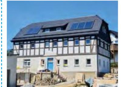
Dachintegrierte Solarthermieanlage mit Flachkollektoren
