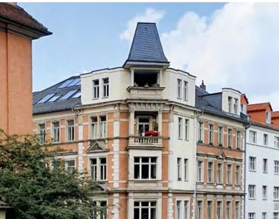
Das gründerzeitliche Eckhaus in markanter städtebaulicher Lage beeindruckt durch seine reiche Fassadengestaltung und den hohen Eckerker mit turmartiger Bekrönung. Die Photovoltaikanlage wurde in die dunkle Dachfläche integriert und fällt aus der Betrachterperspektive kaum auf.
