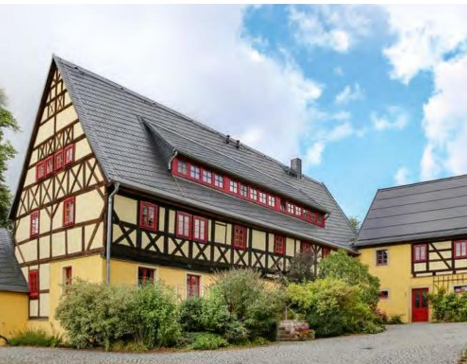
Auf dem Dach des Seitengebäudes eines von 1660 stammenden Bauernhofes wurde eine dachfüllende Photovoltaikanlage errichtet. Während das Wohnstallhaus eine Schieferdeckung erhielt, wurde das Nebengebäude mit einer farblich dem Schiefer angepassten Anlage eingedeckt. Dadurch konnte die Dominanz der großen Anlage im Kontext des historischen Hofes wesentlich abgemildert werden.
