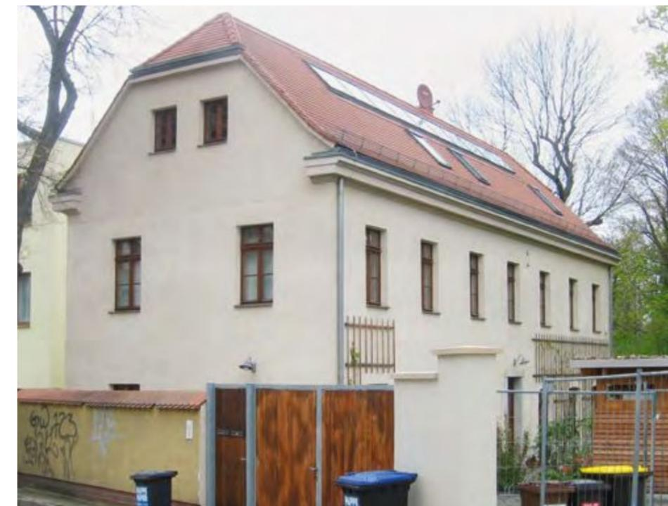
Das ländliche Wohnhaus ist ein zweigeschossiger Putzbau aus dem 19. Jahrhundert. Die Solaranlage auf dem Krüppelwalmdach wurde dachintegriert ausgeführt und beschränkt sich auf einen schmalen Streifen unterhalb des Firstes. Das rote Ziegeldach behält dadurch seine für das Gebäude prägende Bedeutung.
