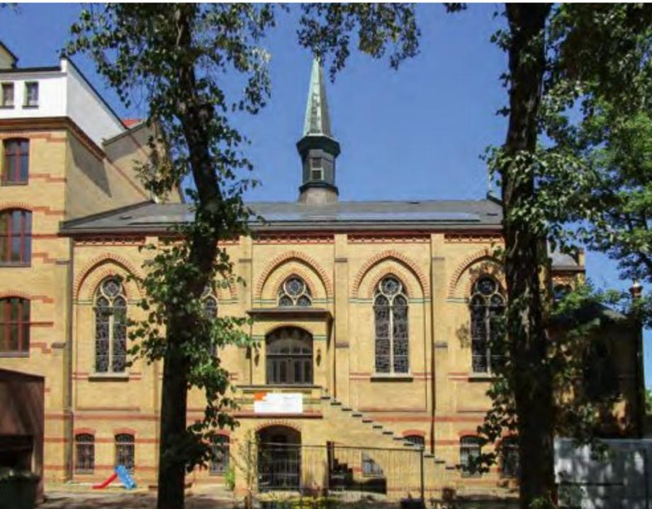
Der gelbe Backsteinbau im neogotischen Stil wurde 1892/93 für eine katholische Kirchgemeinde errichtet. Mit der Sanierung des Gebäudes im Jahr 2003 wurde auf das schwarze Schieferdach ein schmales Band von Photovoltaikmodulen aufgebracht. Aufgrund der begrenzten Größe und farblichen Anpassung fügt sich die Anlage in das Kirchendach ein, ohne den Gesamtbau zu dominieren.
