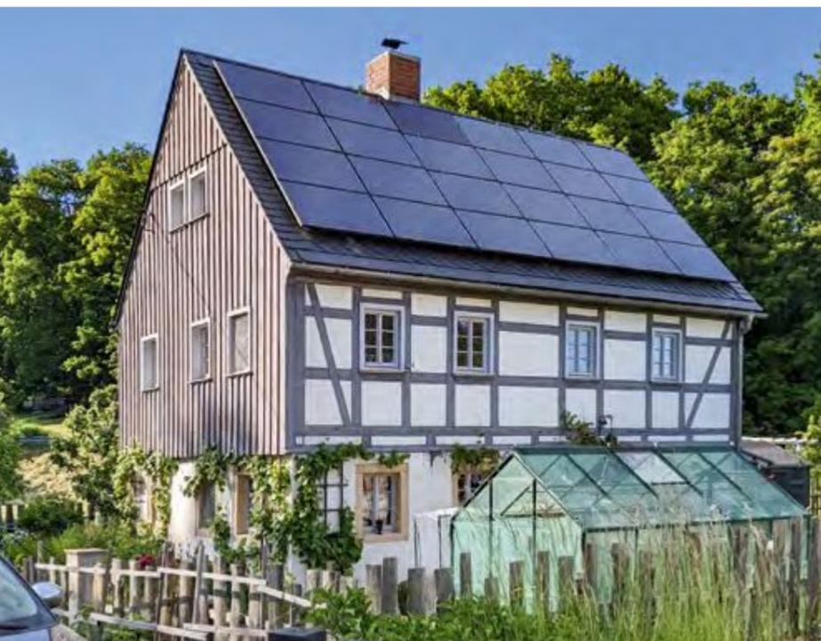
Auf dem Schieferdach des kleinen Wohnhauses wurde die PV-Anlage errichtet. Die regional-authentische Dacheindeckung wurde bewahrt und ist an den Rändern unter der aufgelegten technischen Anlage sichtbar. Durch die klar umrissene Geometrie und die dunkle Farbigkeit ist der Kontrast zwischen kleinteiliger Fassadengestaltung in handwerklicher Detailausbildung und technischer Anlage erträglich.
