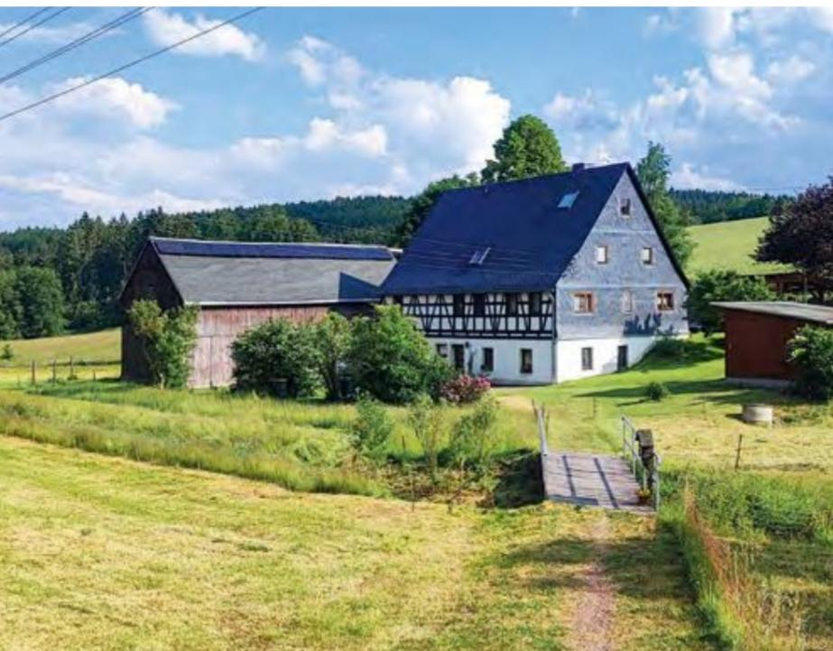
Bei diesem Bauernhof und ehemaligen Wassermühlenstandort in bildprägender Lage im Auenbereich wurde das Seitengebäude mit Photovoltaikmodulen belegt. Das mäßig geneigte Satteldach wird vom steileren Dach des Hauptgebäudes und von den mächtigen rückwärtigen Hofbäumen teilweise verschattet. Um die malerische Ansicht der Hofanlage möglichst wenig zu beeinträchtigen, einigte man sich auf eine beidseitige Belegung als schmales Band beziehungsweise Streifen mit liegenden Modulen.
