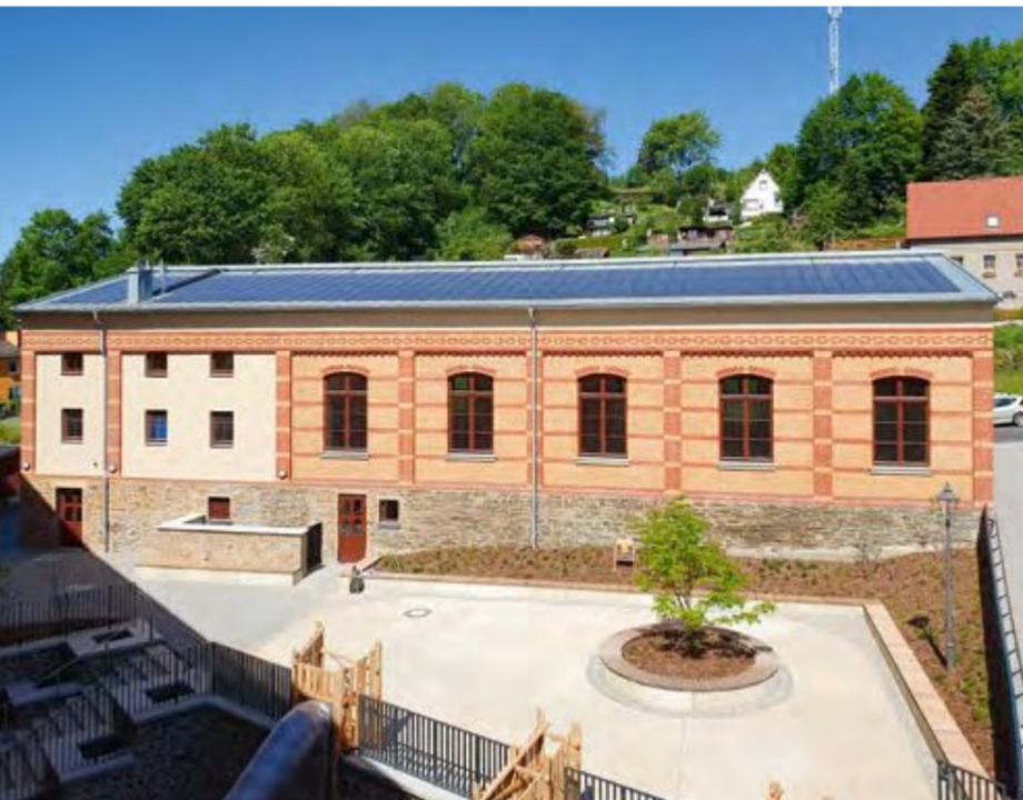
Die Turnhalle der Grundschule erhielt bei den Sanierungsmaßnahmen 2022 eine neue Dachkonstruktion. Aufgrund der Dachneigung entschied man sich für eine Stehfalzdeckung, die mit ihren schmalen Scharenbreiten kompatibel mit einem speziellen Modulsystem ist. Dieses fügt sich aufgrund seiner schlanken, kleinteiligen Ausführung gelungen in das Dach und die Ansicht der Turnhalle ein. Der direkte, unverstellte Blick auf das Dach ergibt sich nur von den Klassenräumen der Schule aus.
