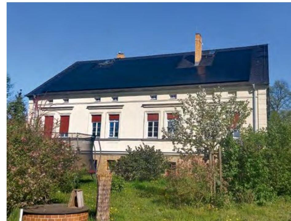
Das Pfarrhaus in Ortsrandlage wurde mit einer Anlage aus dunklen, randlosen Standardmodulen als Aufdachvariante versehen. Auf dem dunklen Dach treten die Module nur wenig in Erscheinung. Für die halböffentliche Nutzung mit hohem Energiebedarf ist die solare Unterstützung ein wesentlicher Faktor zur Kostensenkung.
