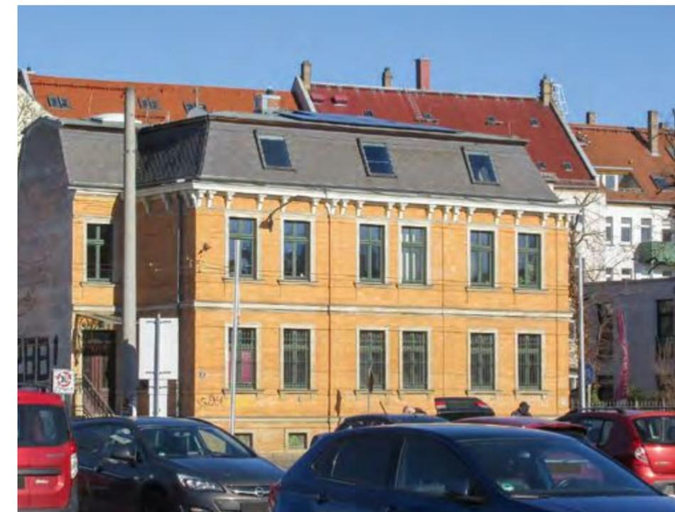
Das zweigeschossige Wohnhaus wurde um 1900 mit Klinkerfassade und Sandsteingliederungen erbaut. Nur auf dem flach geneigten, oberen Bereich des Mansarddaches kam aus denkmalfachlicher Sicht eine Photovoltaikanlage infrage. Da die Solarmodule flach aufgelegt sind, tritt die Anlage kaum in Erscheinung.
