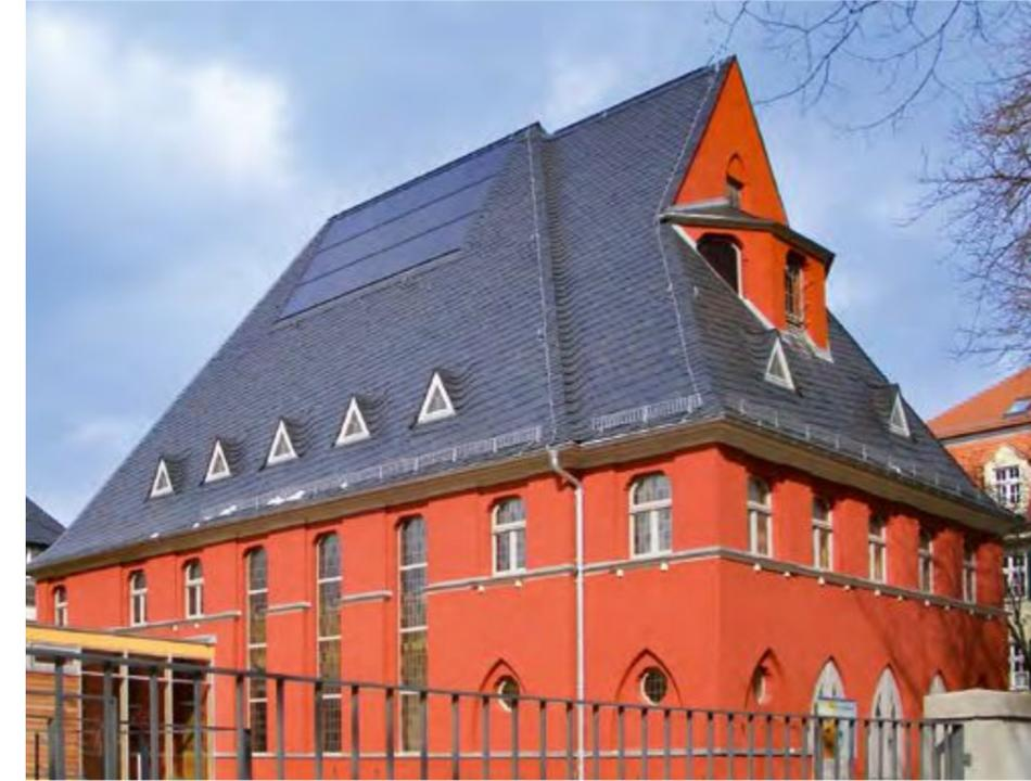
Der 1922 errichtete Kirchenbau in expressionistischer Formensprache steht mit der Schmalseite zur Straße. Bei der Neueindeckung des Daches mit Naturschiefer wurde über dem Kirchsaal eine rechteckige Fläche PV-Module in das Dach flächenbündig integriert. Aufgrund der maßvollen Größe der Anlage und gestalterischen Einfügung in das Dach steht für den Betrachter weiterhin das Denkmal mit seiner prägenden Architektur im Mittelpunkt.
