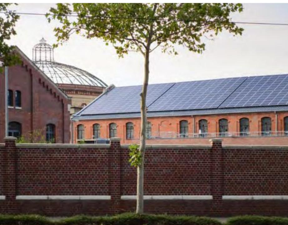
Das ehemalige städtische Gaswerk mit seinen zeittypischen, um 1900 errichteten Klinkerbauten ist von technikgeschichtlicher Bedeutung. Die leerstehende Maschinenhalle konnte durch die Nutzung der Dachfläche als Träger einer großen Photovoltaikanlage erhalten werden. Die Wirtschaftlichkeit der Dachneudeckung war damit gewährleistet.
