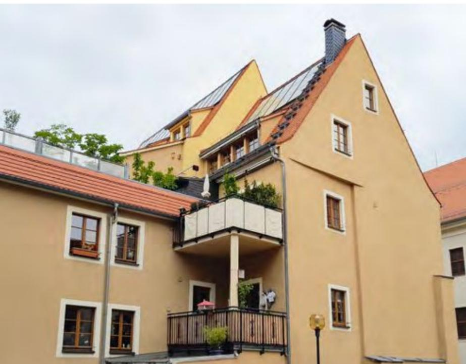
Bei der Sanierung des Gebäudekomplexes aus dem mittleren 16. Jahrhunderts im Altstadtkern wurde der höhere Gebäudeteil saniert und das niedrigere Haus unter Erhaltung der Straßenfassade neu gebaut. Zum nicht öffentlichen einsehbaren Blockinnenbereich wurden im oberen Dachbereich Photovoltaikanlagen eingeordnet. Sie sind dachintegriert ausgeführt und fügen sich durch ihre regelmäßige Form in die Dachflächen ein.
