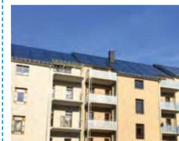
Vollflächig dachintegrierte Solarthermieanlage mit Flachkollektoren
