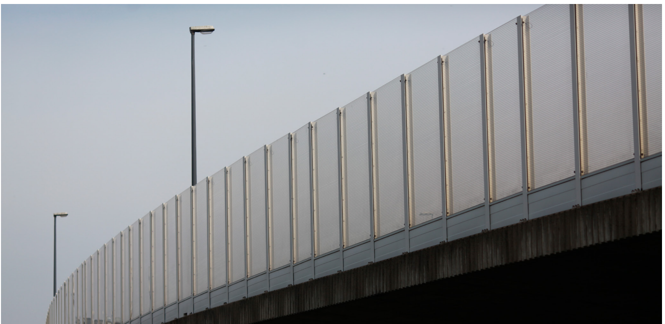
Abbildung 11: Lärmschutzwand als mögliche Lärminderungsmaßnahme
