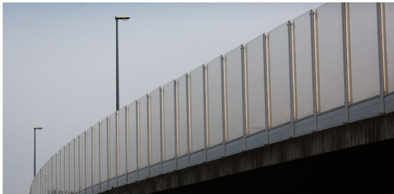
Abbildung 11: Lärmschutzwand als mögliche Lärminderungsmaßnahme
