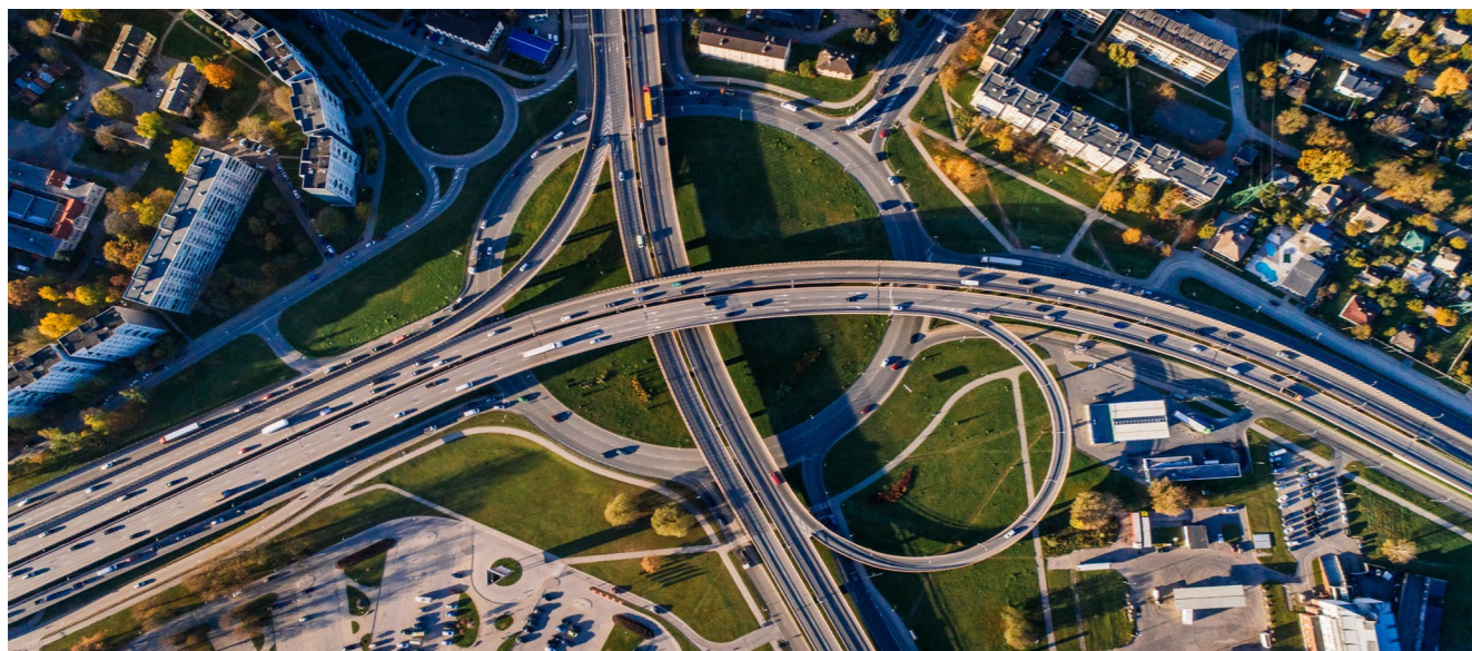
Abbildung 1: Straßen an sich sind nicht laut, der Verkehr verursacht die Belastung
