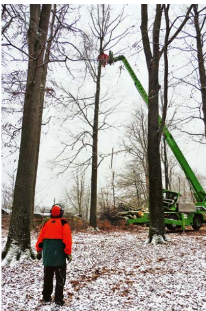
Abtragen der Baumkrone mit Totästen. Der Maschinenführer wird vom Einweiser unterstützt. Foto: Holger Buchta
