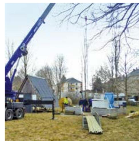
Abb. 6: Einbau der Steigleitung an der Grubenwassermessstelle Oelsnitz/Erzgebirge
