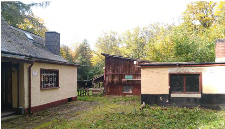
Abb. 3.3-6: Nebengebäude des Forsthauses Kammerfost, in dem die Messstelle KAMM untergebracht ist (Foto: D. Schönwald).
