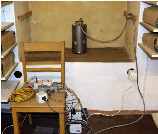
Abb. 3.2-2: Seismometer und Anschlussbaugruppen im Archivbunker der Stadt Landsberg. Das Seismometer ist ca. 20 m tief im Felsen aufgestellt.
