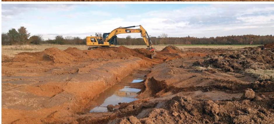
Abb. 4: Bauarbeiten für die Herstellung der Wasserflächen und Abtragung der Grasnarbe, oben: Abtragen der Grasnarbe, Mitte: Anlage der Kiebitzinsel, die später wasserumgeben ist, unten: Herstellung der Wasserflächen Fotos: NABU RV Leipzig
