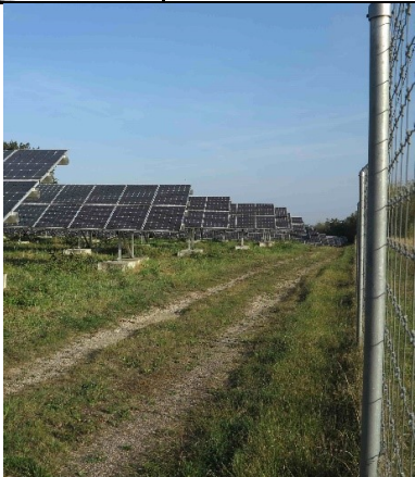
Weg aus Basaltschotter zur Erhöhung der Tragfähigkeit
