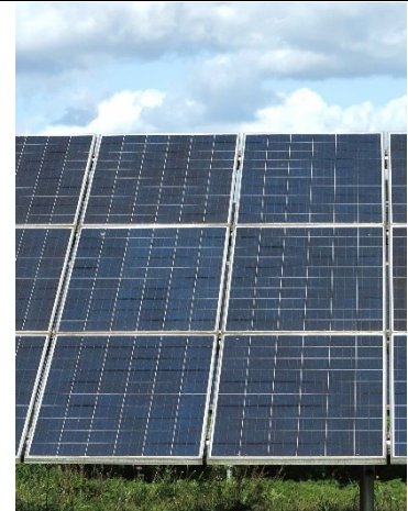
Lücken zwischen den PV-Modulen
