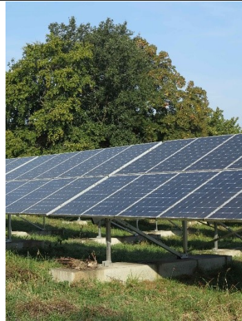
Verankerung über schwimmende Streifenfundamente
