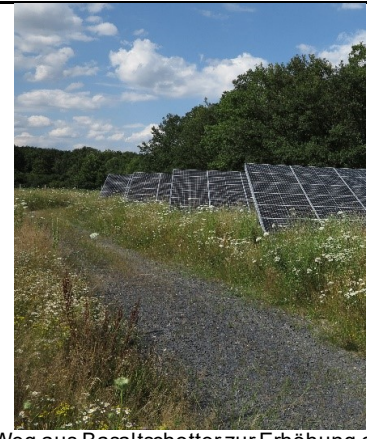
Weg aus Basaltschotter zur Erhöhung der Tragfähigkeit
