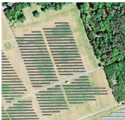
PV-FFA nördlich von Königsbrück © google.maps
