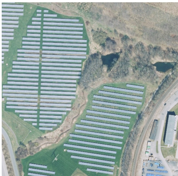
Solarpark westlich von Rodewisch. Der angelegte Korridor endet allerdings an einer Straße.
