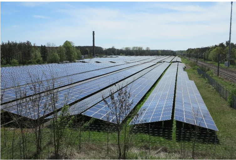
Abbildung 3: PV-Anlage mit einer starren Reihenaufstellung in Ost-West-Ausrichtung
