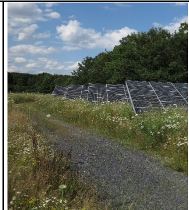
Abbildung 13: Weg aus Basaltschotter zur Erhöhung der Tragfähigkeit
