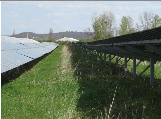
Abbildung 32: Teilflächenmahd: nur der beschattungsrelevante Streifen vor der Modultischkante wurde gemäht
