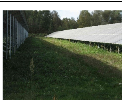
Abbildung 24: Breiter Reihenabstand. Eine Habitatqualität besteht nur, wenn ganzjährig ein besonnter Streifen im Zwischenraum verbleibt
