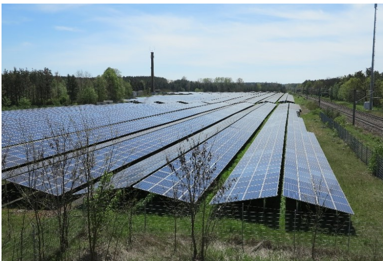
Abbildung 3:PV-Anlage mit einer starren Reihenaufstellung in Ost-West-Ausrichtung
