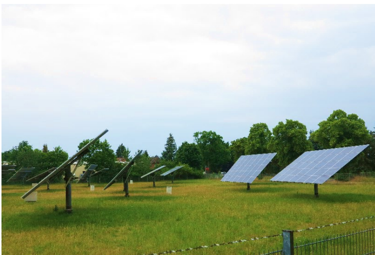
Abbildung 4:zweiachsig nachgeführte PV-Anlage
