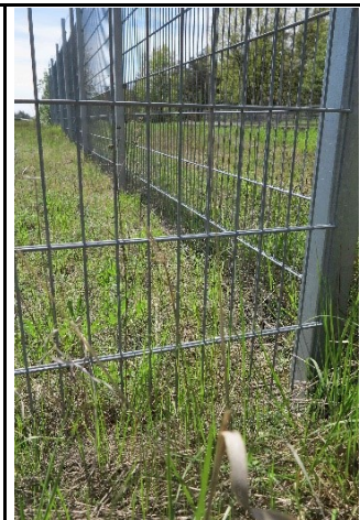
Abbildung 10: Zaun ohne Durchlässigkeit für Kleintiere
