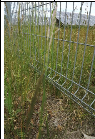
Abbildung 8: Unterkante Zaun mit Abstand zum Boden
