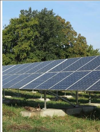
Abbildung 6: Verankerung über schwimmende Streifenfundamente
