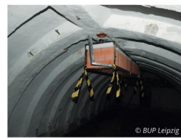
Anlage einer oberirdischen Regenwasserfassung aus Teichfolie mit Steinabdeckung, Einlauf in den Bunker, um eine ausreichend hohe Luftfeuchte in den Wintermonaten zu erreichen.
