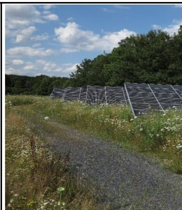
Abbildung 13: Weg aus Basaltschotter zur Erhöhung der Tragfähigkeit
