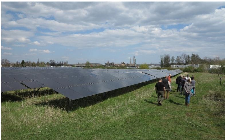
Abbildung 1: PV-Anlage mit starrer Reihenaufstellung in Südausrichtung
