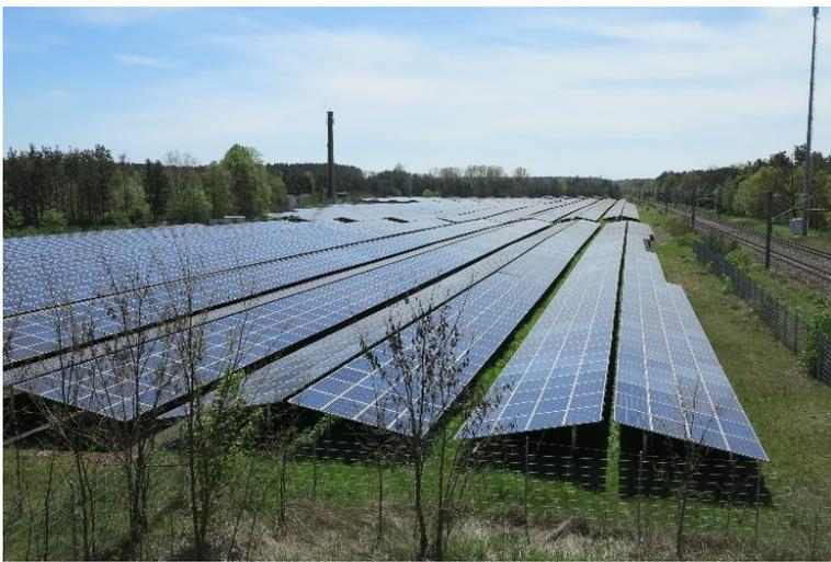
**Abbildung 3: PV-Anlage mit einer starren Reihenaufstellung in Ost-West-Ausrichtung**
