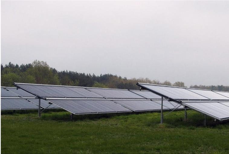
**Abbildung 2: Solarthermieanlage für die Fernwärmeversorgung, südausgerichtet, starr verankert**
