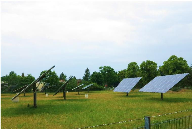
**Abbildung 4: zweiachsig nachgeführte PV-Anlage**
