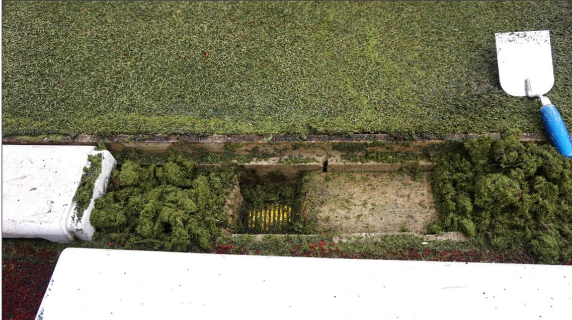
**Abbildung 10: Faserabrieb in der Entwässerungsrinne eines Kunststoffrasenplatzes nach 15 Jahren Nutzungsdauer**
