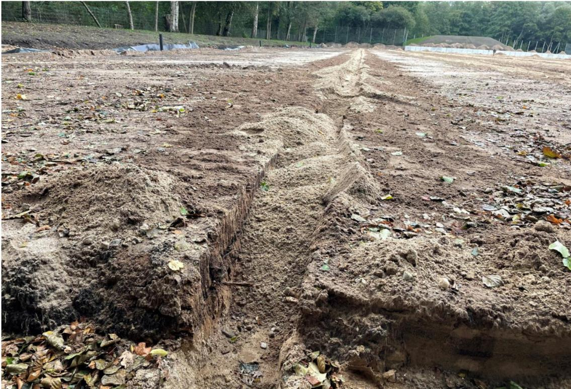
**Abbildung 25: Pilotprojekt Sportanlage Hamburg-Kroonhorst, Sportplatz mit Sickerpackungen im Bau**
