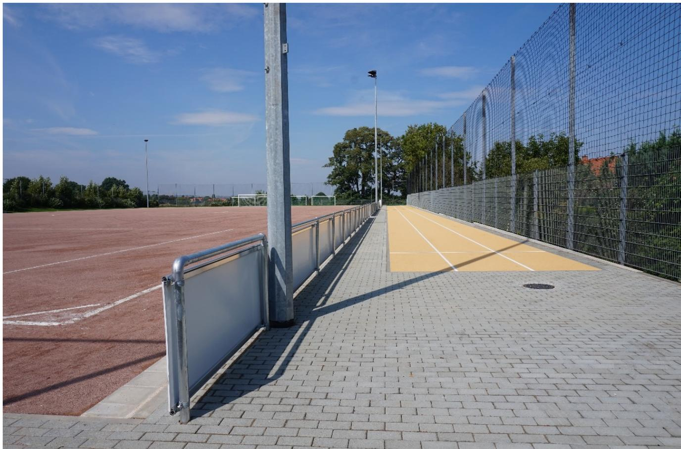
**Abbildung 5: Tennendecke nach DIN 18035-5 (links) und Laufbahn mit Kunststoffbelag nach DIN 18035-6, Sportanlage „Am Dölzschgraben“ in Dresden**
