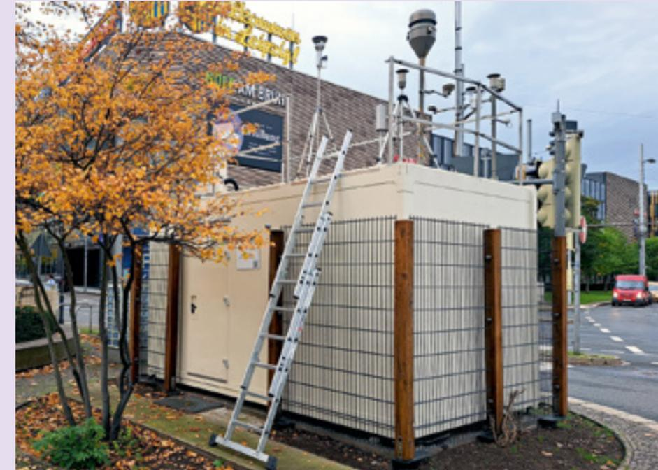
Abb. 2: Messstation Leipzig-Mitte: Der weitgehend bestückte neue Container
