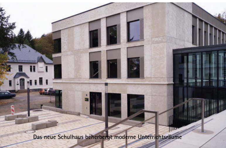
In dem sanierten früheren Kurhaus befindet sich heute das Internat
