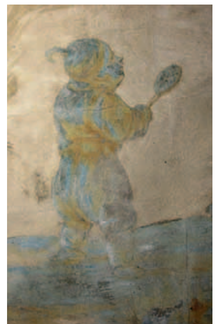
Ausschnitt aus der Deckenmalerei: optische Veränderung der Farbigkeit der Malereien durch Bildung einer Gipsinterschicht
