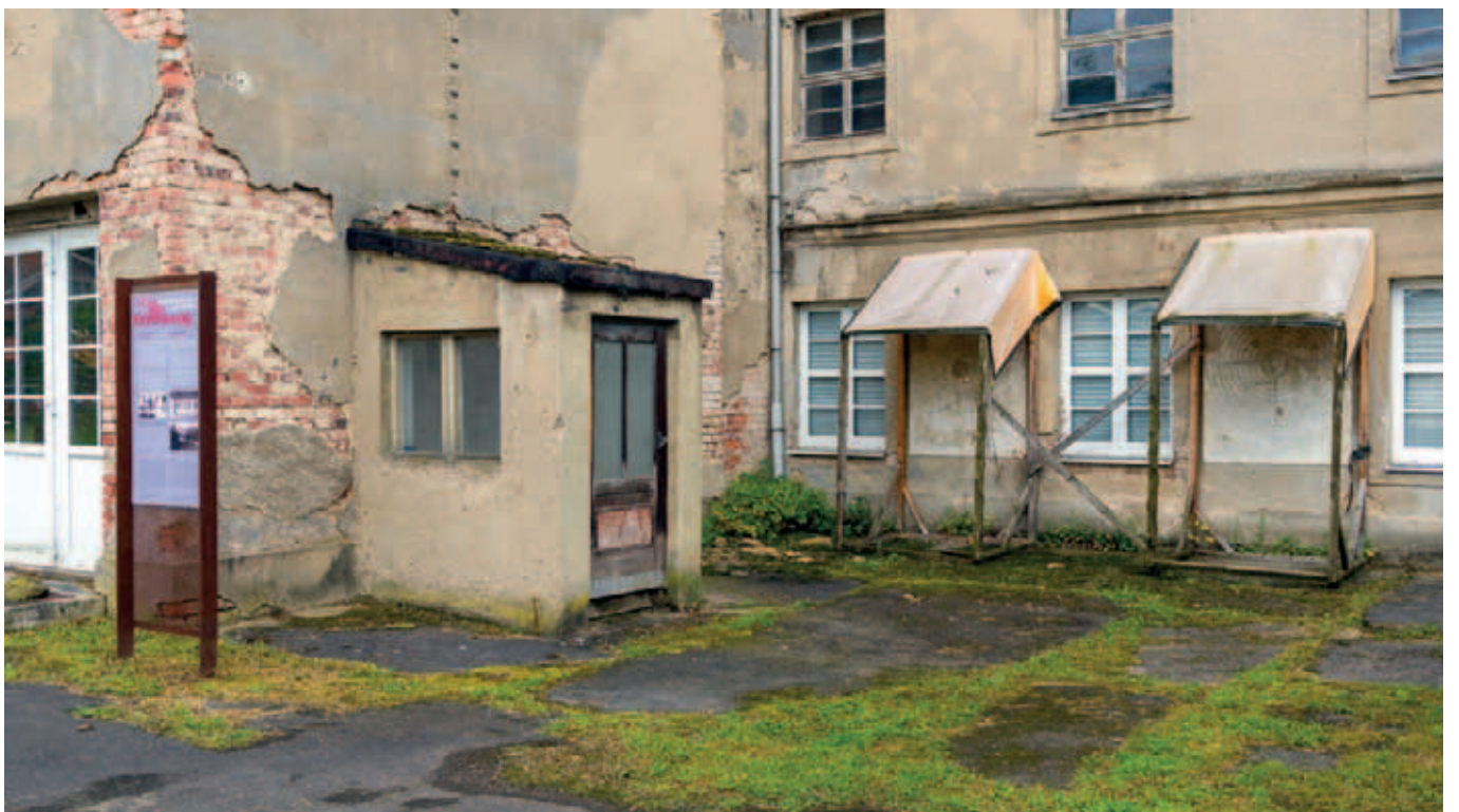
Ausschnitt der Fassade mit den Schutzdächern für die beiden Zielscheiben
