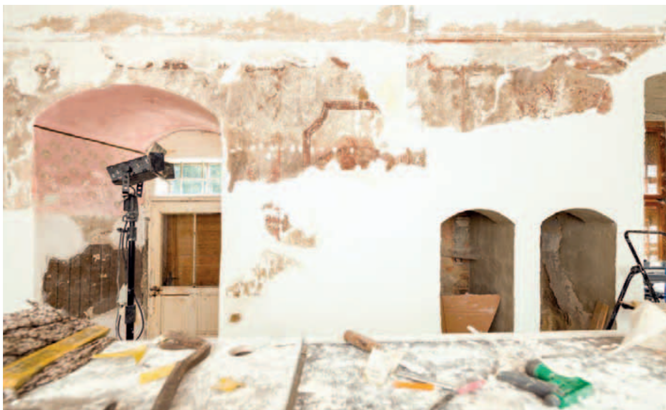
Die »Hintere Stube« im Erdgeschoss während der Restaurierung, 2024
