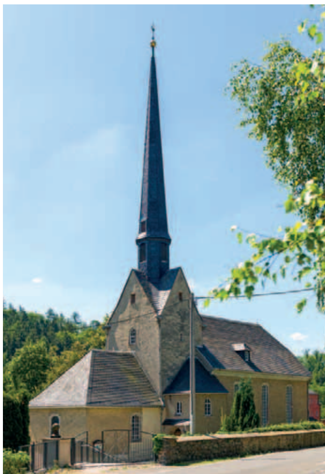
Ansicht der Dorfkirche mit der Barbarakapelle auf der Ostseite
