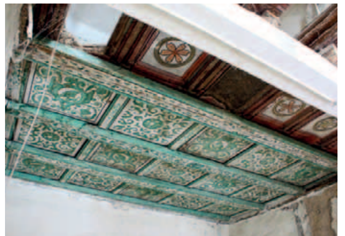
Decke in der »Jagdstube« während der Restaurierung: zwei bemalte Decken übereinander, 2010
