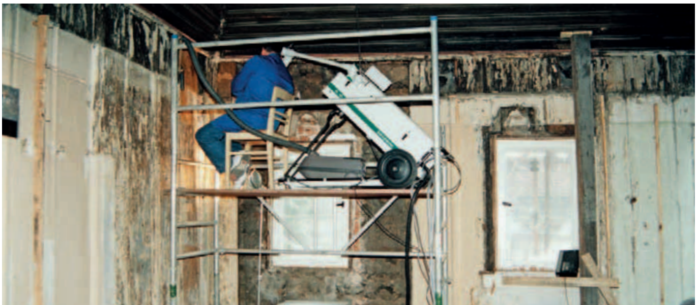
Blick in die Bohlenstube während der Reinigung der Holzoberflächen mittels Laser, 1995
