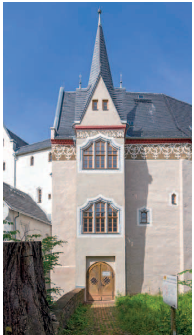
Teilansicht der Fassade mit der Friesgestaltung
