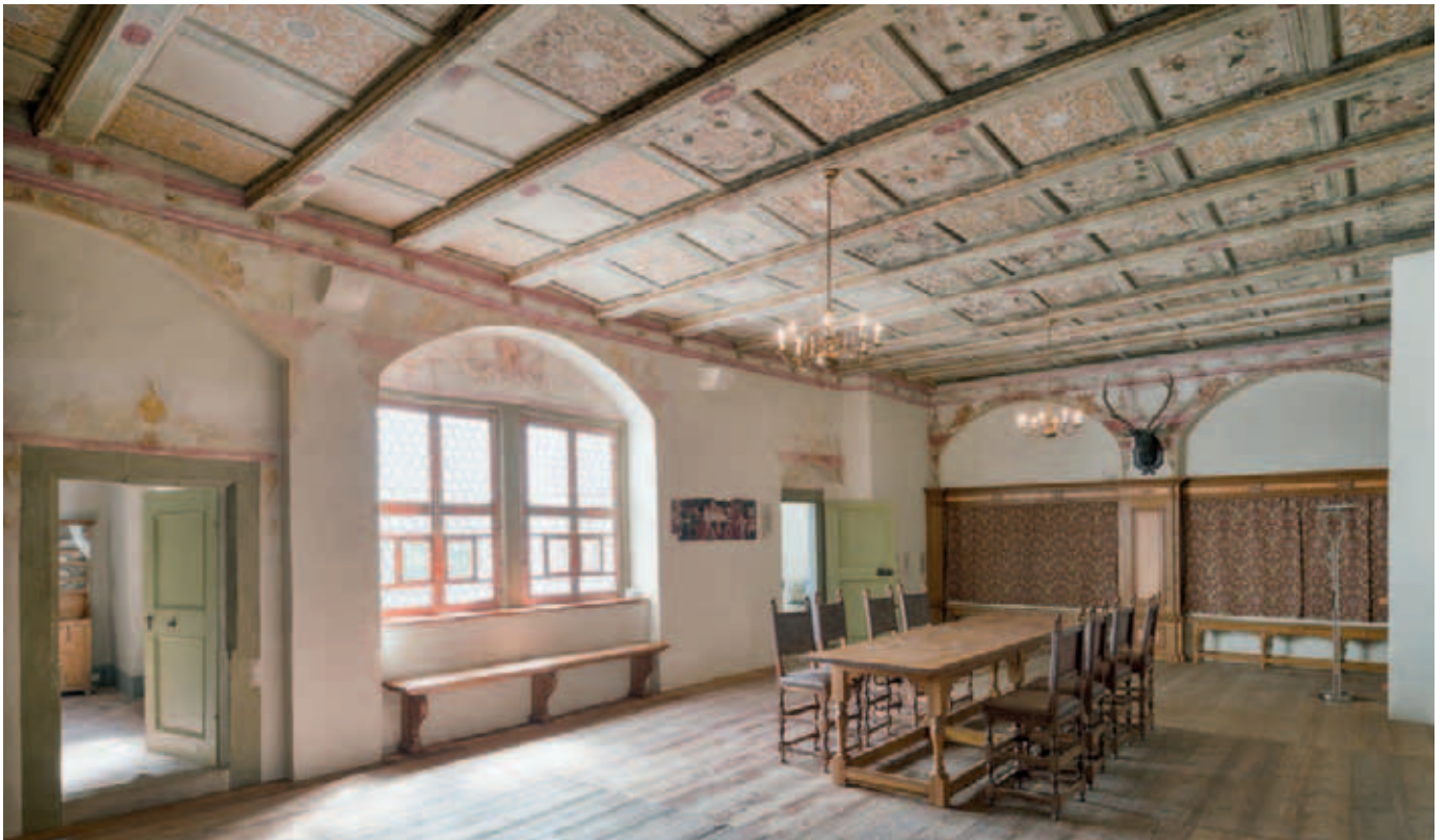
Die Wohndiele im zweiten Obergeschoss nach Abschluss der Restaurierung und Ergänzung der Wandpaneele
