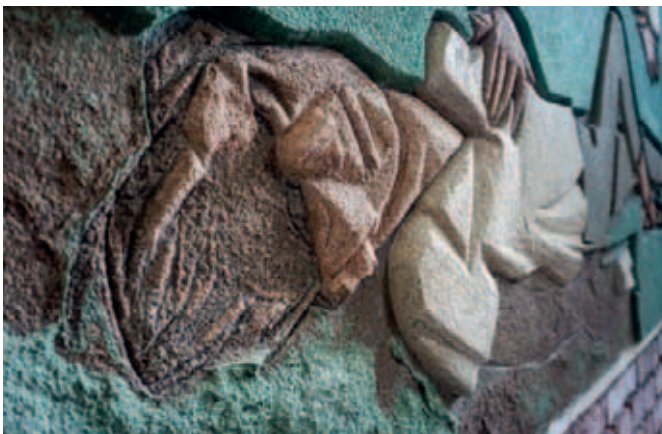
Ausschnitt aus dem Wandbild »Ruhe« mit großflächigen Verlusten im Putz im Streiflicht, 2020
