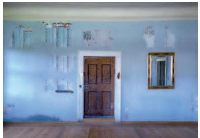
Saalwand im Erdgeschoss nach der Restaurierung
