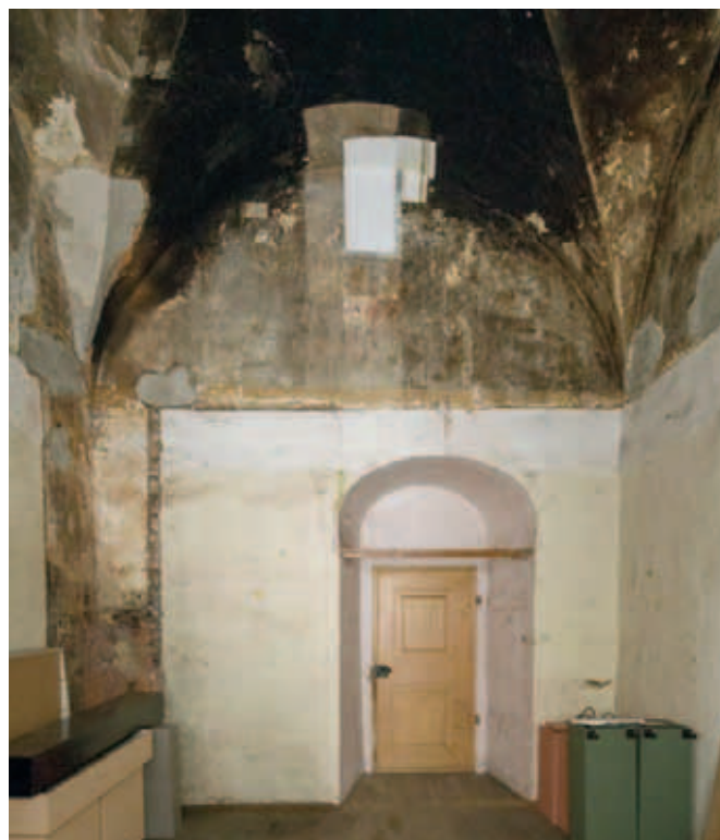
Vorgemach des Kurfürsten mit den Arbeitsproben zur Abnahme der Rußauflagen
