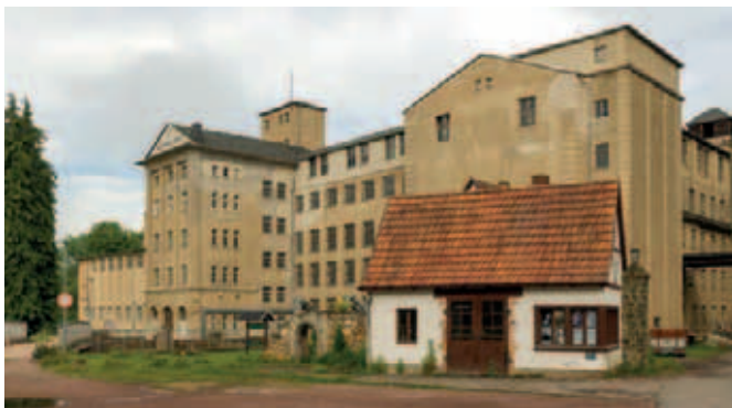
Das Fabrikgebäude der ehemaligen Spinnerei
