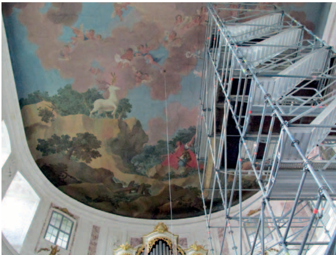
Gerüst für die restauratorische Untersuchung der Decke in der Kapelle in Schloss Hubertusburg
