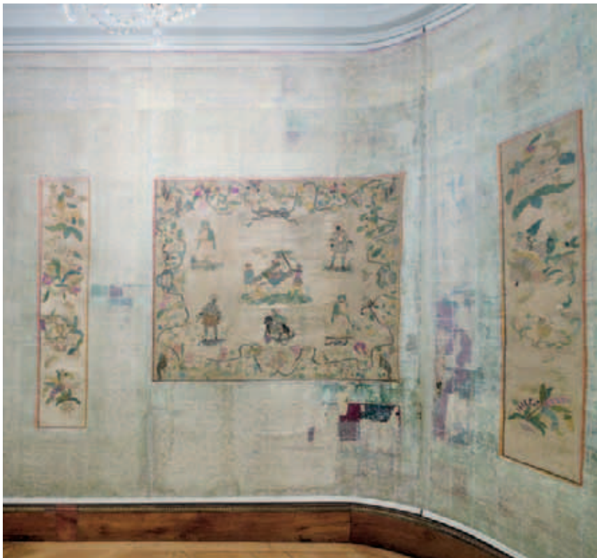
Blick in das Chinesische Kabinett: Zustand nach der Restaurierung der Seidenapplikationen und Sicherung der Papiertapete
