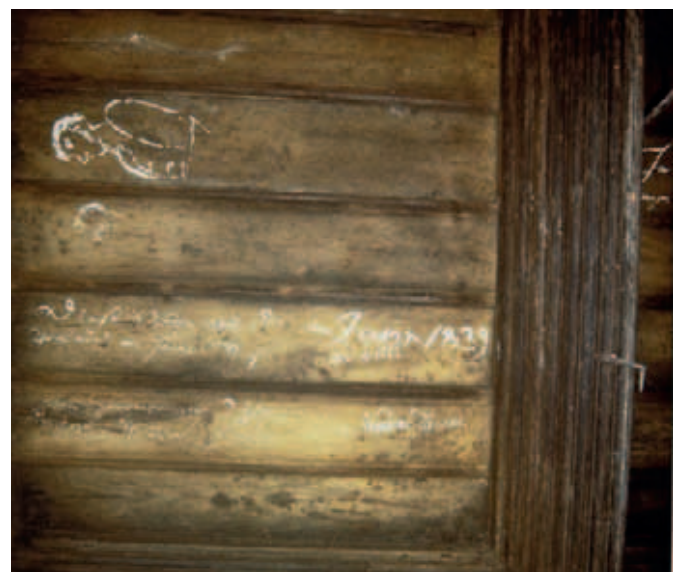
Zustand der Decke im Jahr 1995 nach Abnahme der Zwischendecke von 1839, Kreideinschriften des Zimmermanns Jähnigen und des Maurers Schardow
