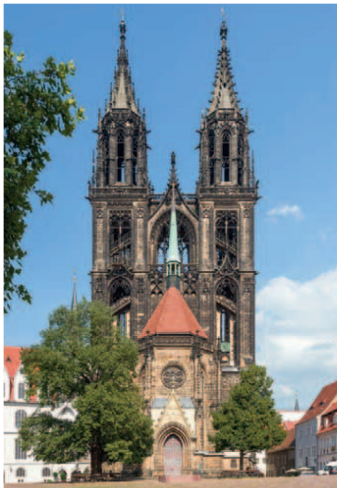
Dom zu Meißen, Westfassade
