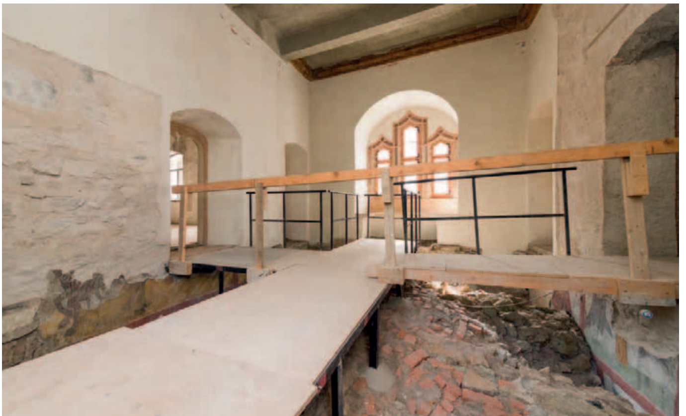
Raum über dem spätgotischen Gewölbe: die Wandmalerei befindet sich an den Wänden unterhalb des Fußbodenniveaus
