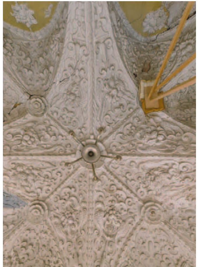
Notsicherung der Stuckdecke in Schloss Lauenstein
