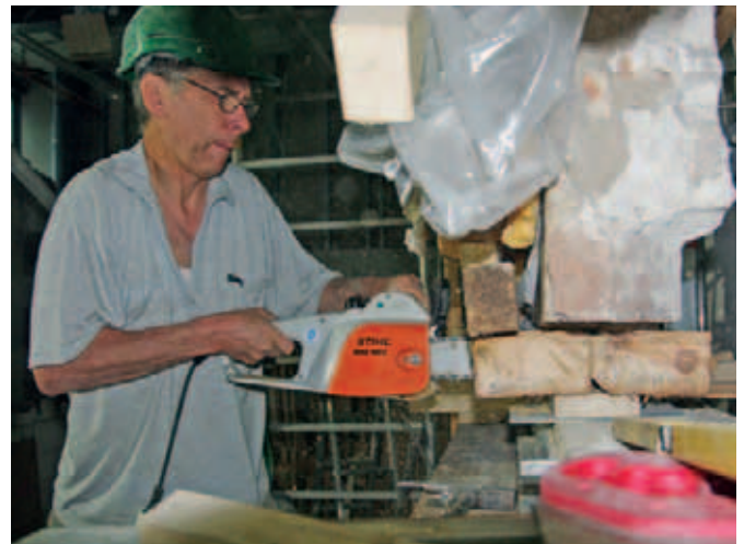
Restaurator beim schrittweisen Rückbau der Holzbalkenkonstruktion von 1893 an der abgenommenen Wandmalerei des ehemaligen Dominikanerklosters St. Pauli in Leipzig
