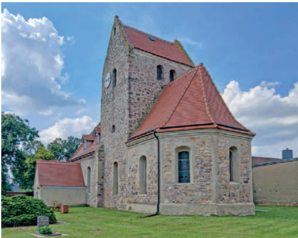
Ansicht der Dorfkirche Zaasch von Südosten
