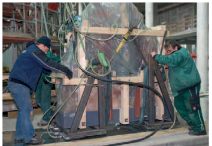
Erschütterungsfreies Versetzen einer Wandscheibe mittels Luftkissen-technik in das Paulinum, 2011
