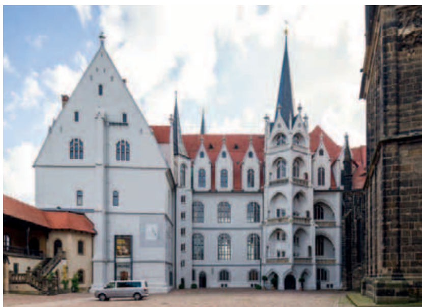
Gesamtansicht der Westfassade der Albrechtsburg
