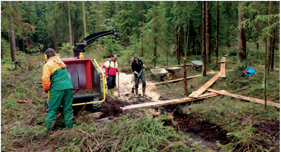
Moorrenaturierung bedeutet ingenieurbologisch anspruchsvolles Arbeiten
