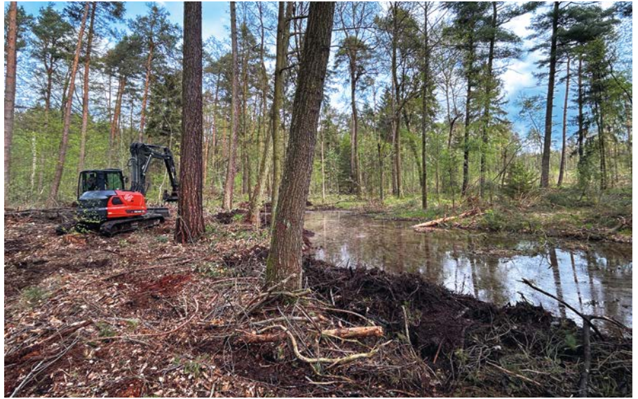
Abb. 1: Minibagger im Einsatz, Forstbezirk Dresden, Forstrevier Moritzburg; Foto: Marco Groß
