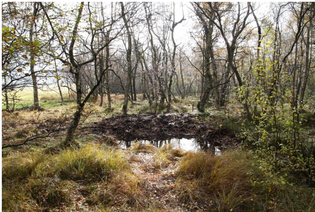
Abbildung 13: Mit Torf überdeckte Hartvinyl-Spundwand mit Rückstaugewässer kurz nach dem Bau in einem Moor im Osterzgebirge. Foto: K. Keßler
