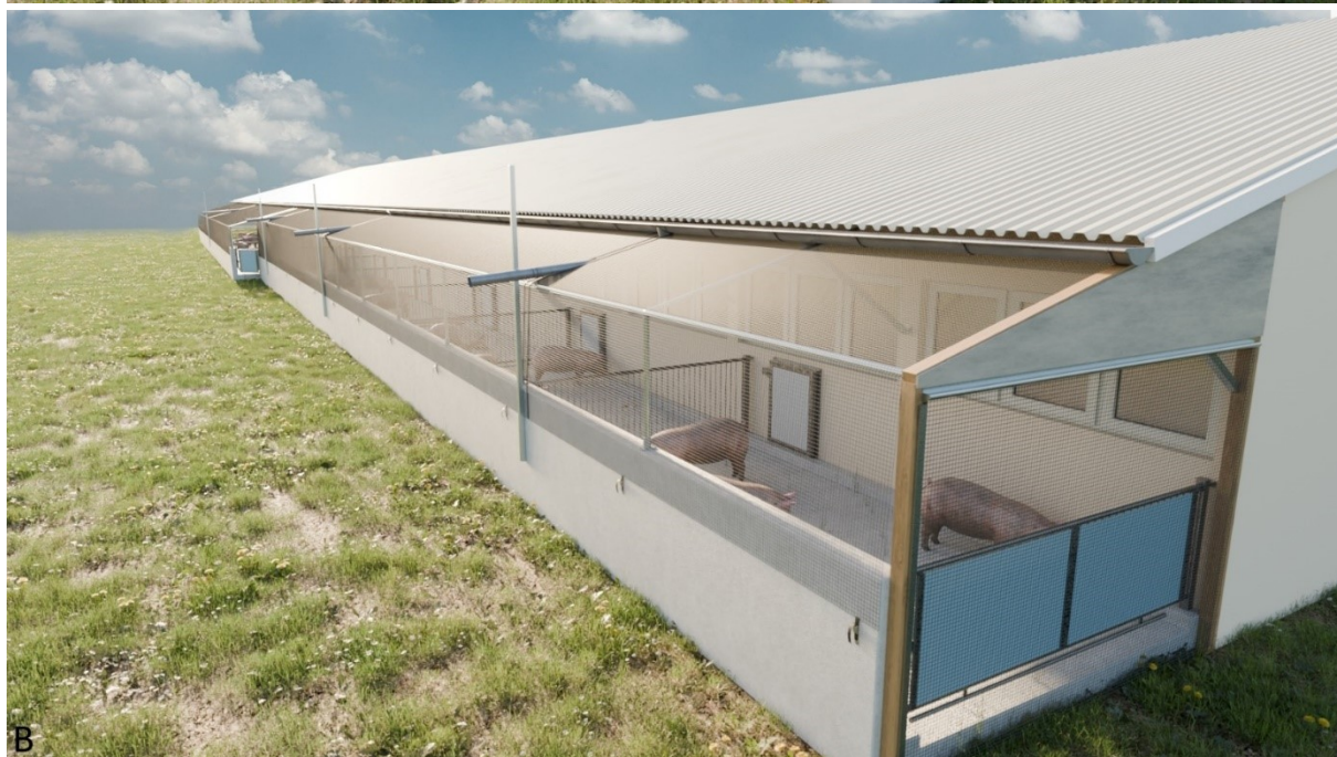
Abbildung 14: A) Der Auslauf mit einer Teilüberdachung. B) Der teilüberdachte Auslauf mit einer Unterkonstruktion und Vogelschutznetz. Bildquelle: Moll Anlagenbau GmbH & Co. KG
