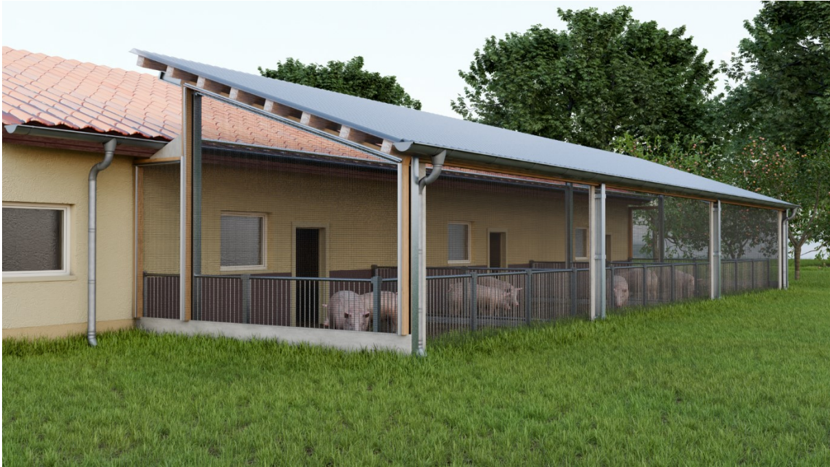
Abbildung 8: Auslauf mit kompletter Überdachung und Vogelschutznetzkonstruktion.
