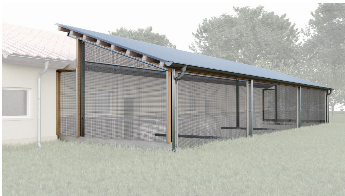
Abbildung 7: Der bereits überdachte Auslauf kann durch eine zusätzliche seitlich Unterkonstruktion und Vogelschutznetze (vom Hintergrund hervorgehoben) eine erhöhte Biosicherheit gegen Erregereintrag bieten. Bildquelle: Moll Anlagenbau GmbH & Co. KG
