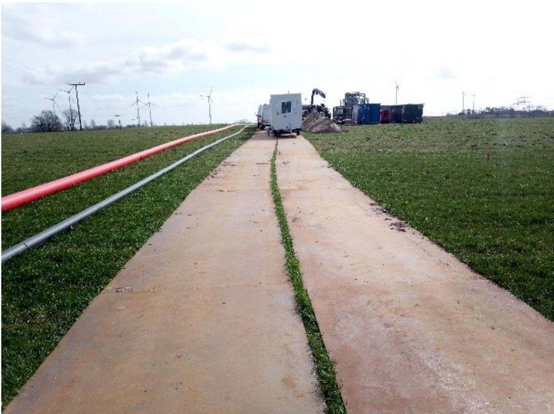
Abbildung 10: Schutz des Bodens vor Verdichtung bei einer Baumaßnahme – „Baustraße“. Jenaer GEOS K. Roselt 2022
