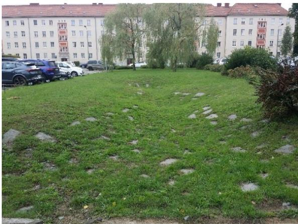
Abbildung 9: Muldenversickerung im Dunkerviertel in Leipzig. Eigene Aufnahme 2022
