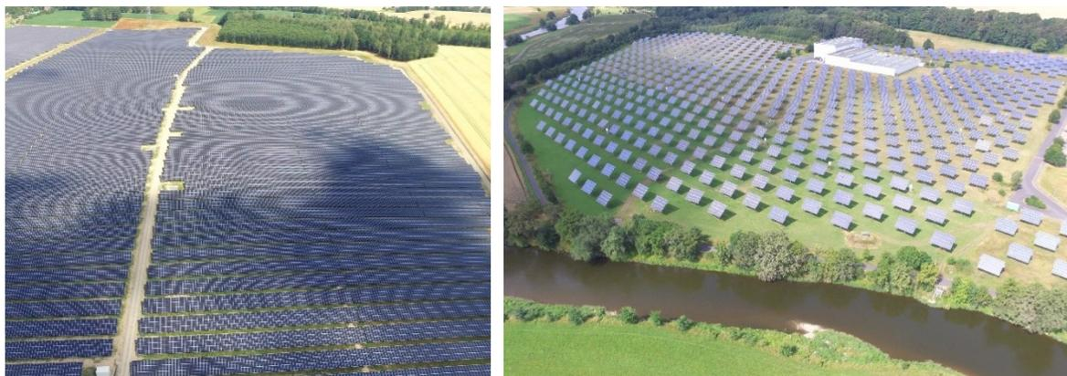
**Abbildung 1: Drohnenaufnahmen einer fest installierte Freiflächensolaranlage mit Südausrichtung (links) im Vergleich zu einer Anlage mit zweiachsig nachgeführten Modulen (rechts) © Foto: Norman Schiwora**
