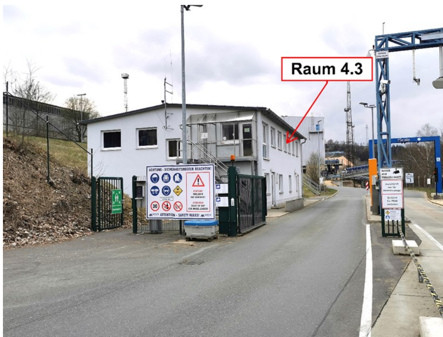
Abbildung 21: Immissionsort Raum 4.3 von außen.
