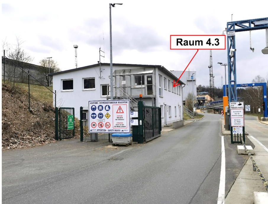
Abbildung 21: Immissionsort Raum 4.3 von außen.
