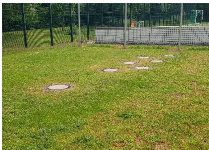
Bauliche Anlage, Rigole (SP 3)
