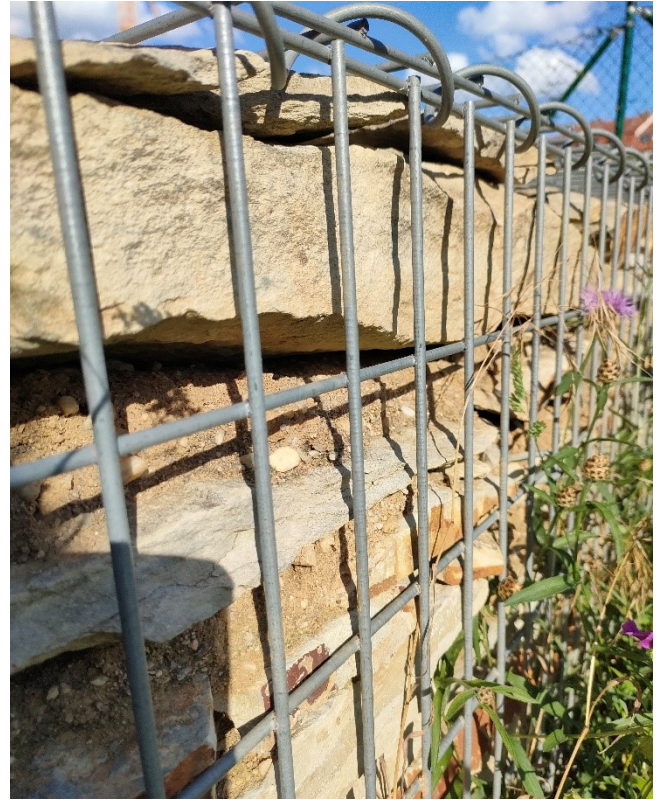
Abbildung 12: Gabionen gefüllt mit Bruchsteinen und Lehm
