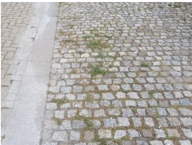
Wege/Plätze, teilversiegelt, Pflasterbelag
