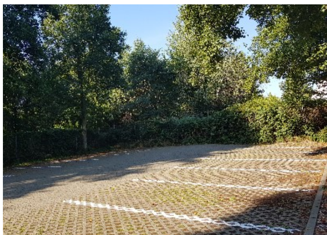
Parkplatz, Rasengitter, wasserdurchlässig (SP 23)
