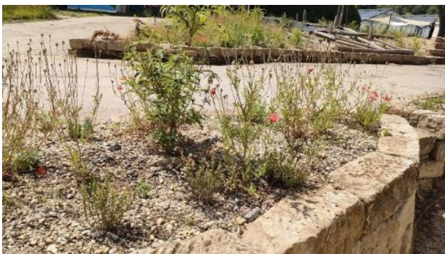
Abbildung 25: Trockenmauer mit Kiessandhinterfüllung
