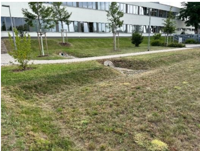
Abbildung 35: Sickerbecken mit teilweise offenem Zulauf aus Dachentwässerung
