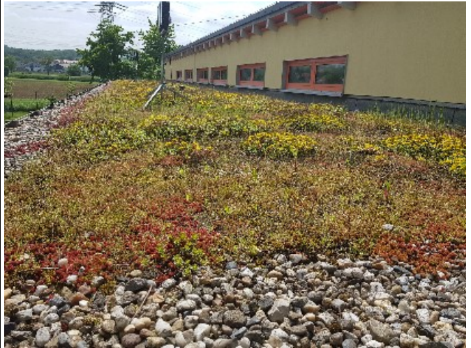
Dachfläche mit extensiver Dachbegrünung (SP 4)
