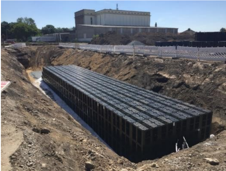
Abbildung 37: Einbau einer Füllkörperrigole
