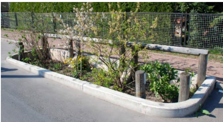
Abbildung 38: Tiefbeet-Rigolen-Element
