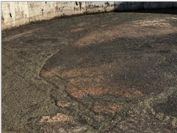
dünne trockene Schwimmschicht,
