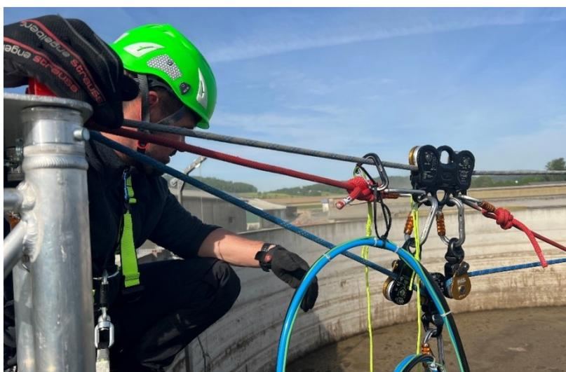
**Abbildung 4: Befestigung der Messhaube an der Seilkonstruktion und Bewegung durch einen Rollschlitten**
