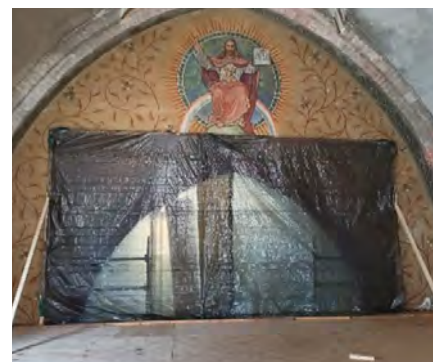
Abb. 24: Abtrennvorrichtung zwischen den Arbeitsbereichen, ©LDS
