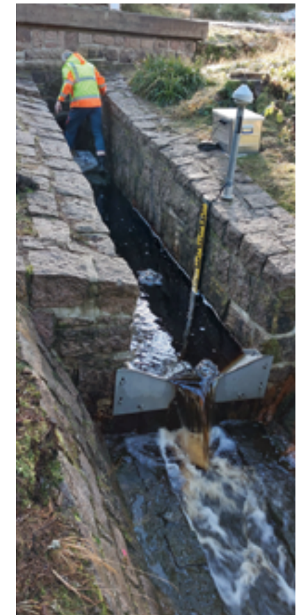
Abb. 6: Inbetriebnahme Pegel Carlsfeld 2/ Kranichseegraben
