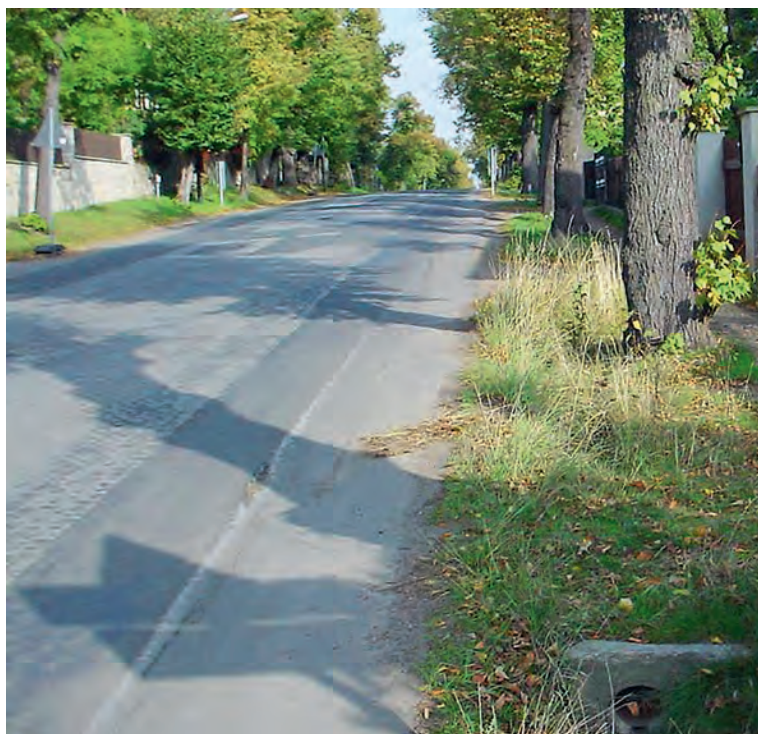
Teilweise asphaltiertes Kleinsteinpflaster von 1926 im Abschnitt Waldstraße–Kirche Moritzburg mit Straßengraben, Zustand 2004.
