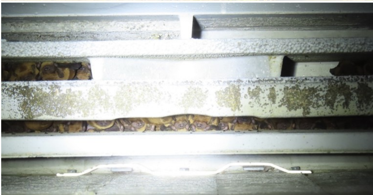
Abbildung 215: Universalquartier 2FTH an neugebauter Brücke.
