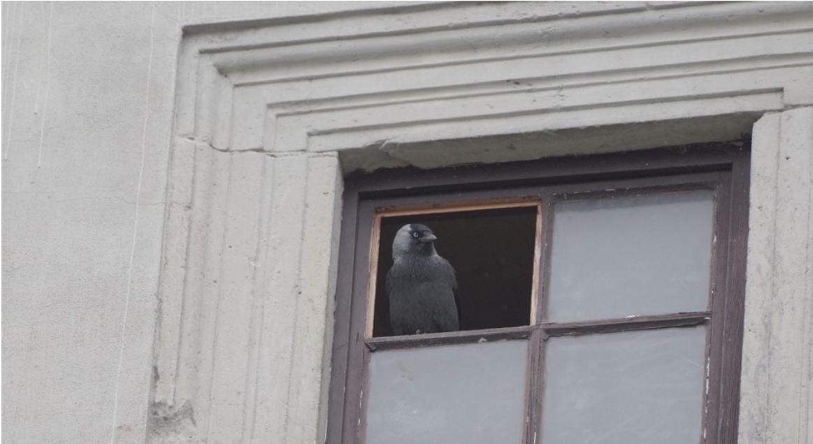
Abbildung 40: Dohle im Einflug eines Kastens, der hinter einem ungenutzten Fenster montiert wurde. Die Fensterflächen wurden von innen verdunkelt.
