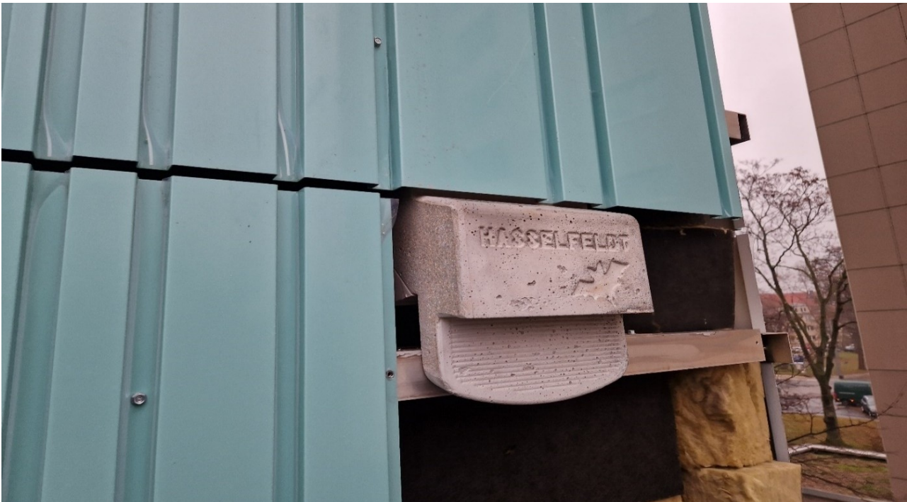
Abbildung 162: In Vorhangfassade integrierte Fledermaus-Ganzjahres-Fassadenkasten-Unterputz mit Haubenblende FGUP-FM-24 Fa. Hasselfeldt.
