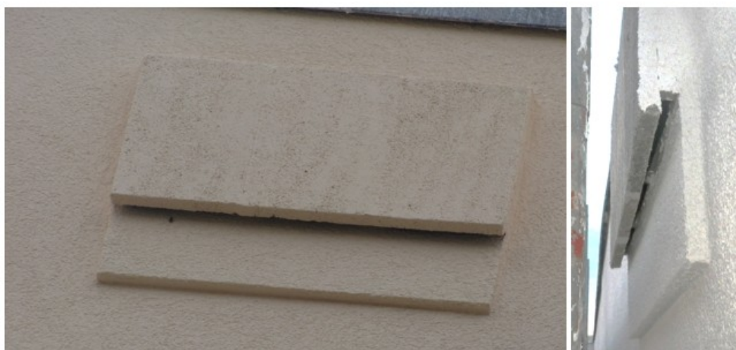
Abbildung 168: Anflugbrett am Beispiel eines Großraumeinbausteins. Wichtig ist der einflugbündige Abschluss des Anflugbretts am Kasten (rechts).
