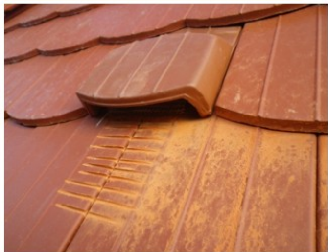
Abbildung 99: Konstruktive Quartierschaffung durch Einbau von integrierten Dachquartieren in der Hinterlüftungsebene mit als Landefläche aufgerauten Ziegelbereichen unter den als Zugang umgebauten großen Lüftungsziegeln ohne Siebteil.
