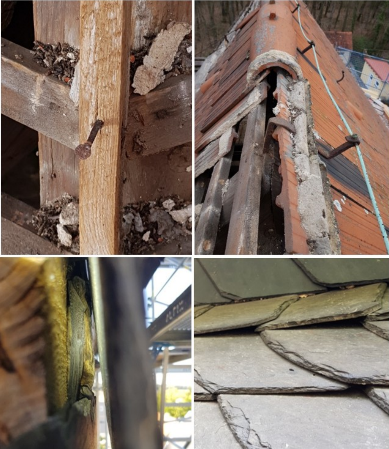
Abbildung 258: Bergung von Fledermäusen bei Dachrückbauten.
