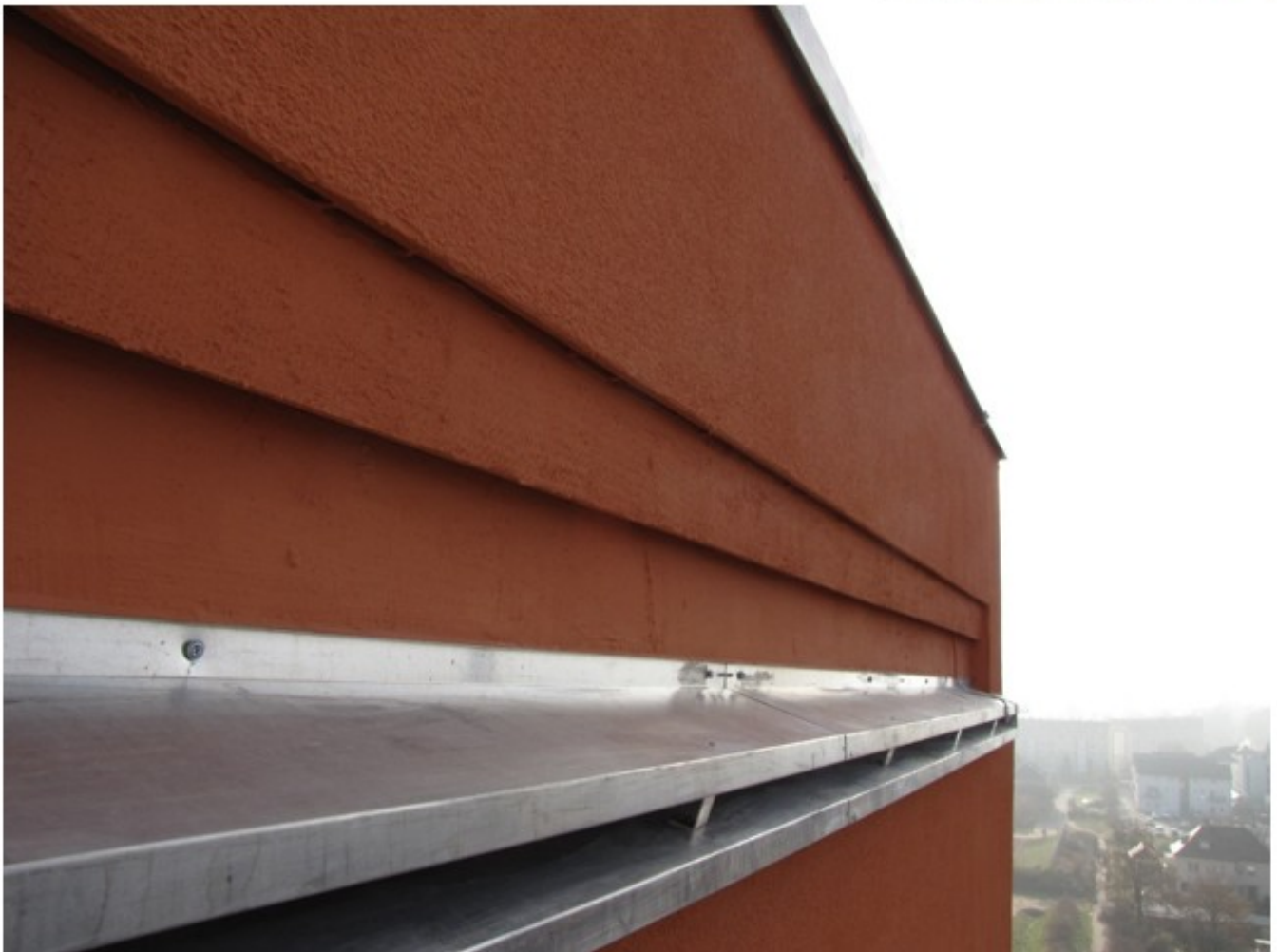
Abbildung 173: Kotbleche in Kastennähe be- oder verhindern die Besiedlung. Diese sollten einen Meter unterhalb des Einflugs montiert werden.
