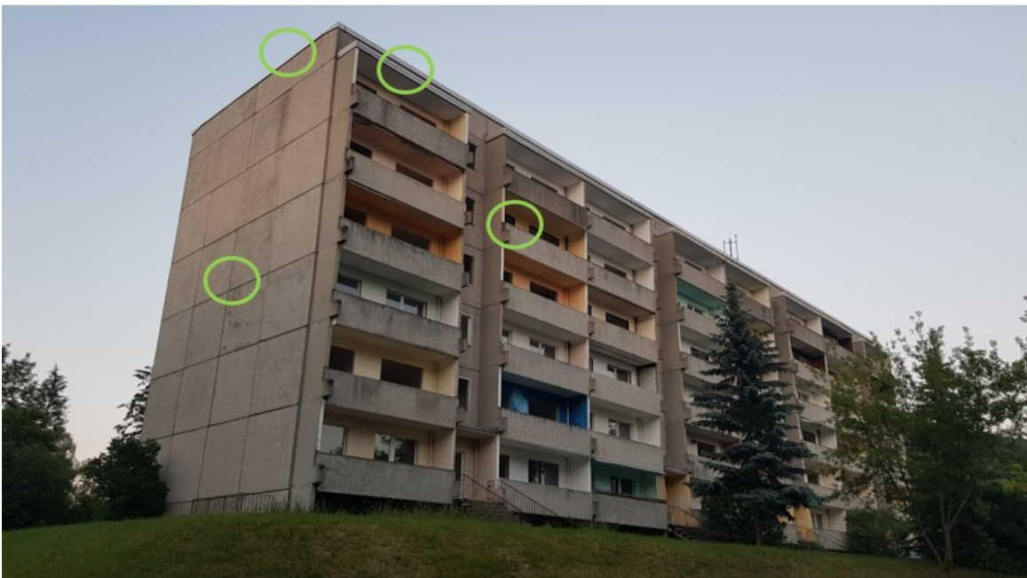
Abbildung 7: Quartierstrukturen an Plattenbauten finden sich in Plattenfugen, Balkonen, der Attika, im Drempel, unter Fensterbrettern und an weiteren Stellen .
