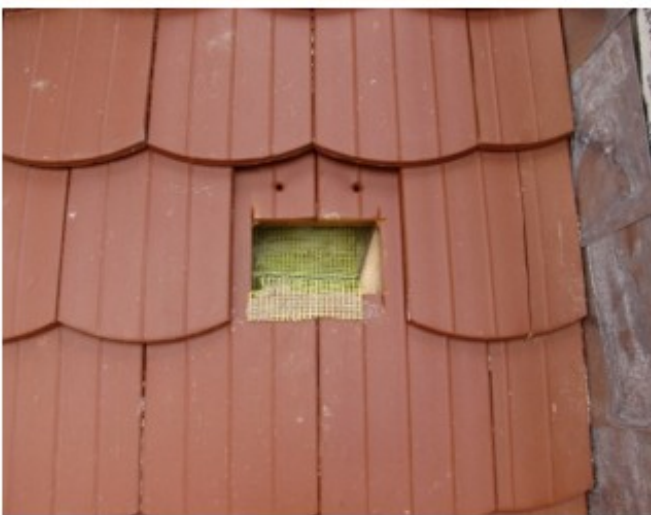
Abbildung 99: Konstruktive Quartierschaffung durch Einbau von integrierten Dachquartieren in der Hinterlüftungsebene mit als Landefläche aufgerauten Ziegelbereichen unter den als Zugang umgebauten großen Lüftungsziegeln ohne Siebteil.
