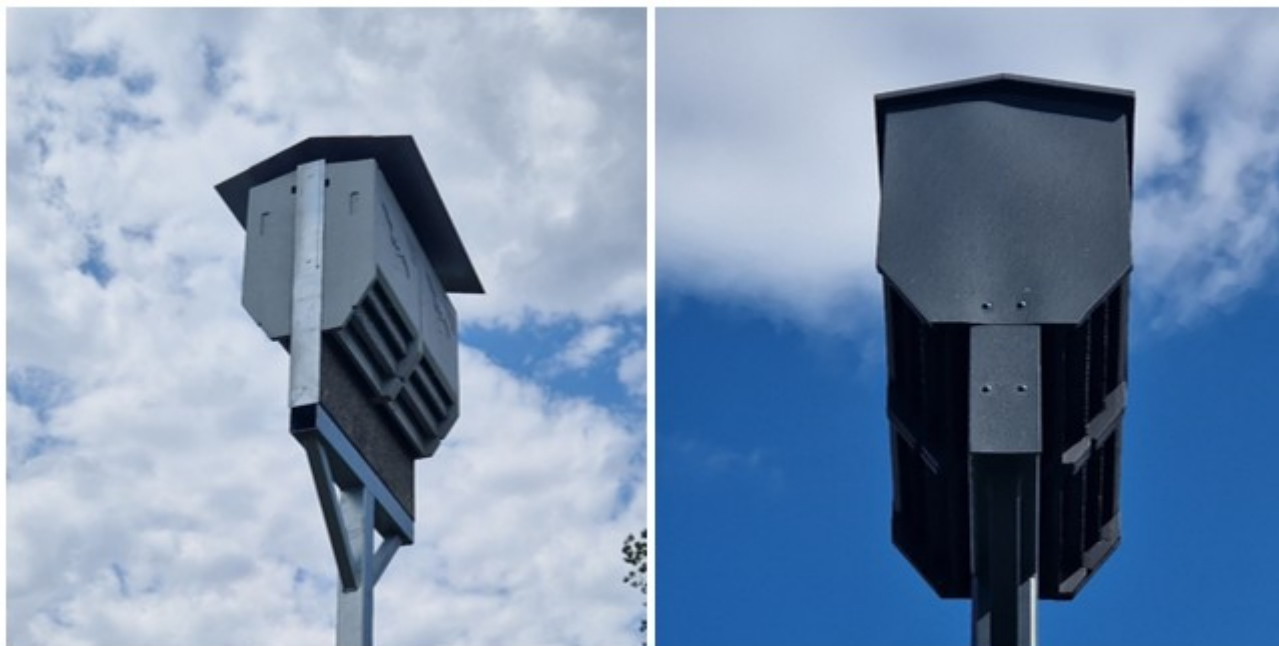
Abbildung 178: Ungünstig angebrachtes Metaldach auf Fledermauskasten in Ständerquartier (links) verhindert die Erwärmung des Kastens durch Sonneneinstrahlung von oben. Rechts ist die korrekte Ausführung ohne Luftraum zwischen Dach und Kasten dargestellt.
