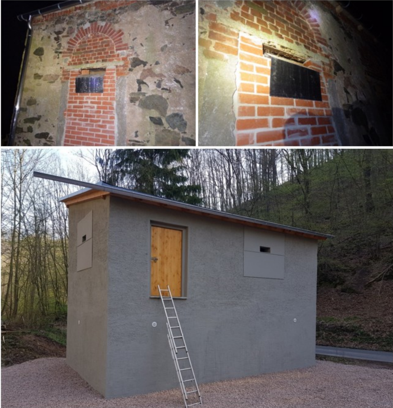
Abbildung 184: Verhinderung des Eindringens von Prädatoren durch die Montage von An- sprungschutzblechen (oben).
