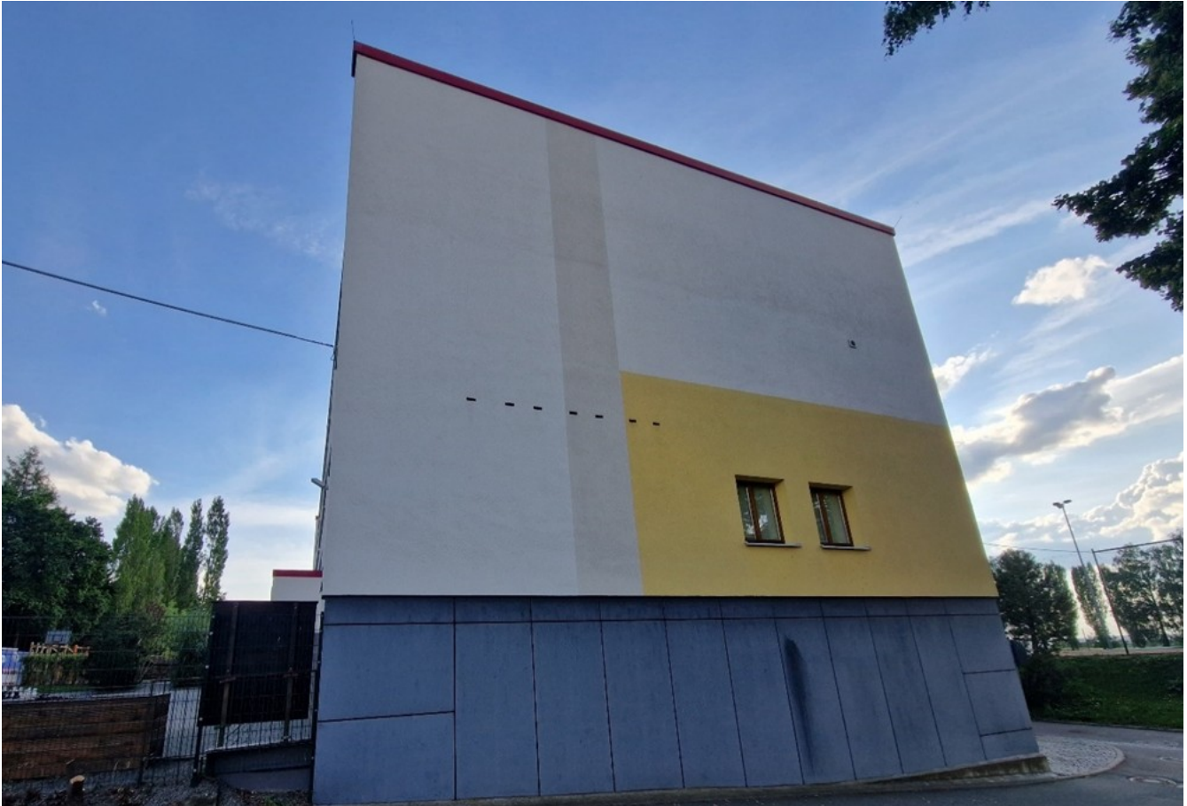
Abbildung 94: Quartiererhalt einer Kolonie der BreitflügelFledermaus durch Vorblendung von Grundsteinen zum Erhalt des Durchgangs zur besiedelten Plattenfuge (vgl. auch Abbildung 160).
