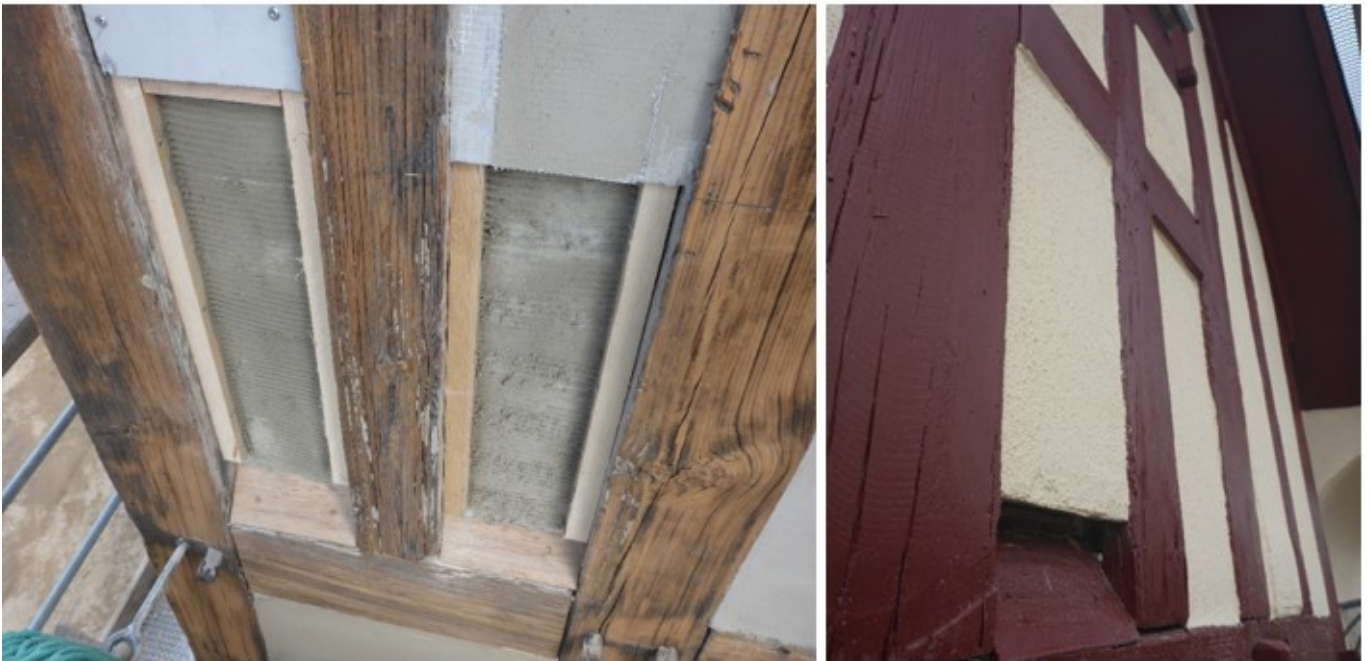
Abbildung 220: In Gefache integrierte Spaltenquartiere für Zwergfledermäuse.
