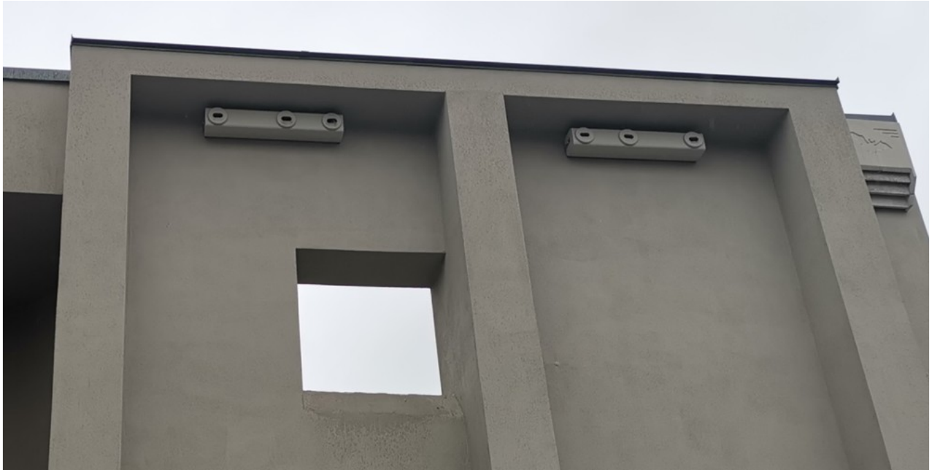
Abbildung 195: Witterungsgeschützter Einbau von Mauerseglerkästen auf der westexponierten Rückseite einer aus Gründen des Denkmalschutzes zu erhaltenden Fassade, angenommen von Mauersegler und Haussperling.
