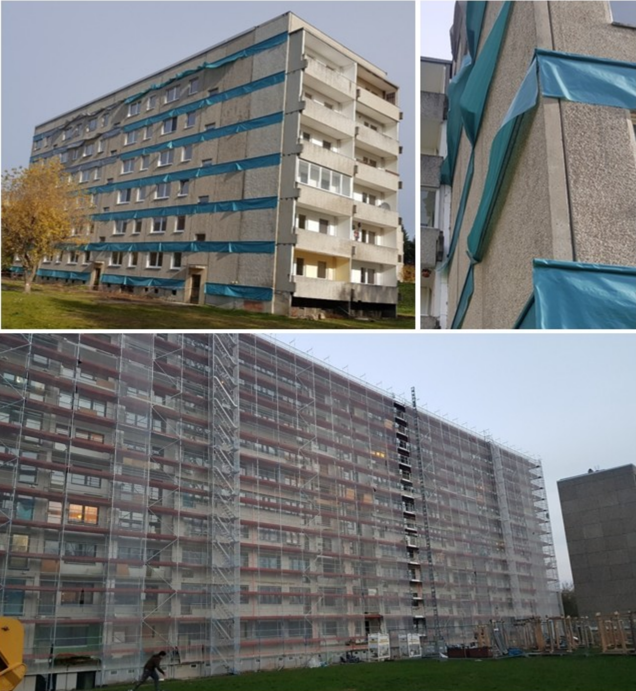
Abbildung 260: Geeignete Vergrämungsarten durch Folienvergrämung (oben) oder Gerüststellung mit Staubschutznetzen (unten).
