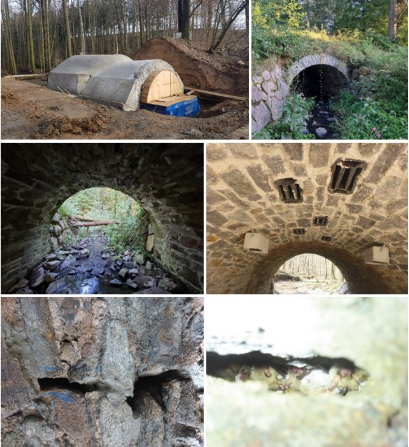
Abbildung 109: Sanierungsbeispiel einer Gewölbebrücke mit Zwischenquartieren der Fransenfledermaus vor der Sanierung.
