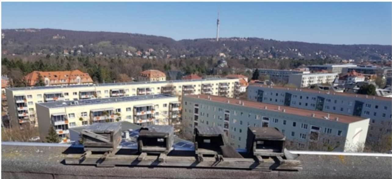
Abbildung 177: Zerfallene Kästen verlieren ihre Funktion und stellen Verkehrssicherheitsprobleme dar.
