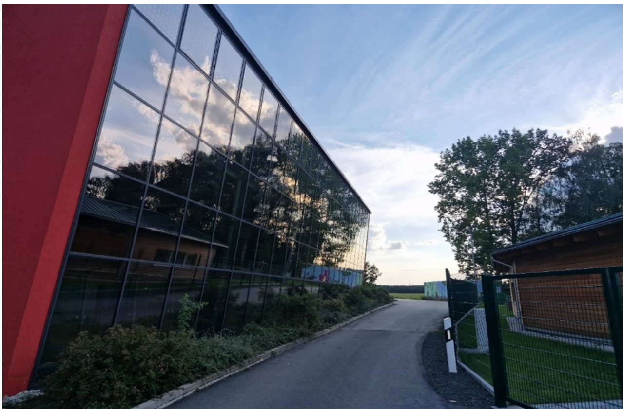
Abbildung 242: Fassade mit besonders hohem Kollisionsrisiko.
