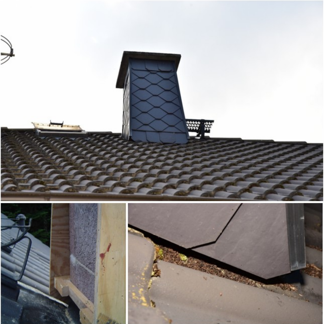
Abbildung 107: Beispiel für den erfolgreichen Erhalt einer Wochenstube der Fransenfledermaus an einem Schornstein durch Nachbildung der Struktur.
