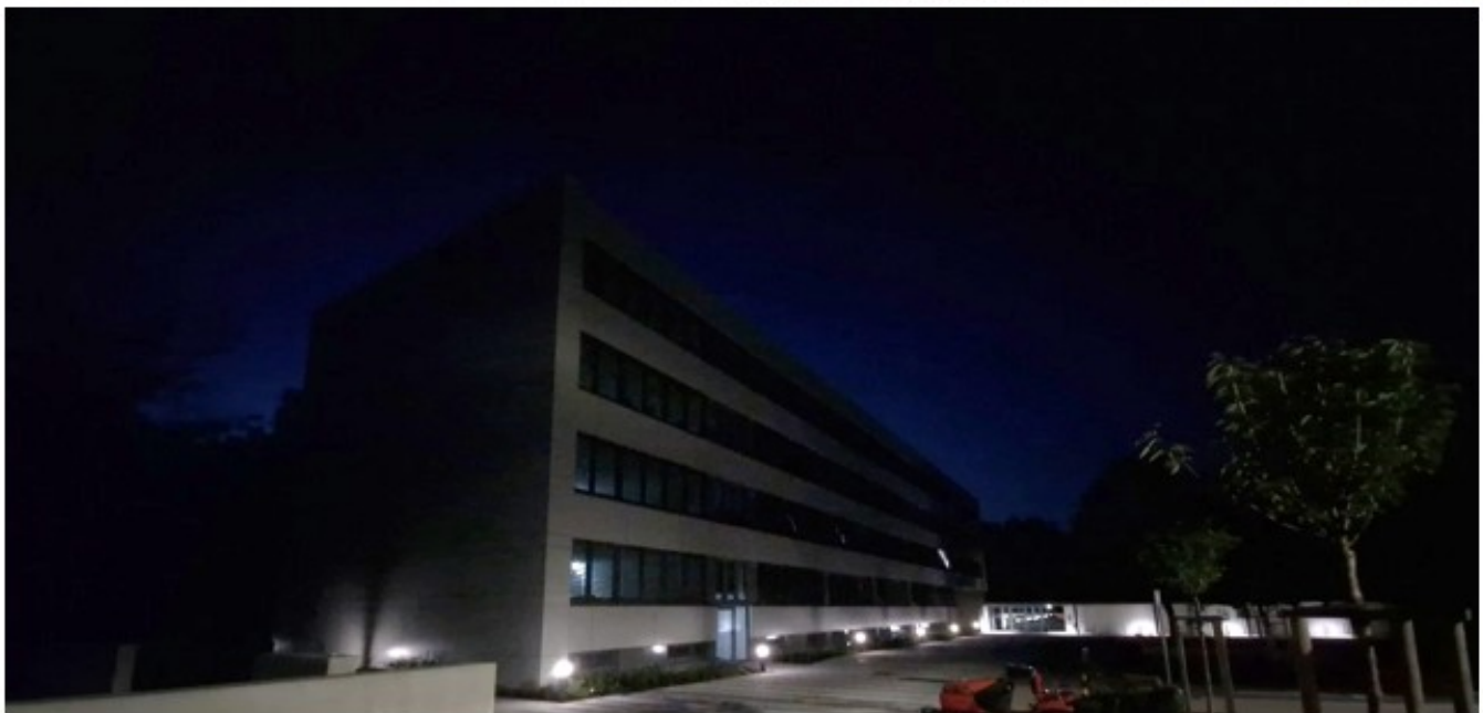
Abbildung 188: Artenschutzfachlich gut gelöste Beleuchtung eines Schulgeländes mit geringer Ausleuchtung der Kästen an der Fassade.
