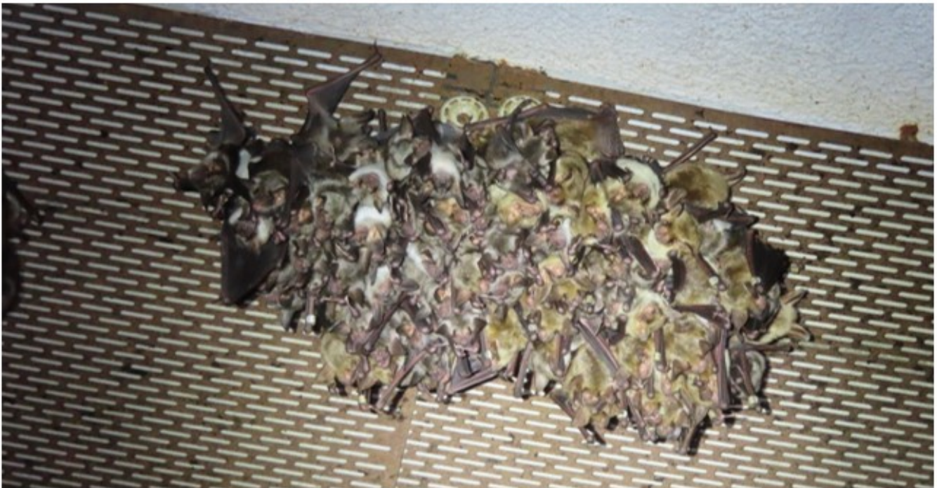
Abbildung 119: Aufgrund der mechanischen Belastung sind Hangplatzaufrauungen mittels Ar- mierungsgewebe für die Art ungeeignet (siehe Fehlstellen im oberen Bild). Aufrauungen mit- tels Rauputzes, aufgerauter Holzflächen, Heraklithplatten oder mittels Streckmetall sind vor- zuziehen.
