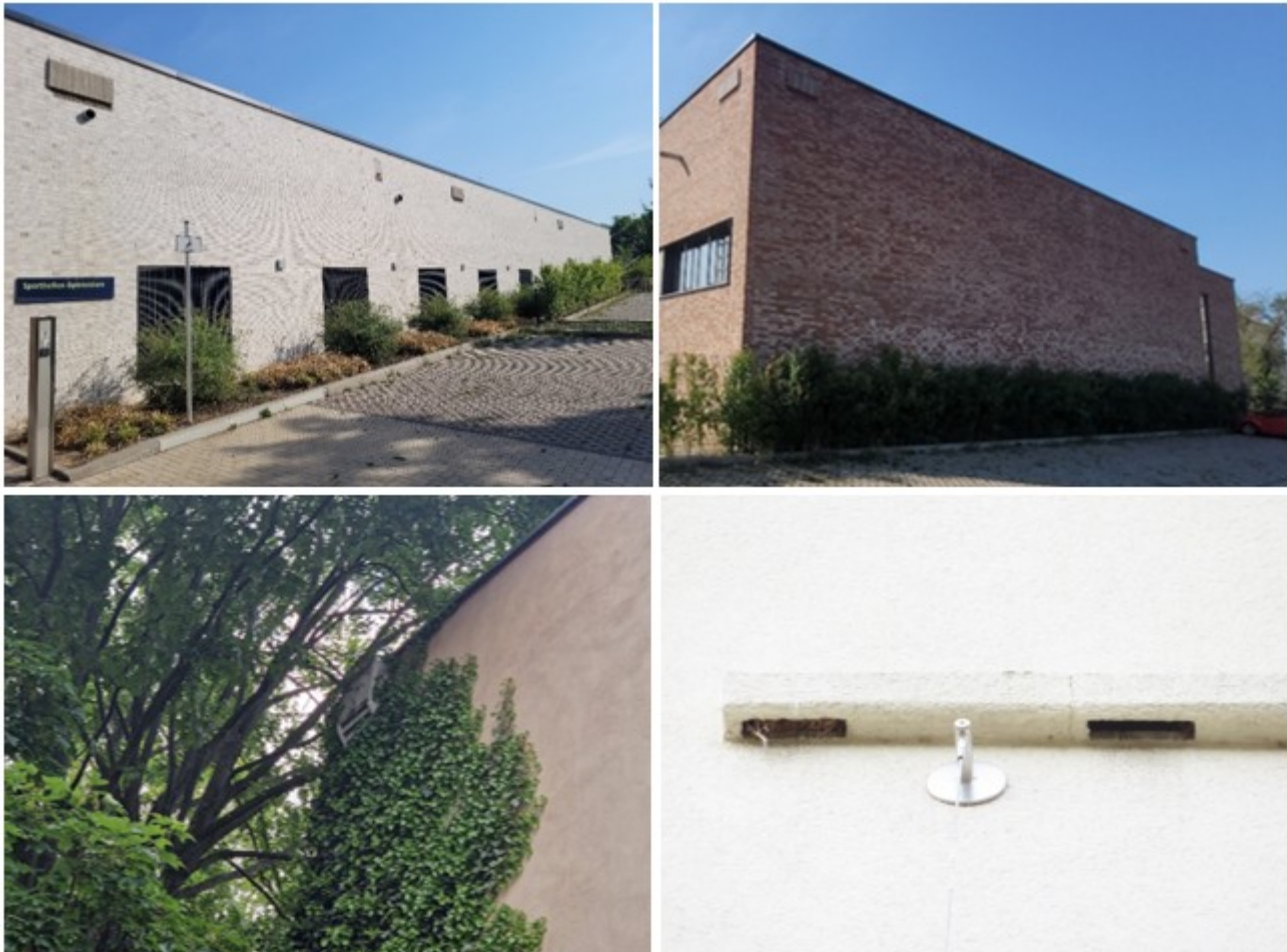
Abbildung 174: Pflanzstreifen unter Kästen verhindern Kotablagerungen am Gebäudefuß.
