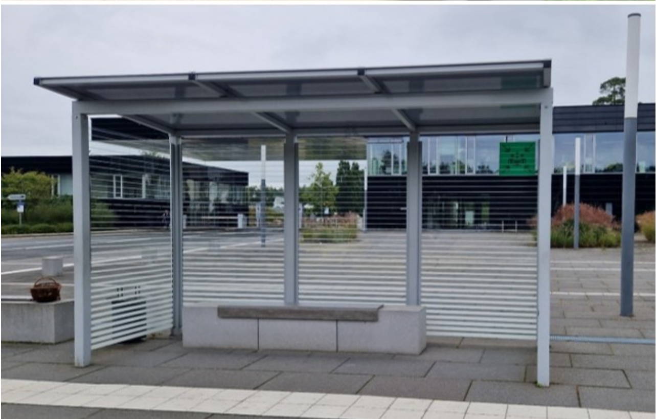
Abbildung 243: Durchsichtige Elemente wie Glasverbinderbauten, Bushaltestellen oder Balkongeländer stellen eine Kollisionsgefährdung für Vögel dar. Diese kann durch gestalterische Markierungen verhindert werden (unten).
