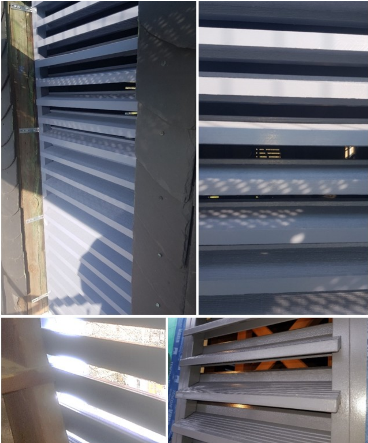
Abbildung 230: Fledermausgerechter Schalladen mit extrem rauer Holz Ausführung oder Umsetzung von Rillen sowie innerer Aufkantung gegen Wasser- und Schneeeintrag und zur Verhinderung des Eindringens von Hausstauben.
