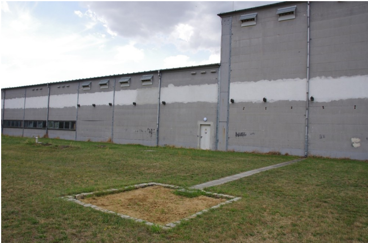
Abbildung 19: Eine Schwalbenpfütze mit Anbindung an das Fallrohr des Gebäudes verbessert die Verfügbarkeit von Niststoffen.
