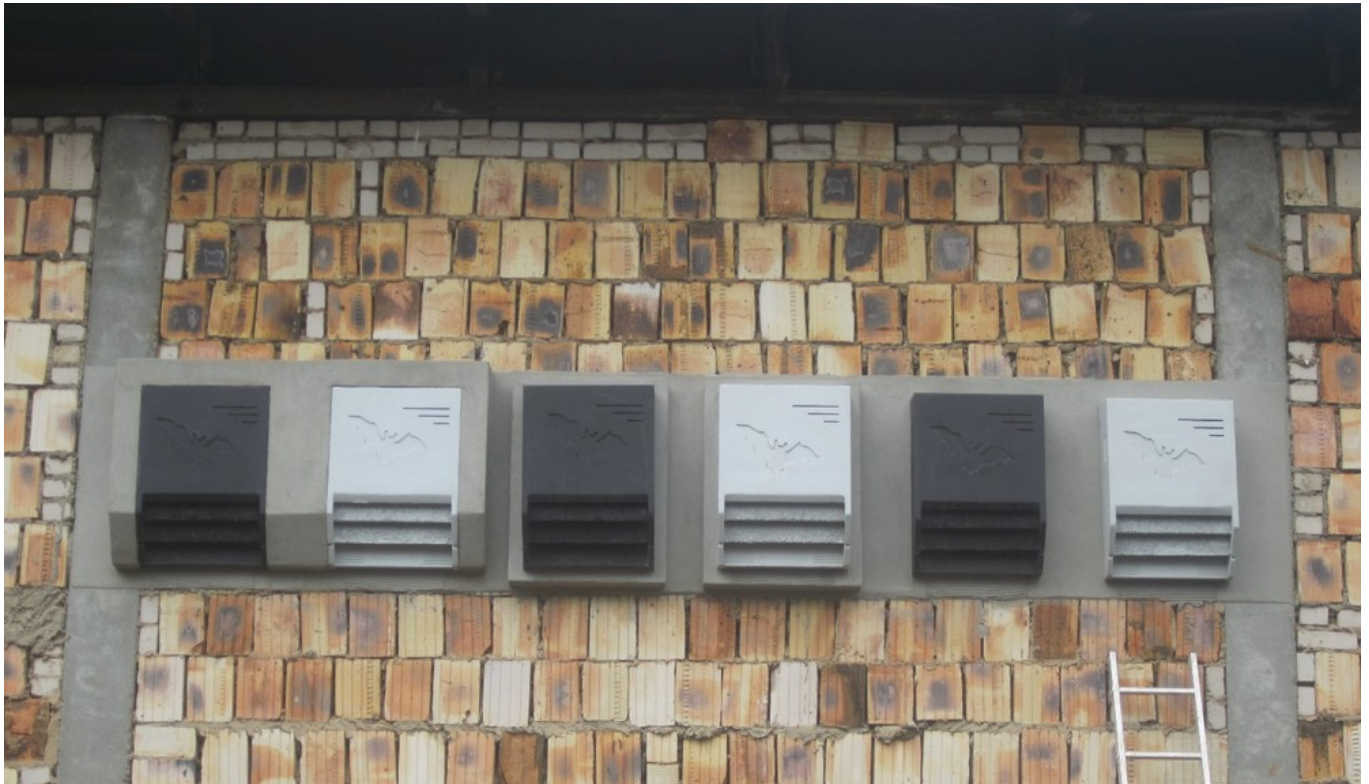
Abbildung 3: Aufnahme der Kastenordnung: links – Montage in Dämmung, Mitte – Montage auf Dämmung, rechts – Aufputzmontage.
