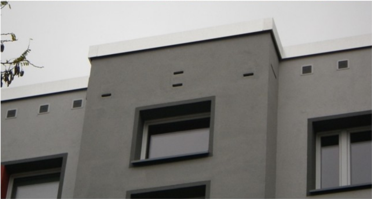
Abbildung 267: Großraumquartier mit Zugang über Grund-/Standardsteine oder Großraumeinbausteine Fa. Strobel.
