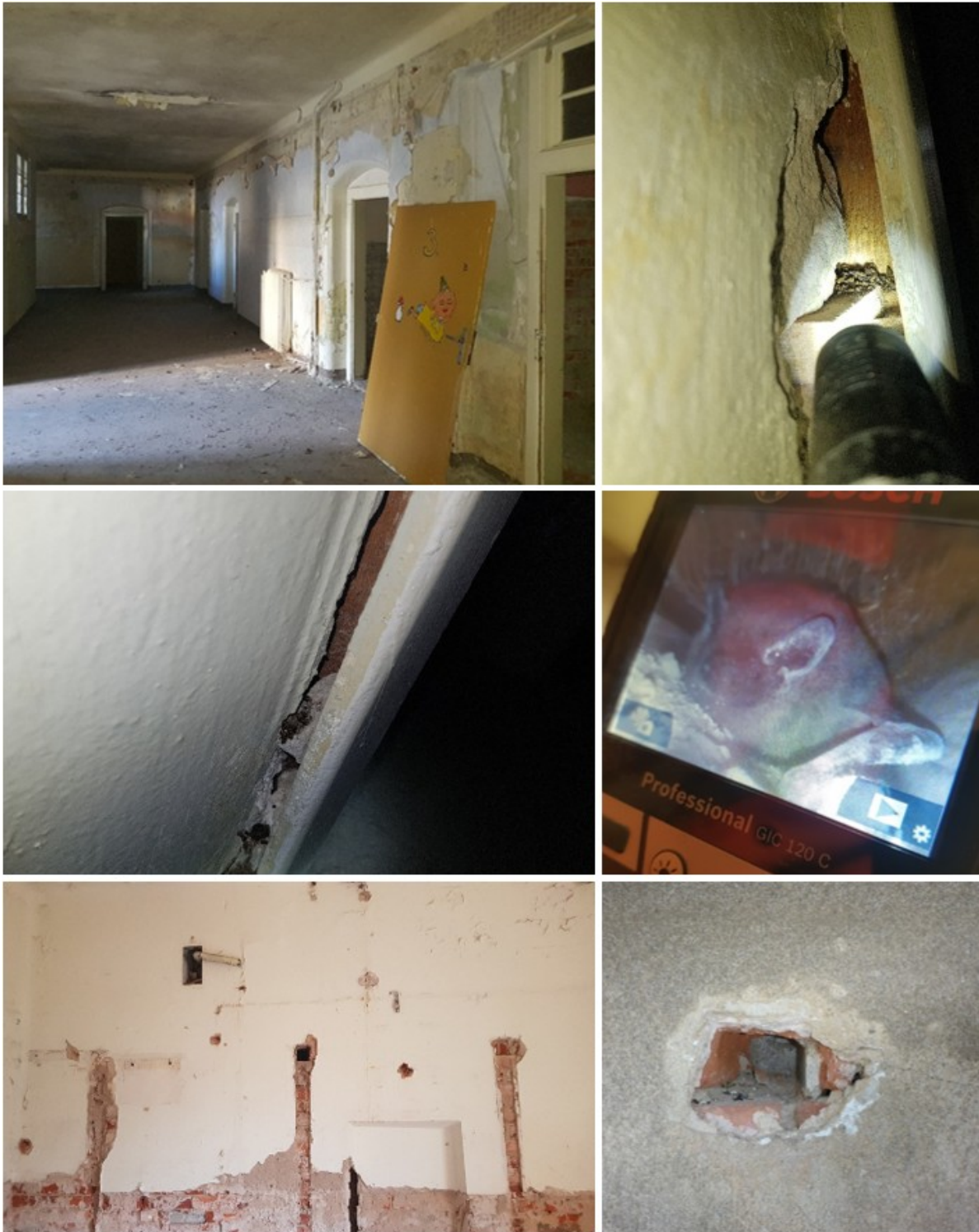
Abbildung 11: Spaltenverstecke in hellen Räumen.
