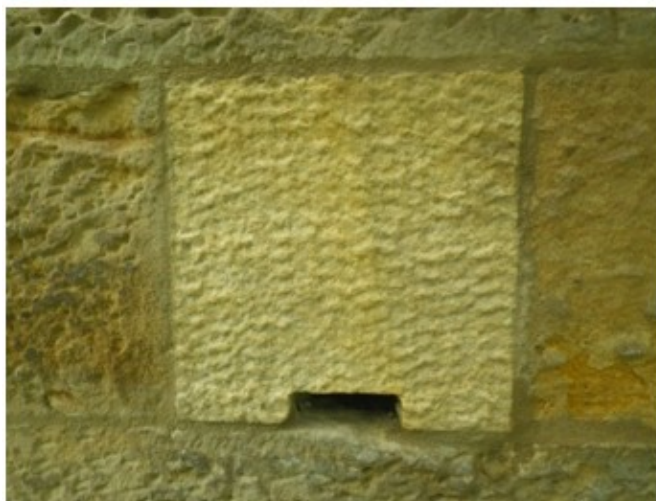
Abbildung 222: Integration von Spaltenquartieren bei der Reparatur einer Natursteinwand.
