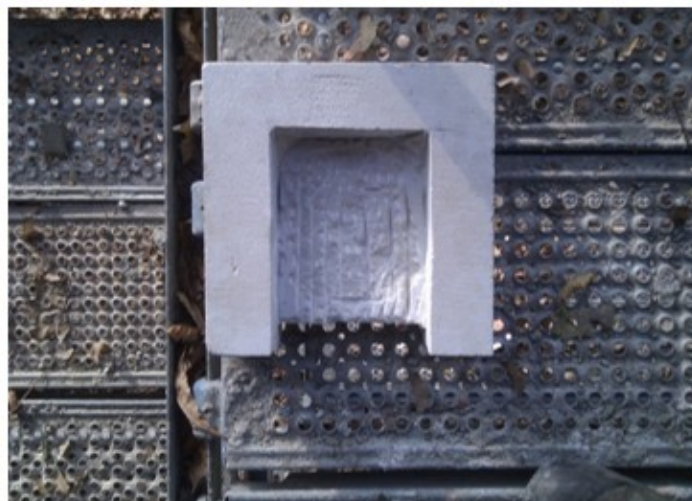
Abbildung 222: Integration von Spaltenquartieren bei der Reparatur einer Natursteinwand.
