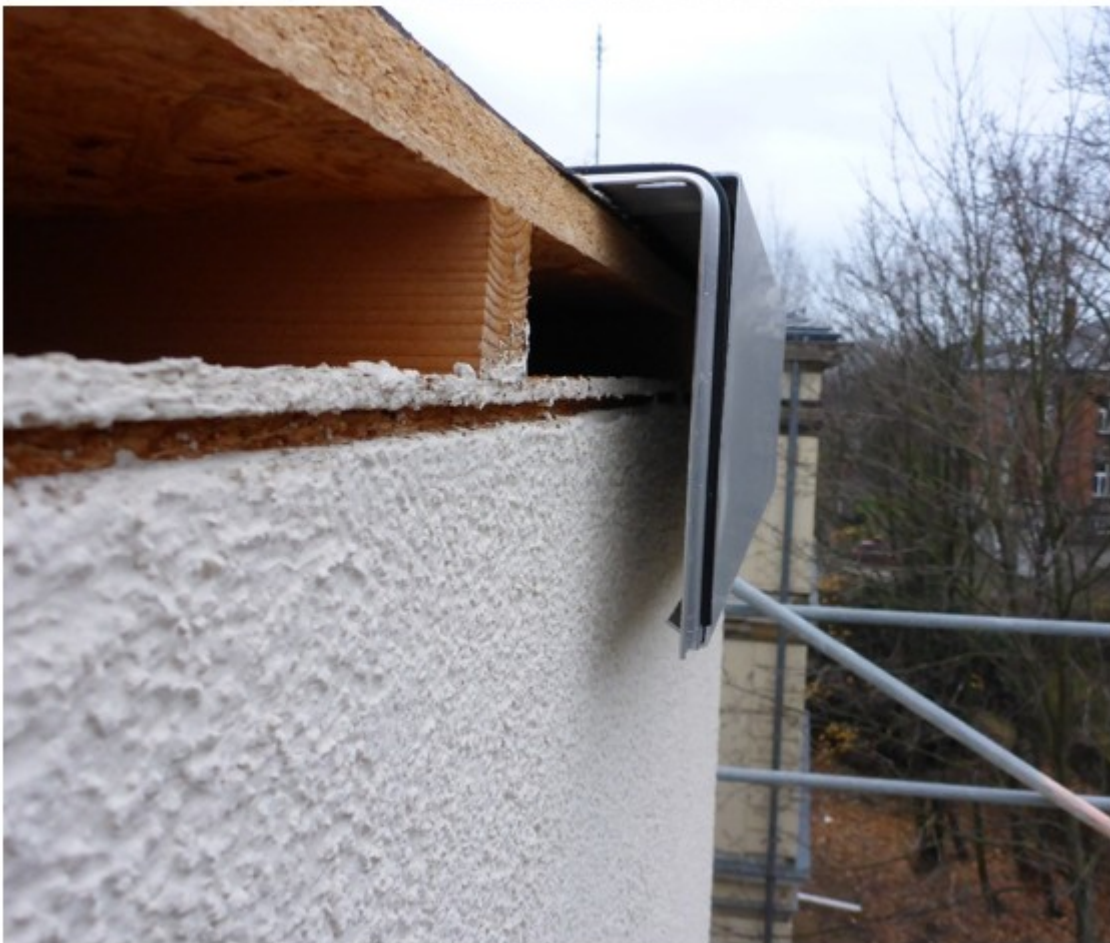
Abbildung 263: Fledermausgerechte Attikaverkleidung.
