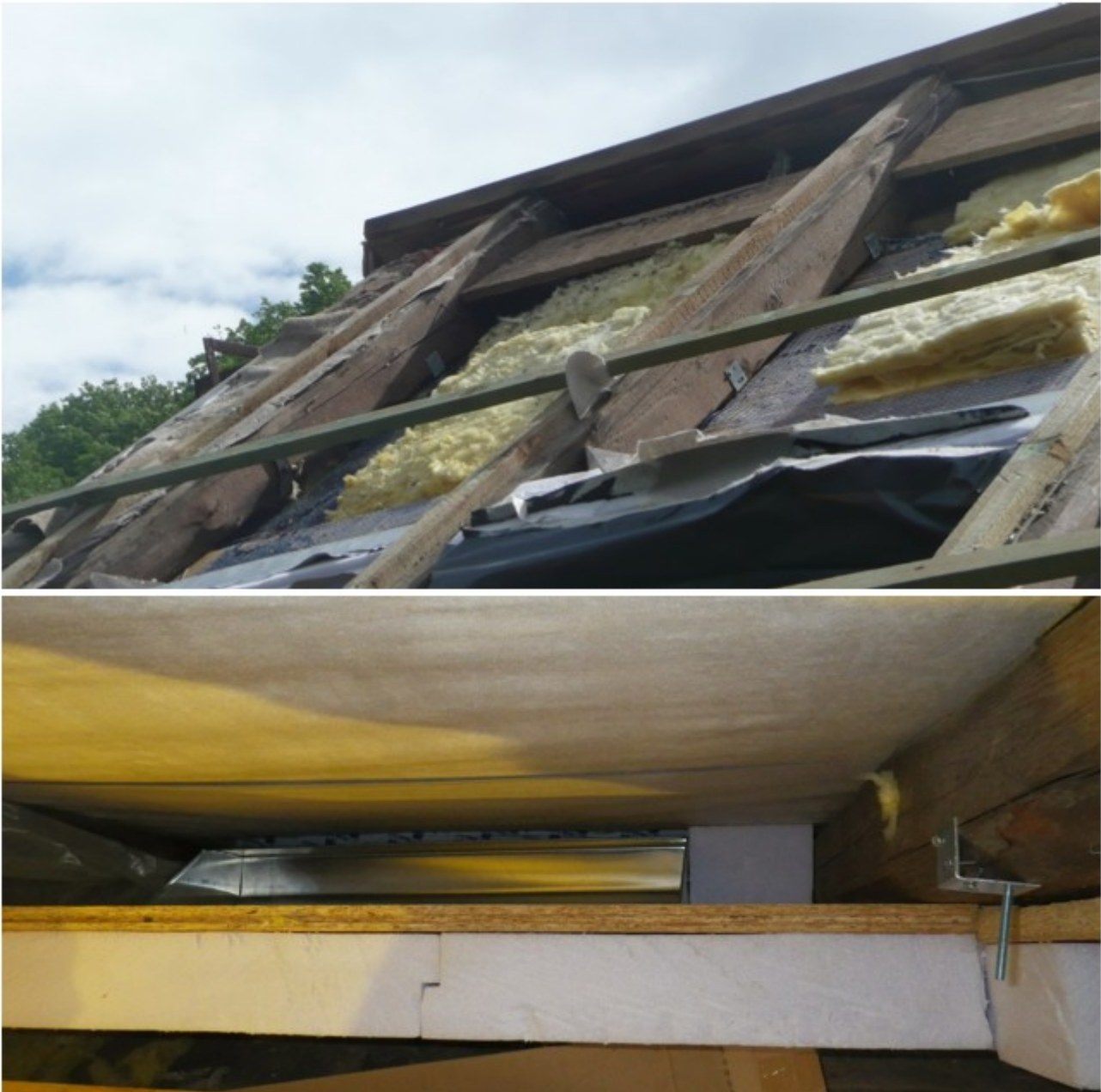
Abbildung 78: Installation von Hangplätzen bei Dachdeckung.
