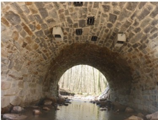
Abbildung 211: Integration von Gewölbesteinen 1GS Fa. Schwegler in eine Gewölbebrücke.
