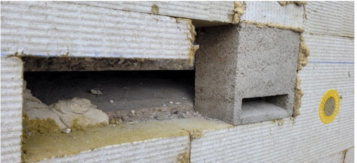
Abbildung 204: Drempel werden regelmäßig von Fledermäusen als Quartier genutzt. Der Erhalt von Einflügen kann beispielsweise über Einbausteine mit Durchschlupföffnungen erfolgen.
