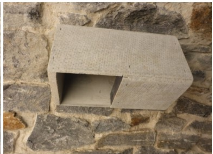
Abbildung 211: Integration von Gewölbesteinen 1GS Fa. Schwegler in eine Gewölbebrücke.
