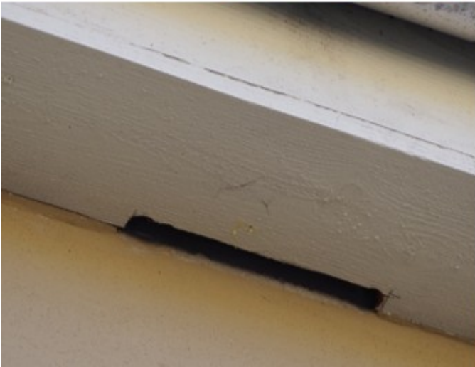
Abbildung 218: Durch die farbliche Anpassung, Integration von Einflügen in den Dachkasten und in die Wände können Lebensstätten oft relativ unauffällig integriert werden.
