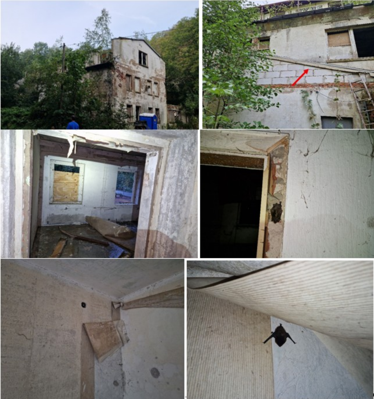
Abbildung 251: Beispiel für Fledermausquartierstellen in ruinösem Gebäude.
