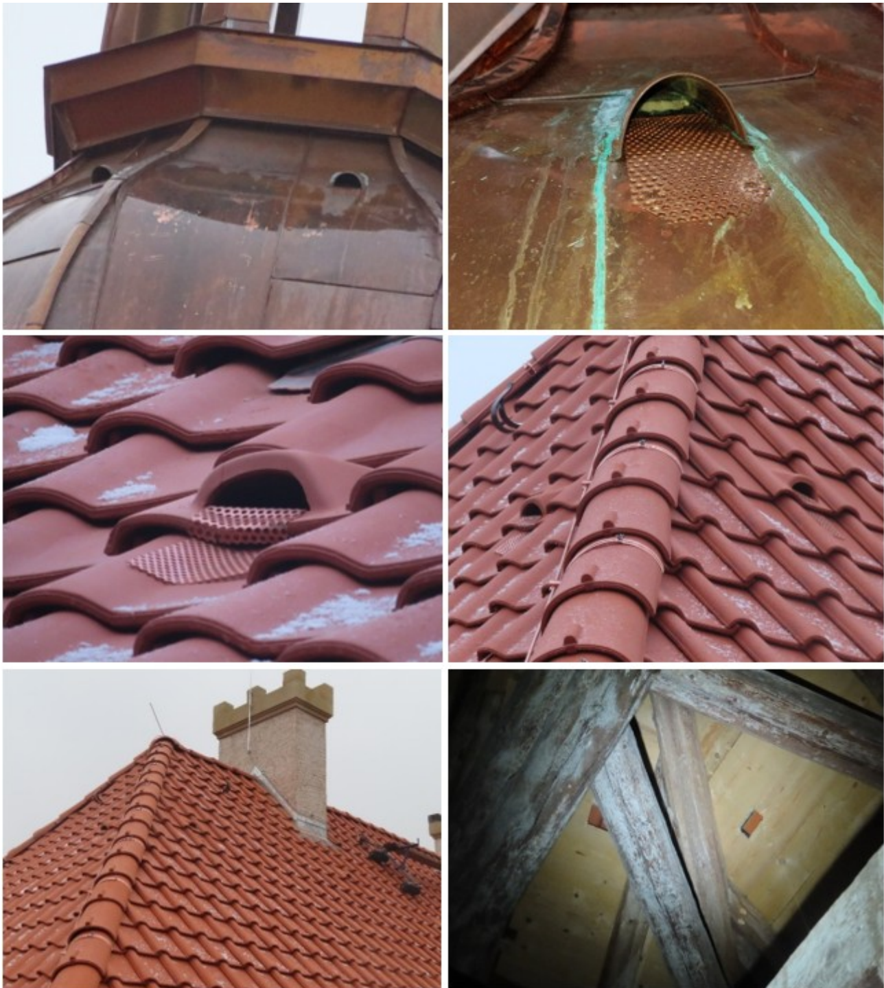
Abbildung 233: Einschlüpfе über kleine Lüftungshauben oder Lüfterziegel.
