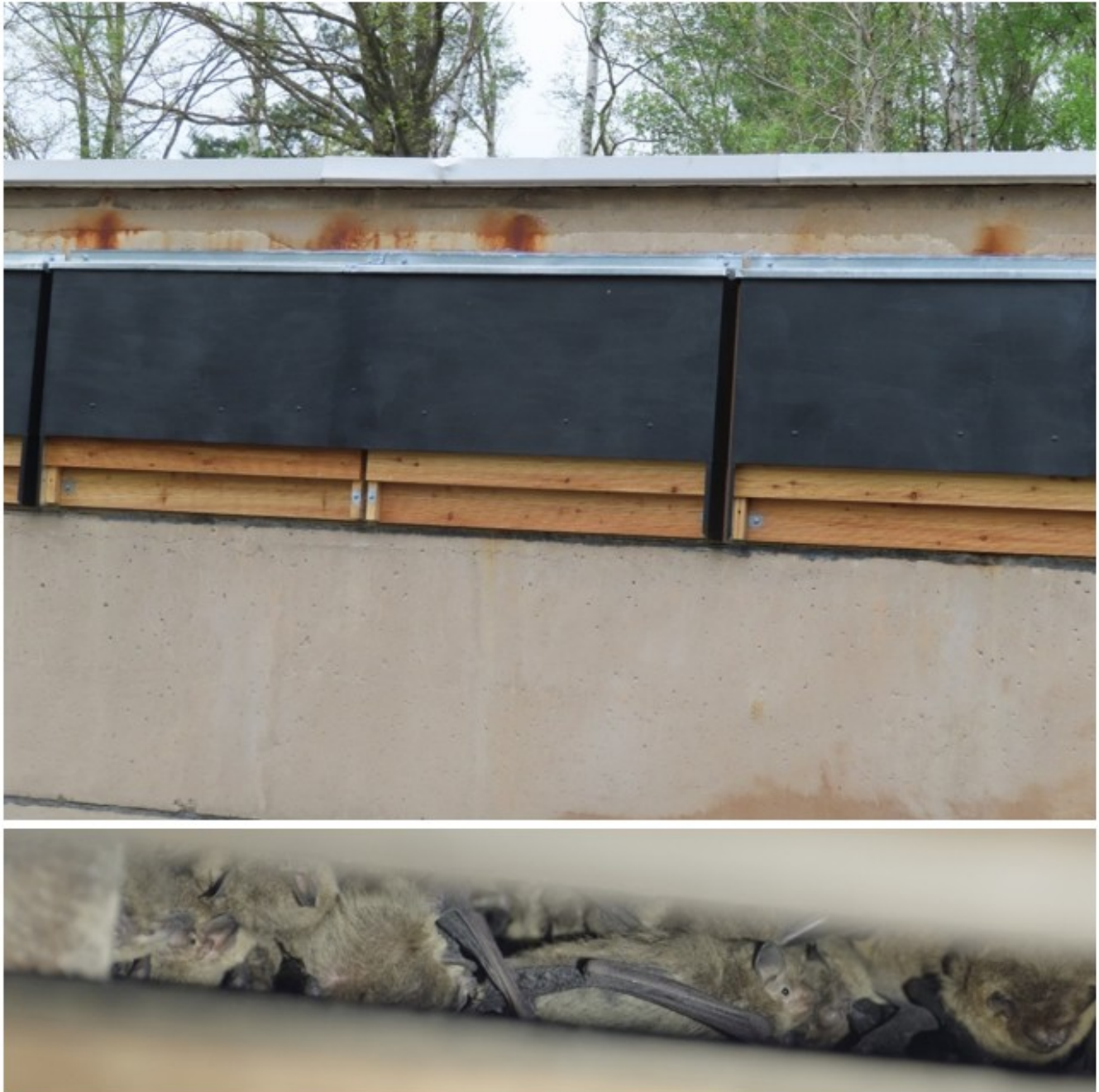
Abbildung 158: Großräumige mehrkammerige Spaltenverkleidungen sind insbesondere für den Erhalt großer Kolonien geeignet. Hier ist aber ein dauerhafter Holzschutz durch dunkle Metallverkleidungen notwendig.
