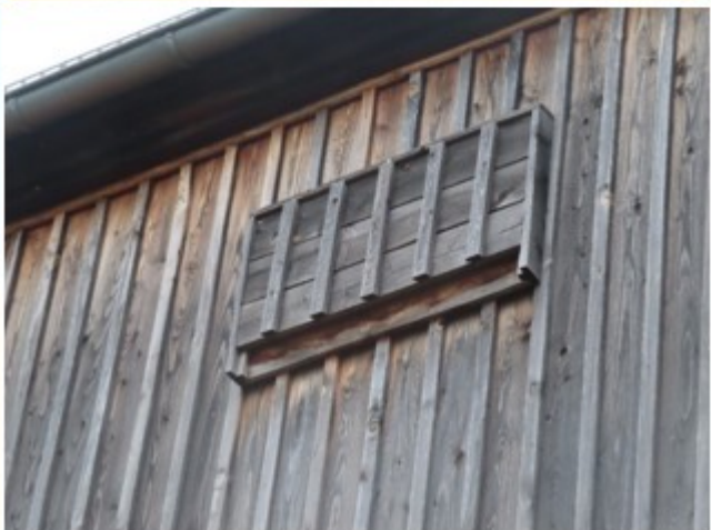
Abbildung 265: Fledermausgerechte Verkleidung / Holzverkleidung / Fledermausbrett.
