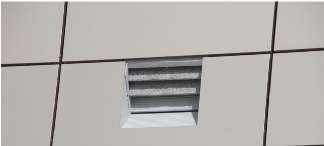
Abbildung 163: In Alucobond-Fassaden integrierte Universalquartiere 2FTH mit Grundstein der Fa. Schwegler.
