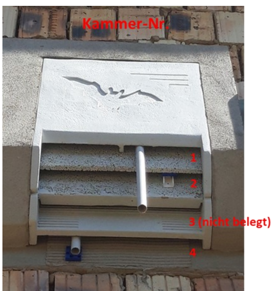
Abbildung 4: Ausbringung von jeweils drei Loggern pro Kasten.
