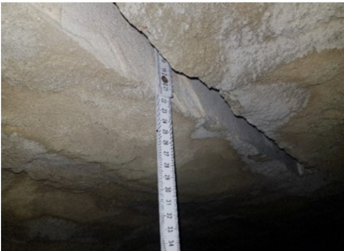
Abbildung 213: Schaffung von Spaltenquartieren an der Untersicht einer Brücke mittels Spezialschneidgerät.
