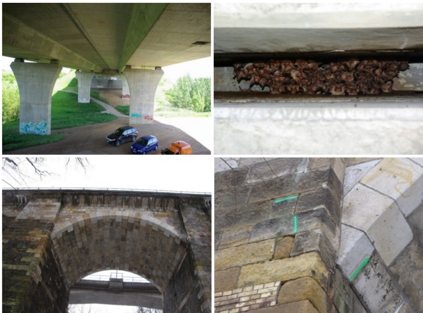
Abbildung 206: Hohe Brücken und Viadukte werden häufig von verschiedenen Fledermausarten genutzt.
