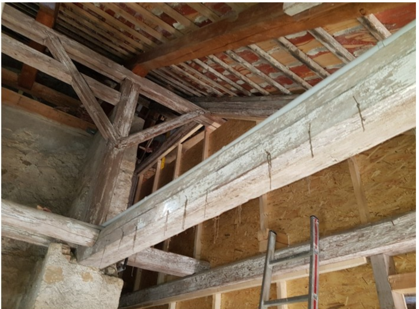
Abbildung 227: Die Abtrennung von Bauabschnitten bei Dachsanierungen ist nur bei Verwendung von festen Abtrennungsbereichen wie OSB-Platten funktional. Dabei sind Anschlussbereiche zur Dachfläche und Balkendurchdringungen zugluftdicht abzudichten.
