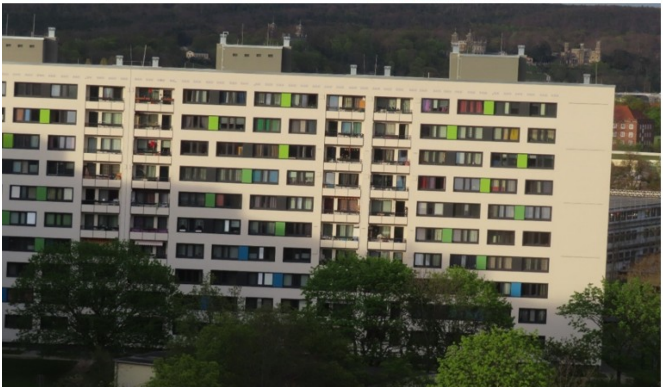
Abbildung 217: Durch Abstimmung der Anbringungsorte mit der Farbgestaltung des Gebäudes lassen sich verschieden temperierte Hangplätze schaffen, ohne dass dadurch die Optik des Gebäudes beeinträchtigt wird.
