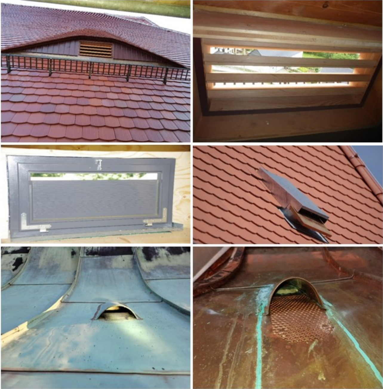
Abbildung 142: Einflüge für das Graue Langohr.
