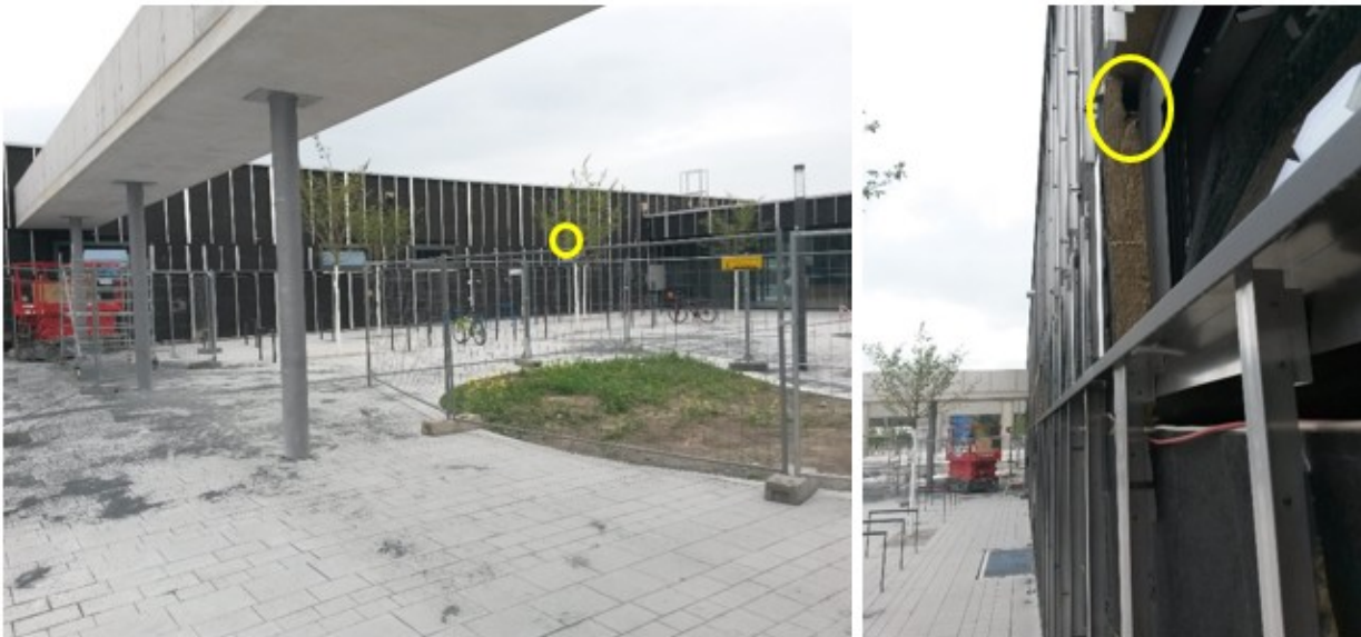
Abbildung 255: Hausrotschwanzbrutplatz in noch nicht verblendeter Dämmung an einem Neubau.
