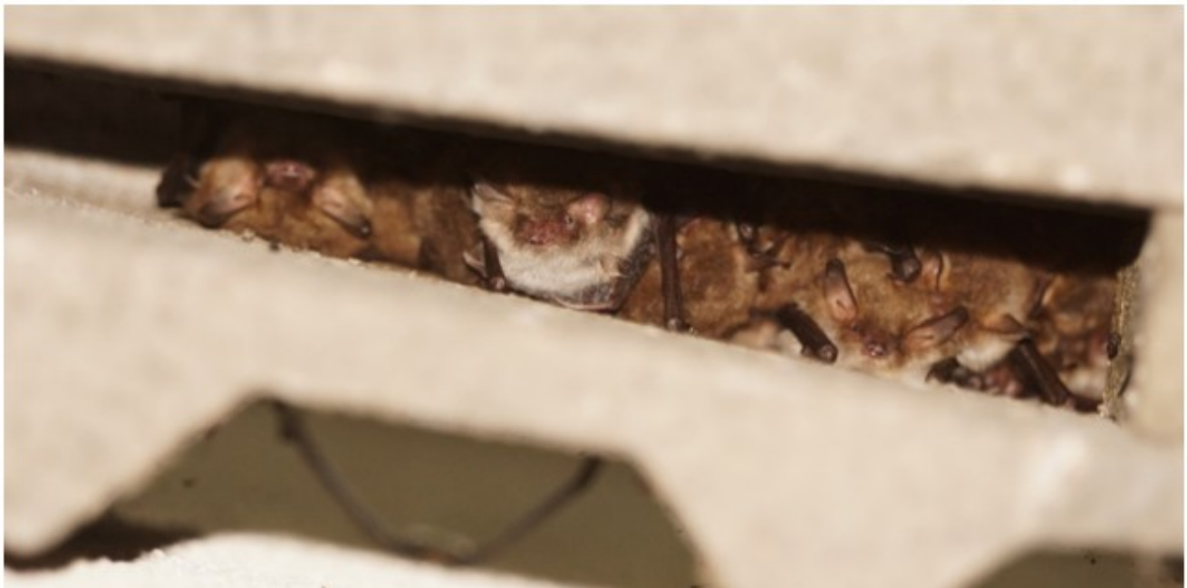
Abbildung 108: Trafoturm mit Wochenstube der Fransenfledermaus (Fotos: H. Goldberg).
