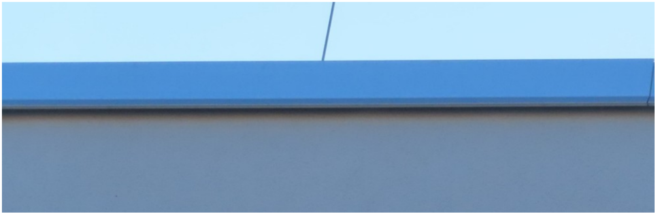
Abbildung 153: Nach außen abgewinkelte Tropfkante des Attikablechs.
