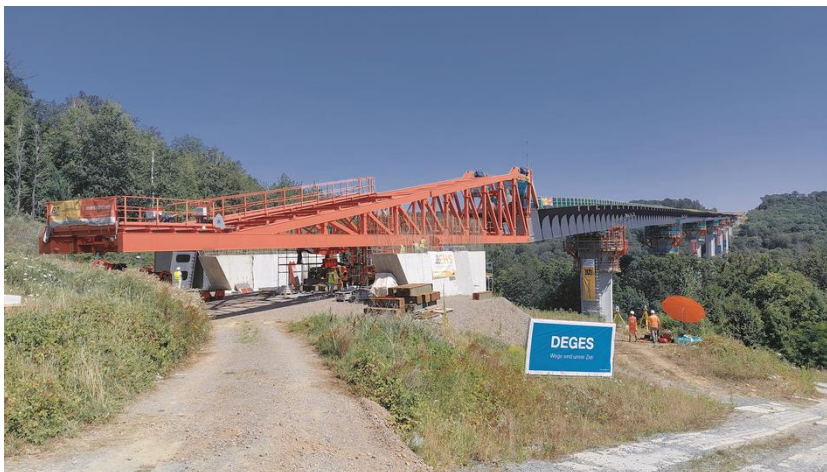
Bild 2 B 172 Überbauvershub für Gottlieb-Denkmalbrücke, (© DEGES GmbH)
