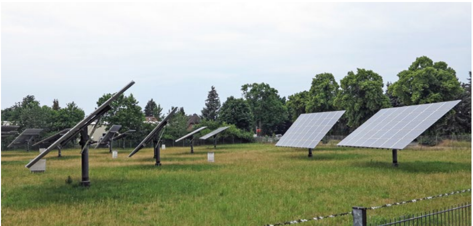
Abb. 2: Zweiachsige nachgeführte Photovoltaikanlage, Foto: Archiv Naturschutz LfULG, A. Seidel
