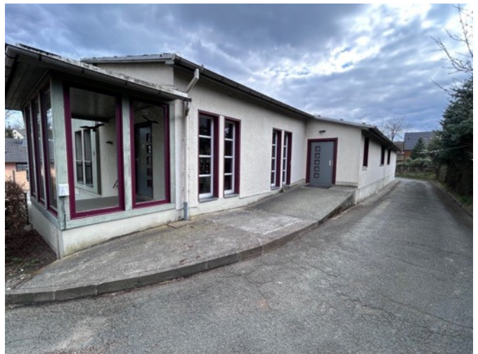
Abb. 94: Hintereingang, soll demnächst barrierearm gestaltet werden
