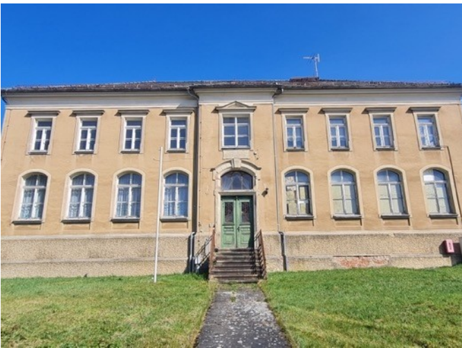
Abb. 69: Dorfgemeinschaftshaus, Ansicht von Westen
