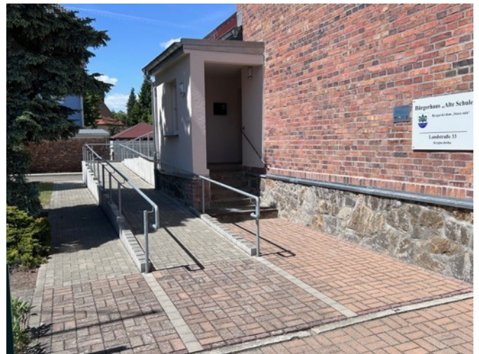
Abb. 118: barrierefreier Zugang am Haupteingang des Bürgerhauses
