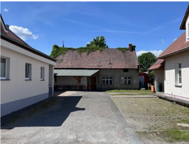
Abb. 117: Innenhof; links Bürgerhaus, mittig Lagergebäude, rechts heutiger Jugendclub
