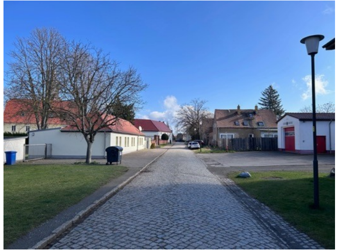
Abb. 80: Bürgerhaus im Ensemble mit Kirche und ehem. Feuerwehrrätehallen (heute Lager Dorfverein)
