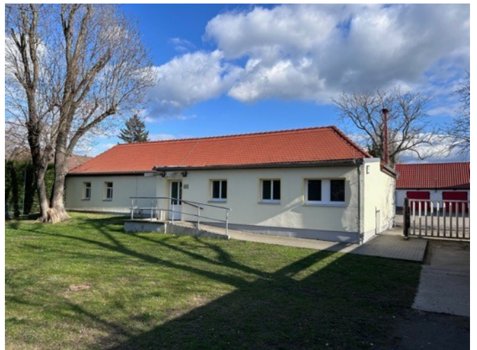
Abb. 82: Rückseite Bürgerhaus mit barrierefreiem Zugang und Innenhof
