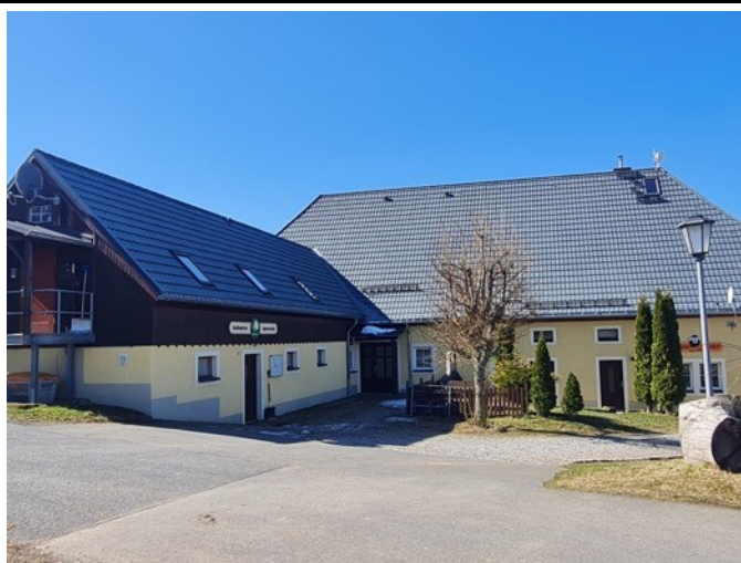
Abb. 57: Dorfgemeinschaftshaus, Ansicht von Westen
