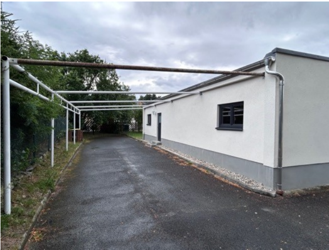
Abb. 141: rückwärtiger Bereich, Aufenthaltsbereich mit Möglichkeit der Verschattung
