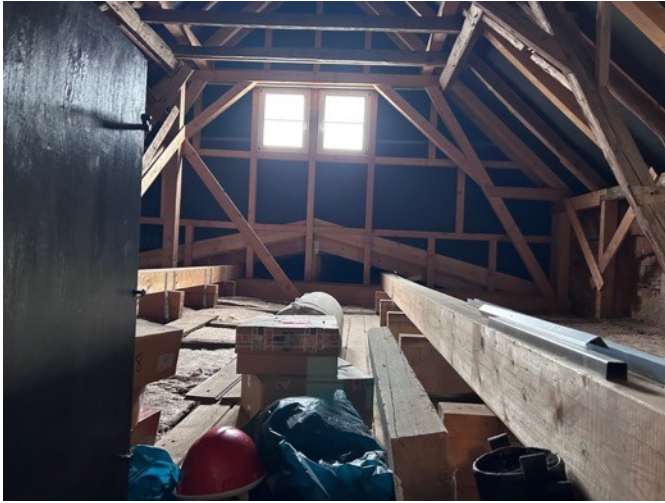
Abb. 111: Dachgeschoss „Alte Scheune“
