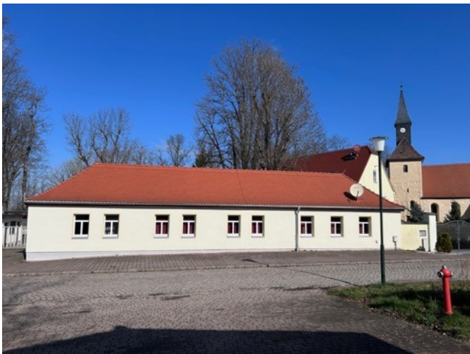
Abb. 81: Bürgerhaus, Frontansicht von Süden
