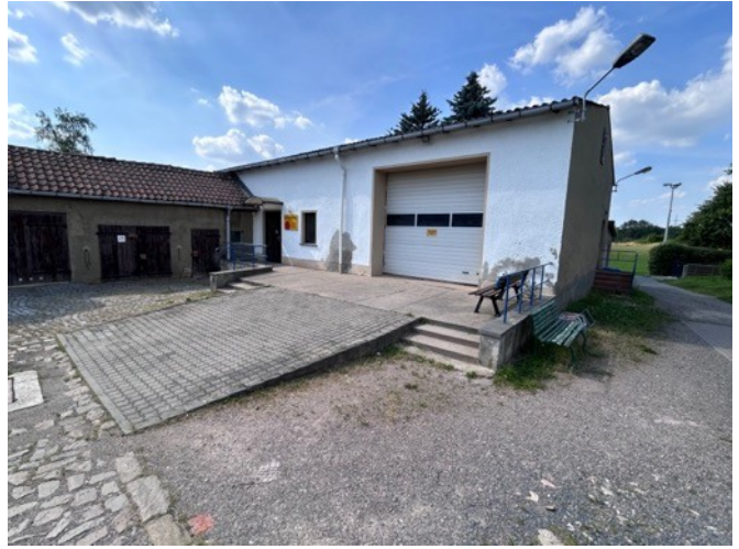
Abb. 128: Dorfgemeinschaftshaus, Ansicht von Süden, barrierefreier Zugang, Lager Heimatverein in ehem. Gerätehalle
