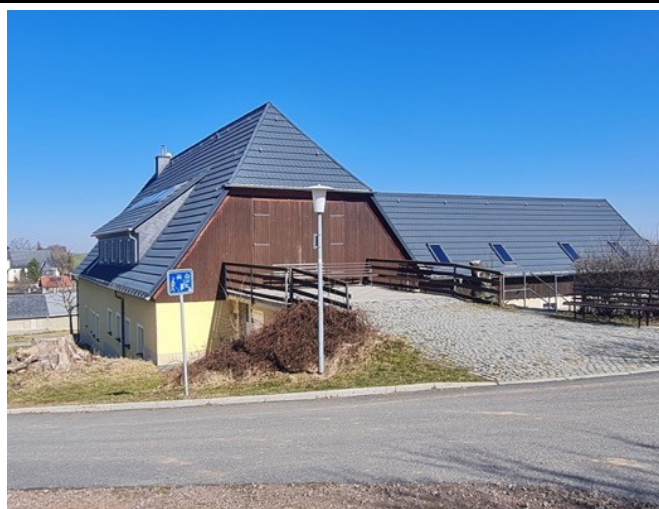
Abb. 58: Ansicht von Süden, barrierefreier Zugang zum Saal
