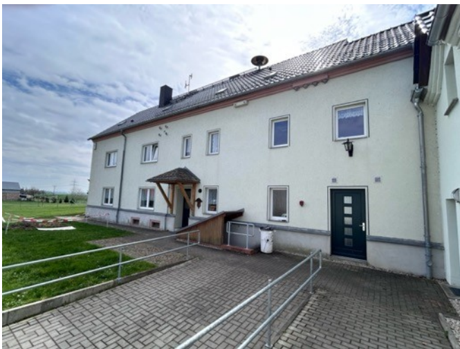
Abb. 105: Ostflügel mit Vereinsräumen (ehem. Wohnhaus)
