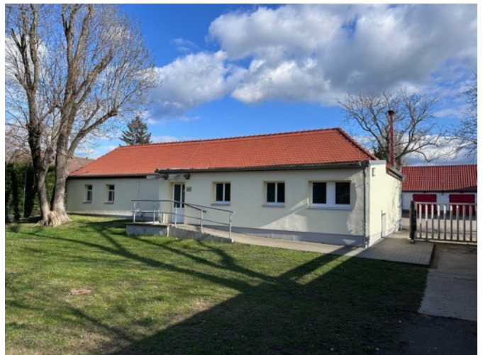
Abb. 82: Rückseite Bürgerhaus mit barrierefreiem Zugang und Innenhof
