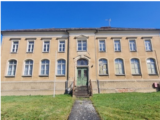
Abb. 69: Dorfgemeinschaftshaus, Ansicht von Westen
