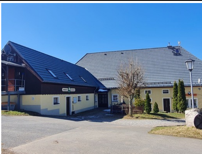
Abb. 57: Dorfgemeinschaftshaus, Ansicht von Westen
