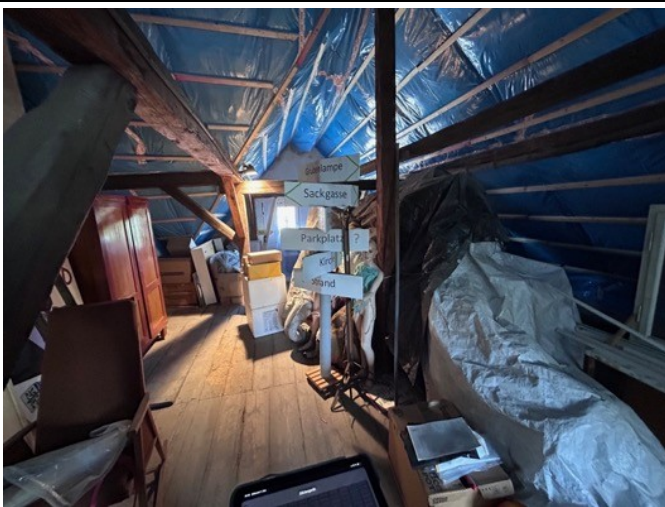
Abb. 123: DG Bürgerhaus, Lager
