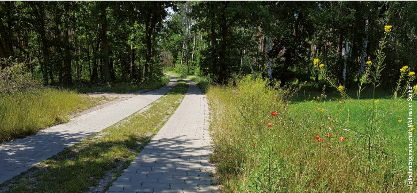
Vorher und Nachher im Vergleich: Alter Weg von Wöllnau nach Pressel (links), Beispiel eines neu gebauten Spurwegs mit Ausweichstellen im Verfahrensgebiet (rechts)
