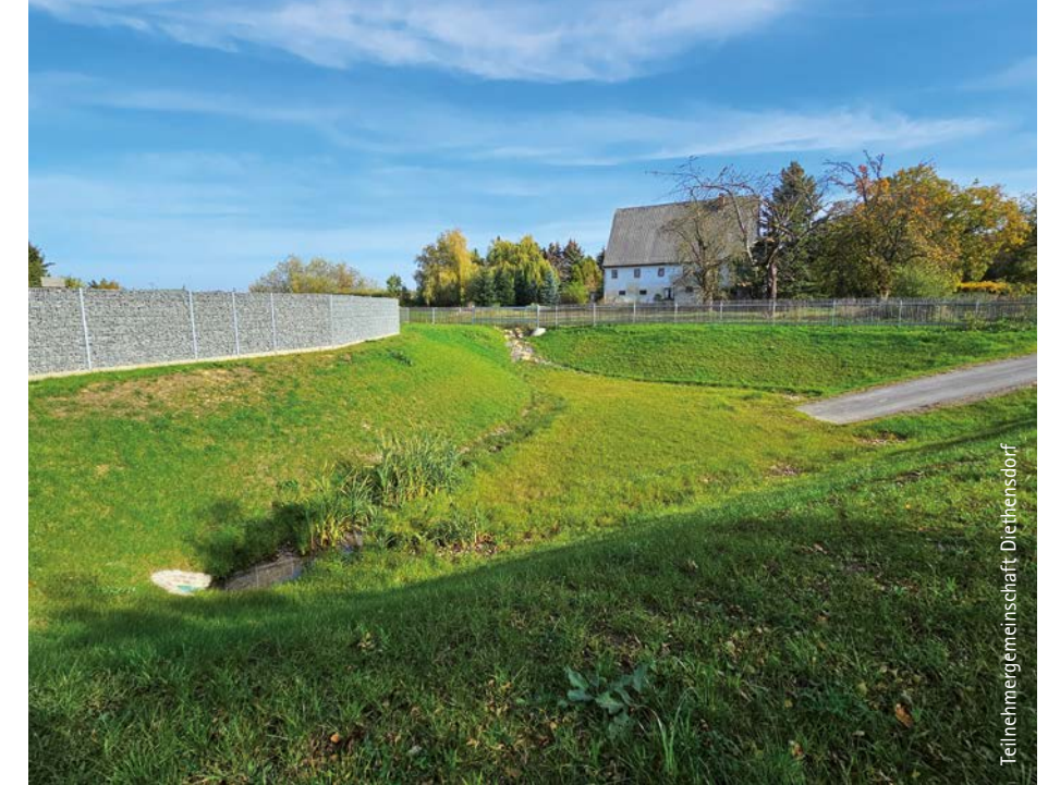
Blick auf das vergrößerte Rückhaltebecken mit Gabionenwand (oben)
