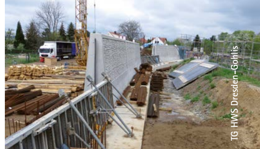
Überströmter Deich in Dresden-Gohlis 2013 (oben links); Bau einer Hochwasserschutzwand (oben rechts)
