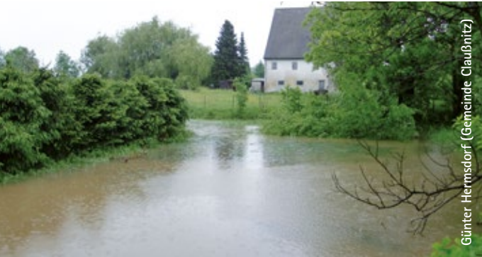
Juni-Hochwasser 2013: Feuerwehreinsatz nach dem Überlaufen des Rückhaltebeckens Eichenweg
