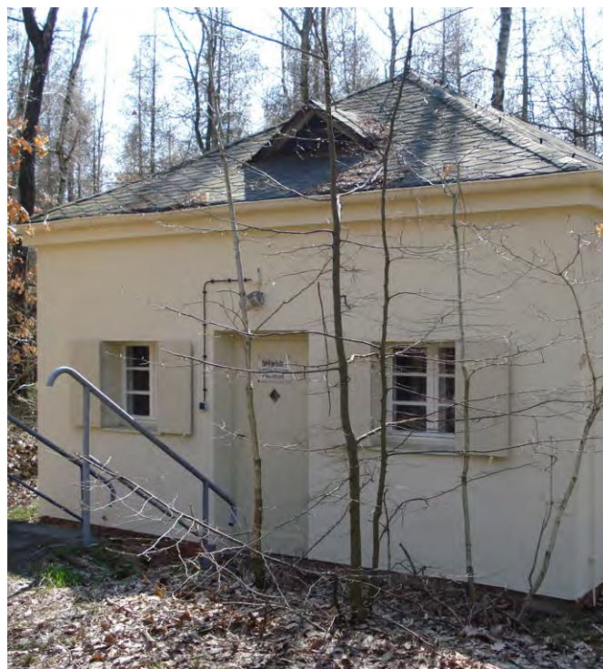
Abb. 5.1-6: Erdbebenwarte (Seismometer-Haus). 1934 gebaut steht es im Gelände des Observatoriums und beherbergt den Wiechert-Seismografen sowie weitere historische Seismometer.
