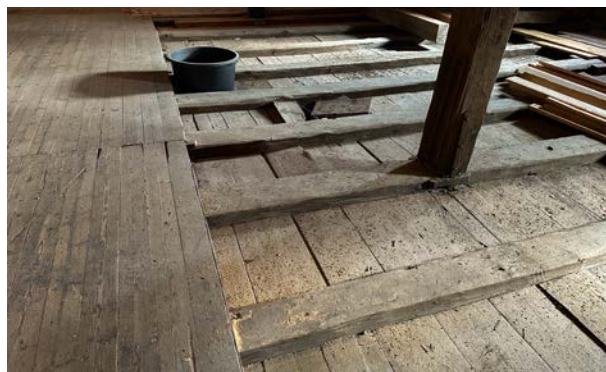
Originaler Fehlboden mit gefälzten Einschubbrettern, darüber gedielter Laufgang
