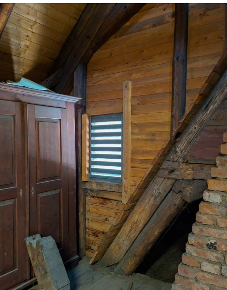
Kirche, Dachbelüftung über Lamelleneinsatz statt Verglasung
