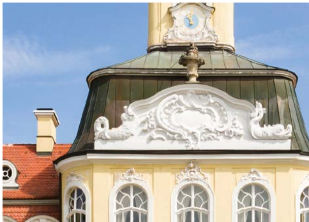
Leipzig, Gohliser Schlösschen, Kupferdach auf Mittelrisalit
