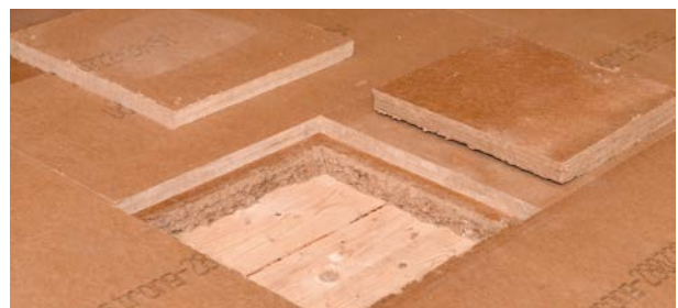
Versuchsfeld 4, Holzfaserplatte trittfest auf der Dielung aufliegend
