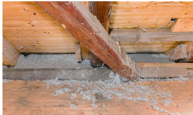
Mit Einblasdämmung verschlossener Traufbereich
