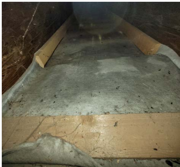
Rieselschutzvlies auf der Deckenoberseite
