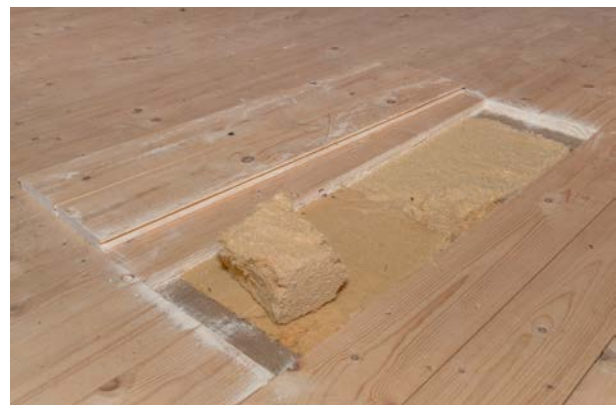
Versuchsfeld 2, Holzweichfaserplatte im Balkenzwischenraum
