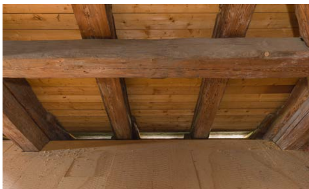
Fußpunkt des Daches mit Trauföffnung, nur an der Südseite vorhanden
