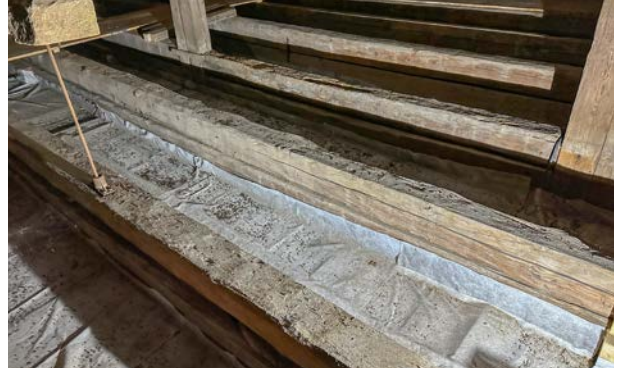
Rieselschutzvlies auf der Deckenoberseite
