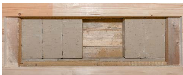
Versuchsfeld 6, Massivlehmsteine mit Lehmbauplatte im Balkenzwischenraum
