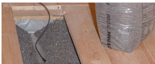
Versuchsfeld 5, Bläschieferschüttung über Rieselschutzvlies im Balkenzwischenraum
