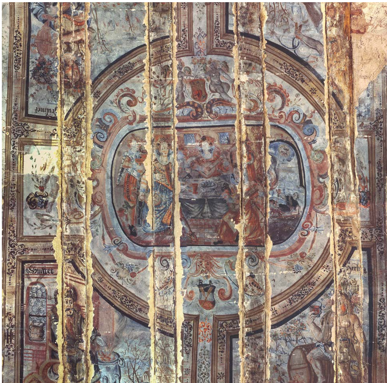
Eilenburg, Gasthof Zum Roten Hirsch, Lehmdecke mit typischen Fassungsverlusten entlang der Balkenlage
