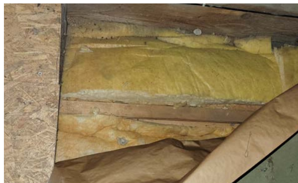
Mineralwolle-Dämmung im Balkenzwischenraum
