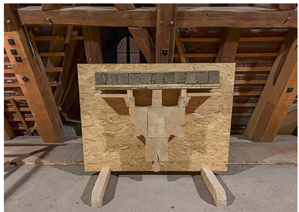
Meißen, Albrechtsburg, Mittelbau, Schautafel zum Deckenaufbau mit Leichtlehmauflage
