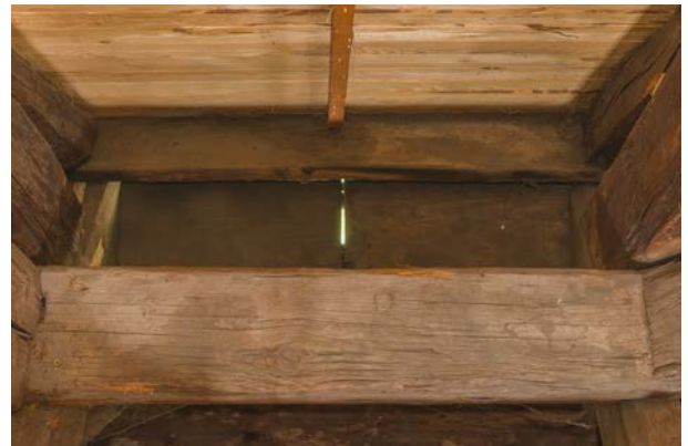
Kirche, Dach mit verschlossener Trauflüftung
