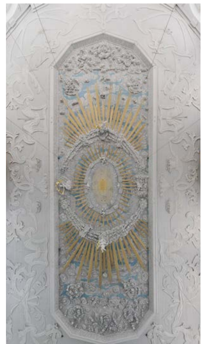
Schwarzenberg, St. Georgenkirche, Stuckdekorimitation aus Holzschnitzelementen
