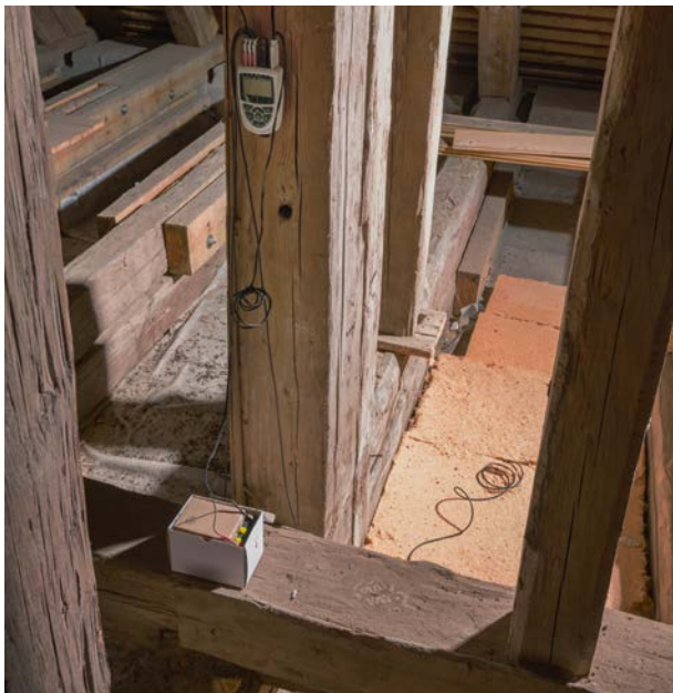
Links Rieselschutzvlies, rechts Holzweichfaserdämmung
