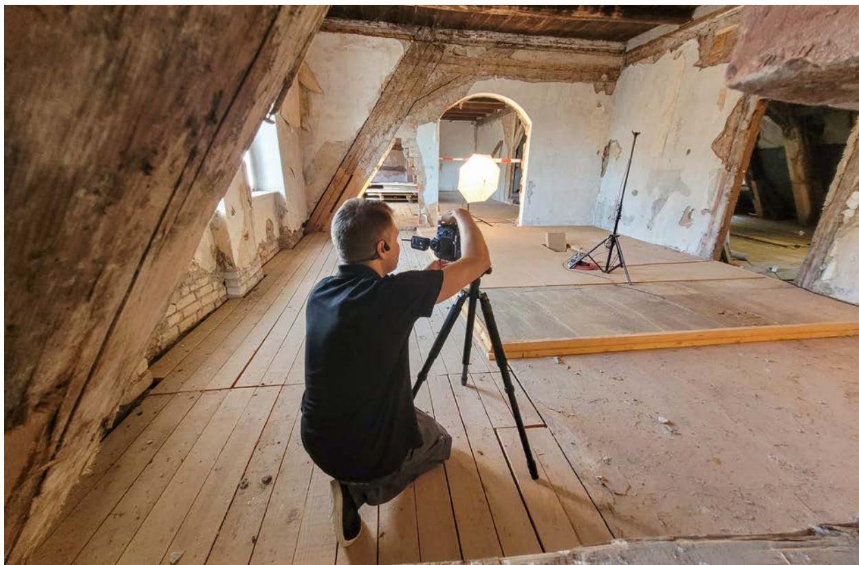
Versuchsaufbau Deckenoberseite mit unterschiedlich gedämmten Testfeldern, Aufnahme bei der fotografischen Dokumentation für die Handreichung
