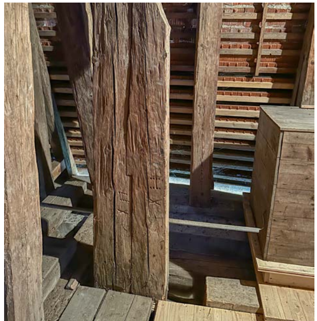
Detail Hängewerk, Trauflüftung, vermörtelte Ziegeldeckung auf Lattung
