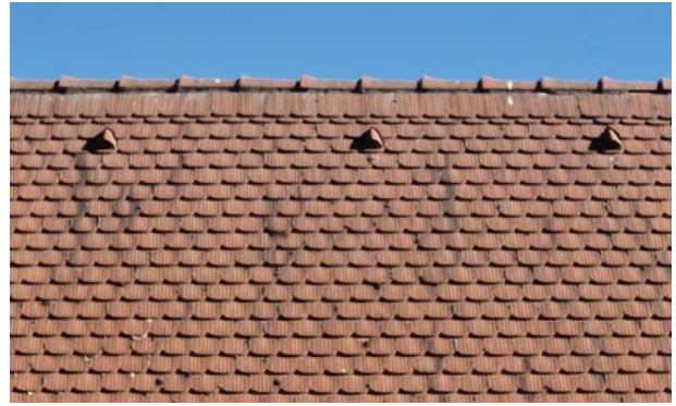
Lüfterziegel entlang eines Firsts
