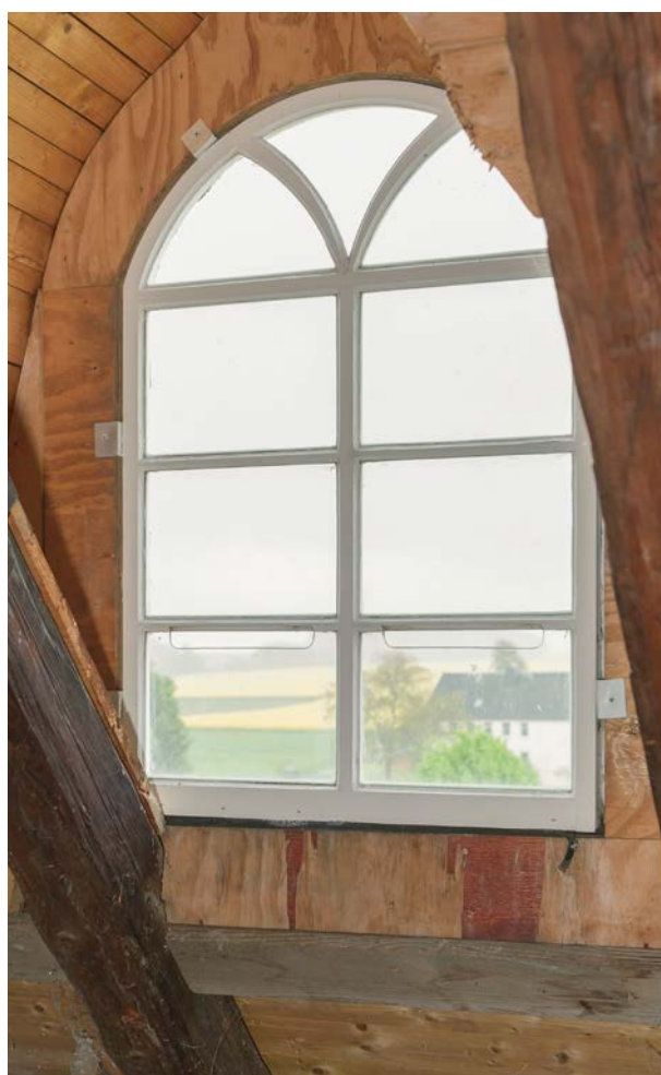
Kirche, Dachbelüftung über Lüftungsschlitze in der Verglasung
