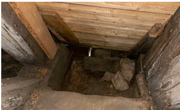
Dachfuß mit schmaler Trauflüftung
