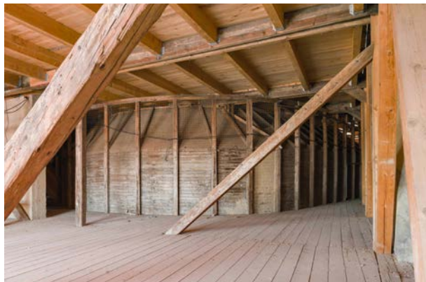
Dachboden mit Dielung und Holztonnengewölbe
