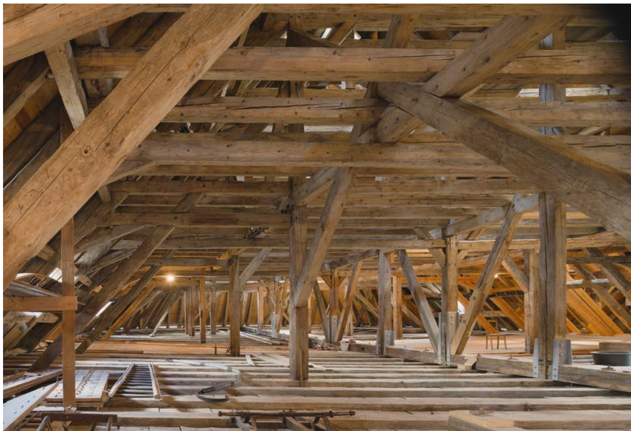
Weitläufiger Dachboden mit historischer Dielung, umlaufende Trauflüftung mit Lüftungsgittern und Schalung unter der Schieferdeckung
