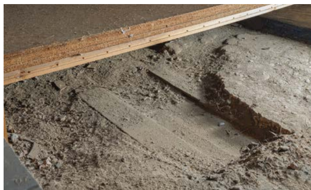
Bauzeitlicher Kalk-/Ziegelsplittestrich auf Deckenoberseite
