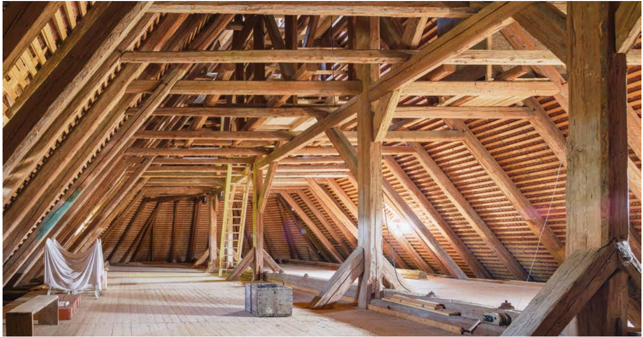
Dachboden, gedielt, Sparrendach mit Mittellängsverband und Überzug
