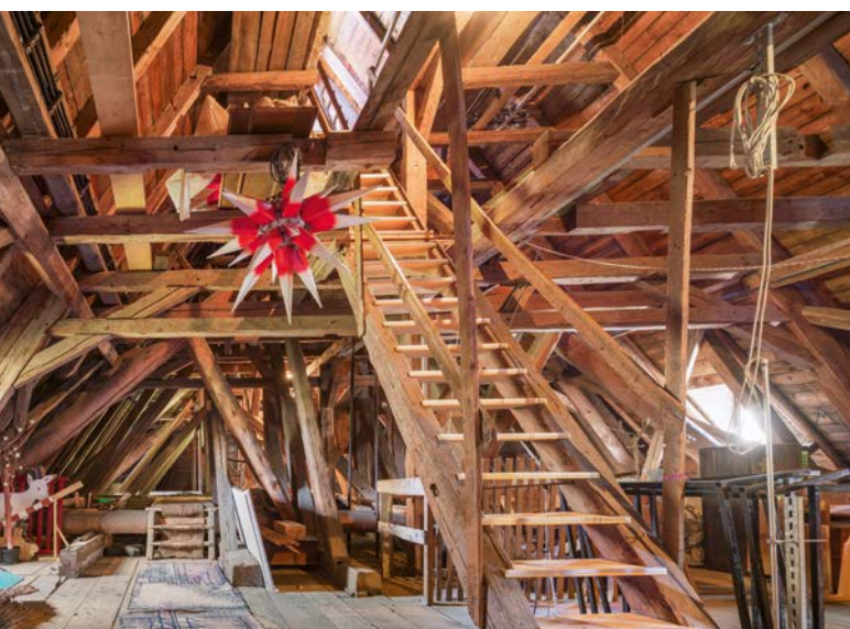
Dachboden einer Dorfkirche mit dichter Tragkonstruktion
