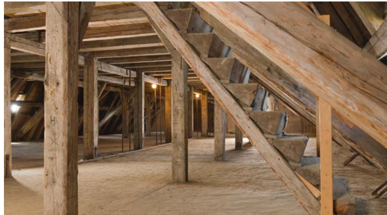
Penig, Stadtkirche, Dachboden mit Lehmschlag auf Dielung
