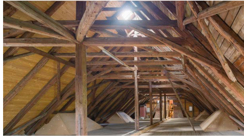
Gedielter Dachboden, Schalung, gedämmte Fensterkuppeln
