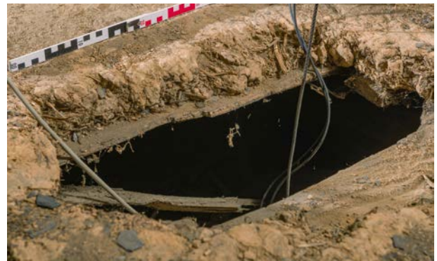
Bauzeitlicher Lehm Schlag auf Dielung
