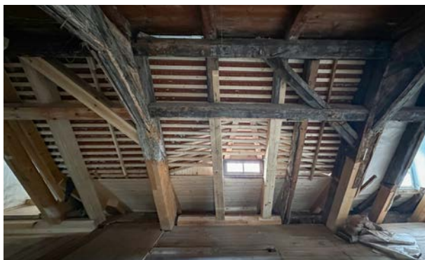
Dachboden mit Ziegeldeckung auf Lattung
