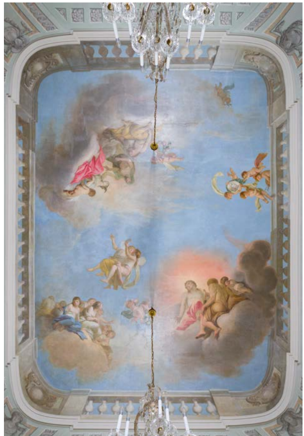
Leipzig, Gohliser Schlösschen, Oesersaal, Deckenuntersicht
