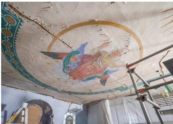
Bockendorf, Kirche, setzen von Kohlefaserrovingen zur Rückverankerung der Putzschale und anschließendes Abstützen
