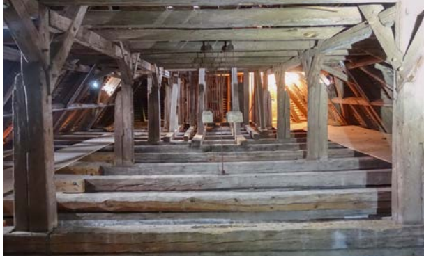
Dachboden, doppelte Balkenlage, keine Dielung
