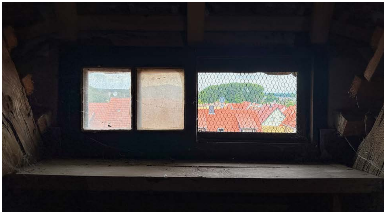
Kirche, Dachbelüftung über Fenster, mit Maschendraht geschützt
