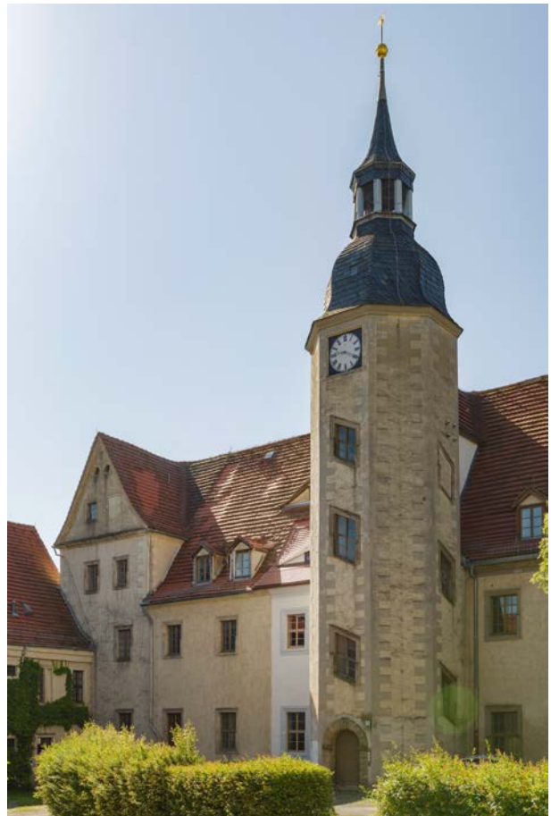
Nossen, Schloss, Südflügel, Außenansicht
