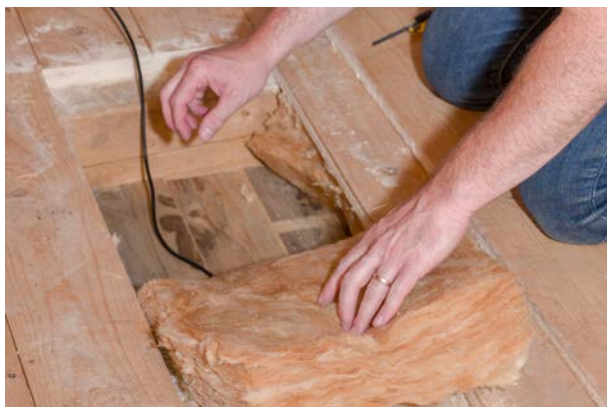
Versuchsfeld 3, Mineralwolle im Balkenzwischenraum
