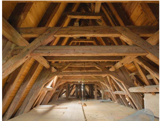
Dachboden im Chorbereich mit Laufgang und Dämmung, darüber Maschendraht
