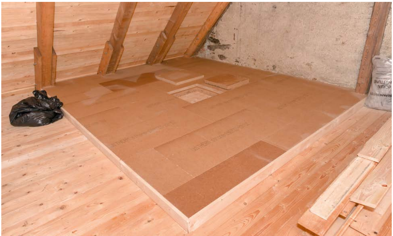
Versuchsfeld über einer Testzelle mit Holzfaserdämmung auf der Deckenoberseite
