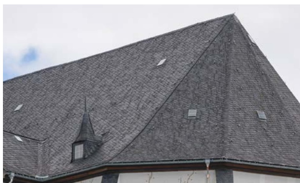
Schieferdeckung ohne Lüfterziegel, Schiebefenster mit Bedarfsöffnung
