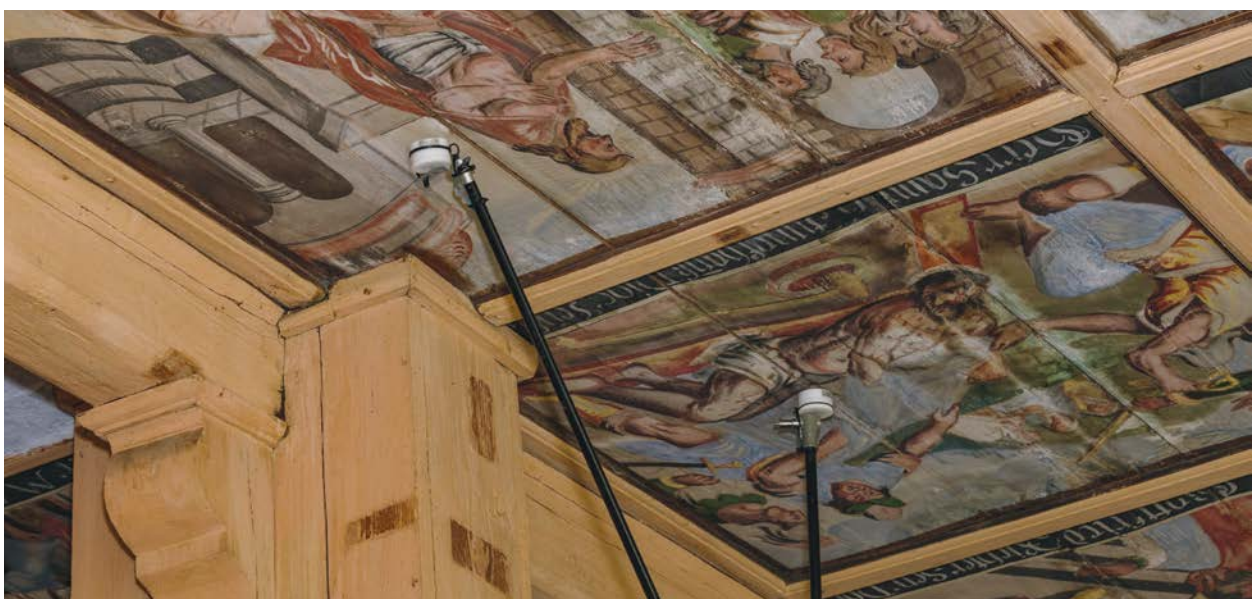
Deckenunterseite, laufende Klimaauzeichnung mit jeweils einem Sensor für die Bereiche unter der Dämmung und dem Rieselschutzvlies
