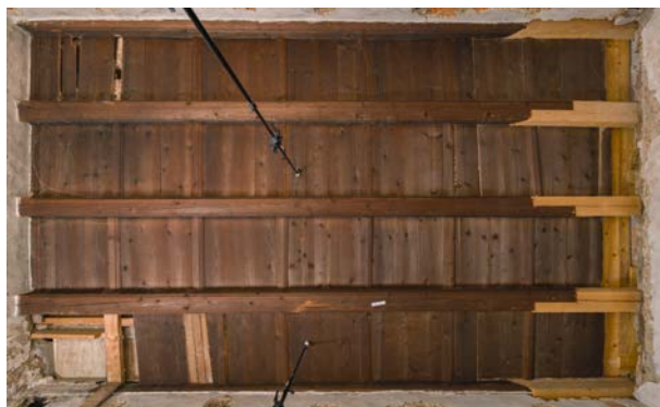
Nossen, Schloss, Deckenuntersicht mit Messtechnik
