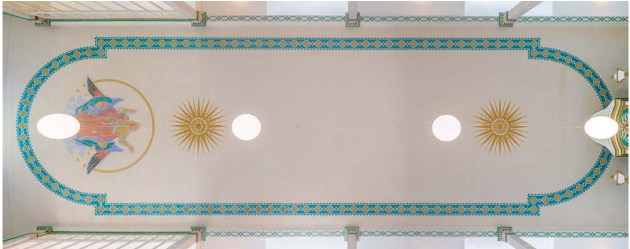
Bockendorf, Kirche, Deckenputz nach Restaurierung
