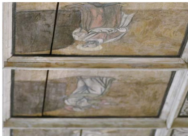
Löbnitz, Kirche, Deckenuntersicht mit durchlaufenden Brett-fugen
